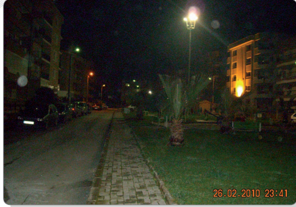
Hasan Kara Parkı Aydınlatması
