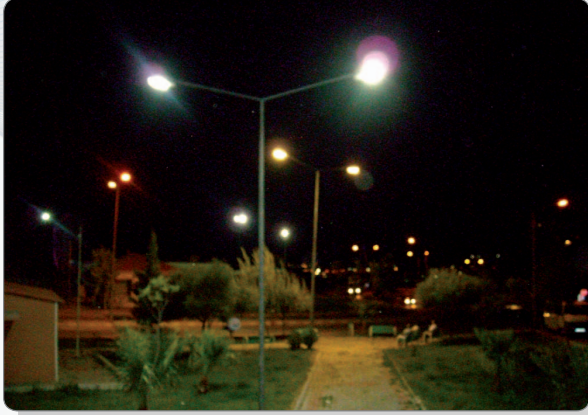
Evka- 7 Muhtarlık Yanı Park Alanı Aydınlatması
