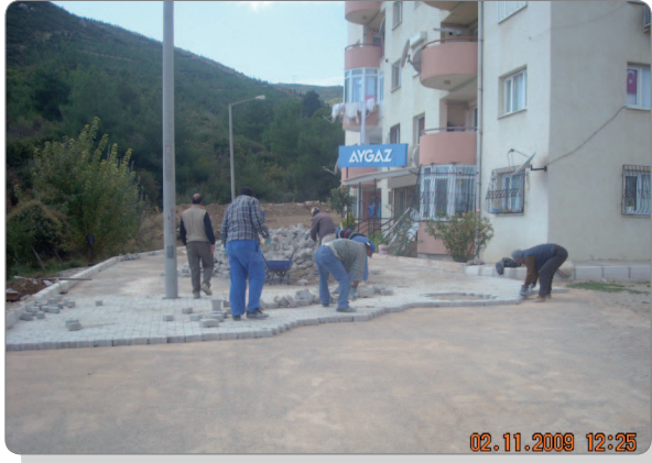
Evka-7 803 Sokak Yol Açımı, Reglaj Çalışması ve Tretuar Yapımı
