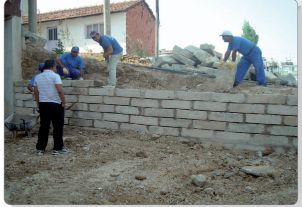
S.Ergin Cad. Sonu 107 Sokak İstinat Duvarı Yapımı
