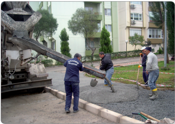
657 Sokak Şirinler Parkı Yolu Kaldırım Beton Dökümü
