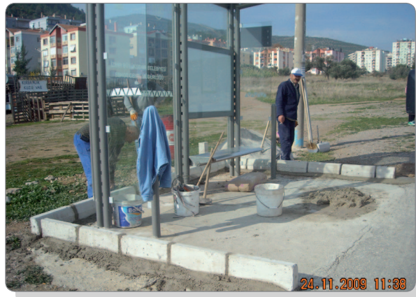
Evka-7 805 Sokak Yol Reglaj Çalışması ve Tretuar Yapımı
