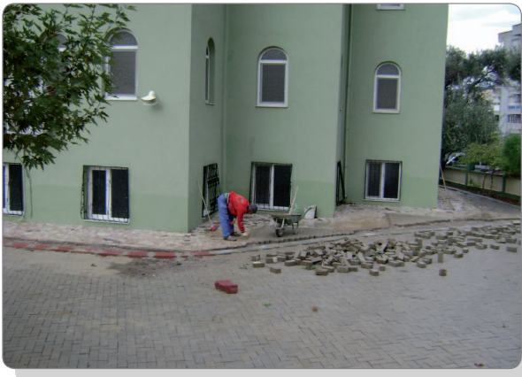
Hz.Osman Cami Kilit Taş Tamirâtı ve Kanalet Döşenmesi
