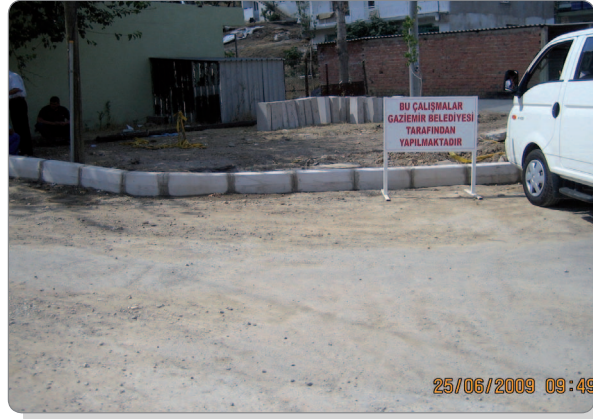
S.Ergin Cad. İle 107 Sok Kesişimi Bordür Yapımı
