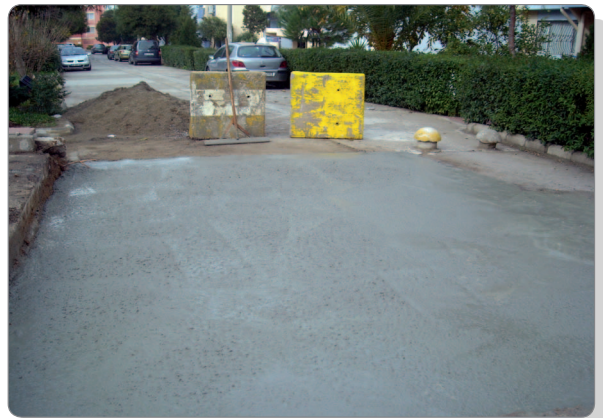
657 Sokak Şirinler Parkı Yolu Kaldırım Beton Dökümü
