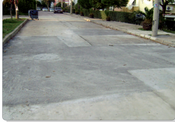
657 Sokak Şirinler Parkı Yolu Beton Dökümü ve Çim Bordürü Tamirâtı
