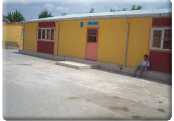
Sarnıç Hürriyet Mah. Remzi Doğan İ.Ö.Okulu bahçesine Prefabrik anaokulu inşa edilmiştir.
