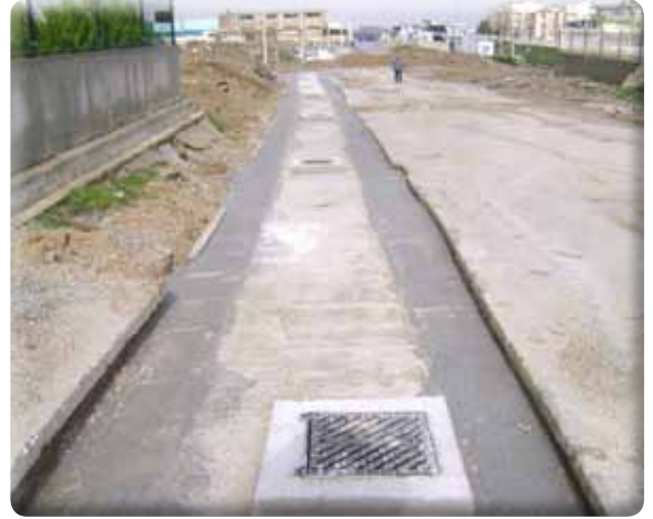
Dokuz Eylül Mah. kahramanlar Cad. yağmur suyu kanalı çalışması
