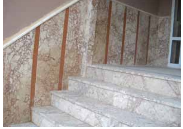
Atıfbey Mah. Belediye nikah ve düğün salonu yuvarlak kolonlara mermer kaplaması yapıp, pencere altları ve koridora mermer kaplaması ve traverten merdiven kaplaması yapılmıştır. Boya işleri gerçekleştirilmiştir.
