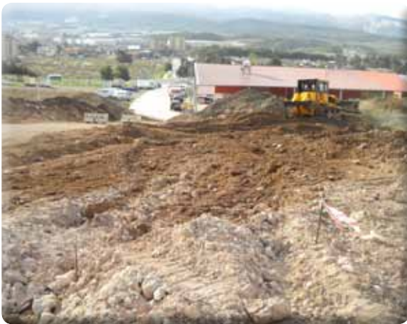
Beyazevler Mah. İzokom yanı 565-556 sokaklar yeni açılmış yollara kaya dolgu yapılmış ve üzerine by-pass serilerek kilit parke, kenarlarına tretuar yapılmıştır.
