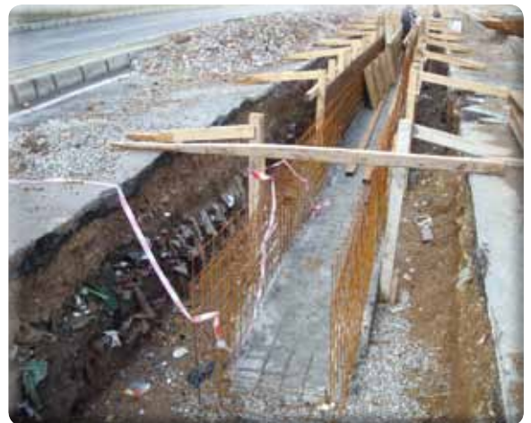
Irmak Mah. 99 Sok. yağmur suyu kanal çalışması
