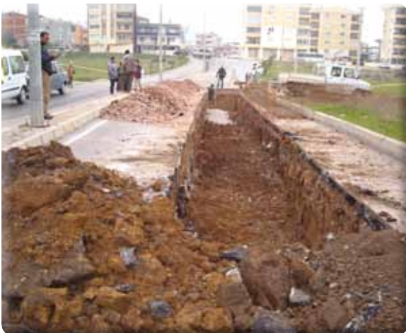
Irmak Mah. 99 Sok. yağmur suyu kanal çalışması
