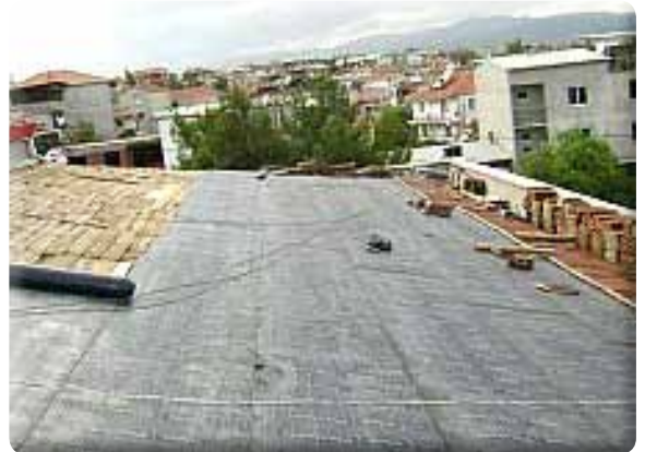
Sarnıç Atatürk Mah. Dedeoğlu İ.Ö. Okulu çatı tamirati ve su yalıtımı yapılmıştır.
