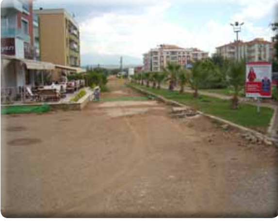
Atıfbey Mah. 680 sokak imar planına uygun olarak açılmış, altyapısı hazırlanarak trotuar ve yol gövdesi parke kaplama olarak düzenlenmiştir (~ 5600 m 2 parke, 1600 m bordür).
