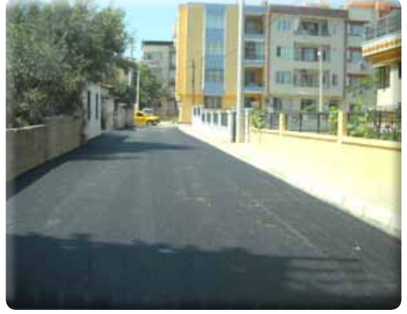
Gazi Mah. 28-6 Sok. asfalt serimi yapılmıştır.
