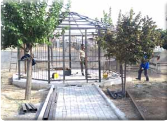
Aktepe Mah. Ensari Camii çevre düzenlemesi, çardak yapımı ve boya işleri tamamlanmıştır.
