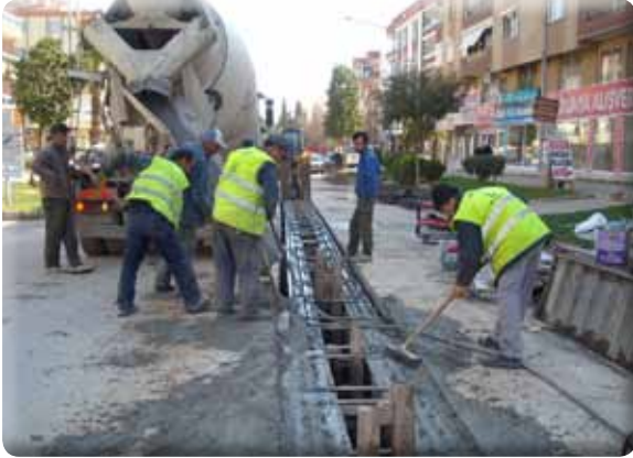
Kemal reis Cad. yağmur suyu kanal çalışması
