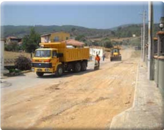
Irmak Mah. Çiftlik Evleri yanı, 38-39 sokaklarda yolun alt yapısı ve kaldırımları yapılmıştır (~4400 m 2 trotuar).
