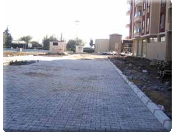
Atıfbey Mah. 680 sokak imar planına uygun olarak açılmış, altyapısı hazırlanarak trotuar ve yol gövdesi parke kaplama olarak düzenlenmiştir (~ 5600 m 2 parke, 1600 m bordür).
