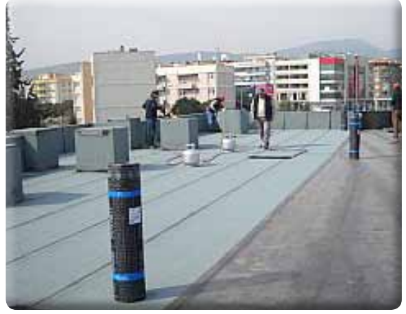
Dokuz Eylül Mah. Nuri Özseçkin Kültür ve Sanat Merkezi teras çatı su yalıtımı yapılmıştır.
