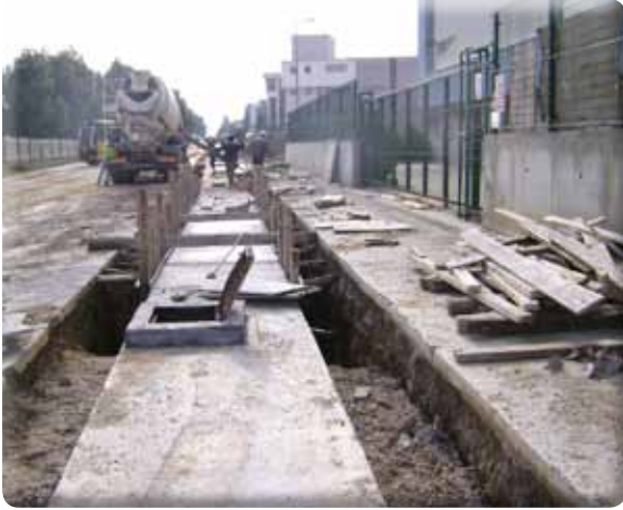
Dokuz Eylül Mah. kahramanlar Cad. yağmur suyu kanalı çalışması
