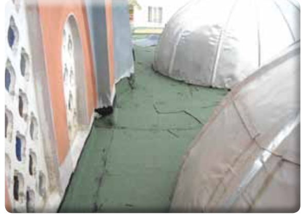
Sarıç Birlik Camii çatı duvar yalıtımı yapılmıştır.
