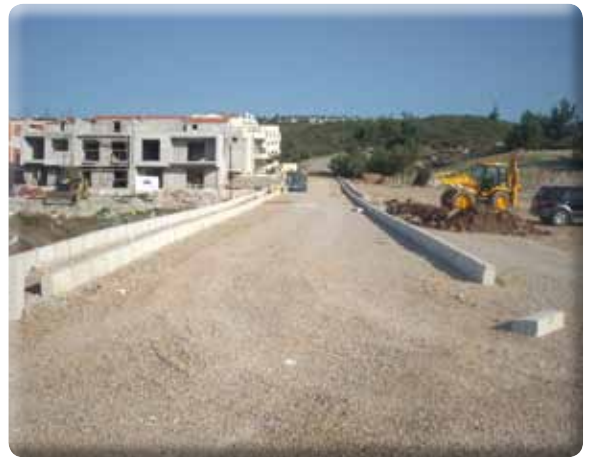
Beyazevler Mah. İzokom yanı 565-556 sokaklar yeni açılmış yollara kaya dolgu yapılmış ve üzerine by-pass serilerek kilit parke, kenarlarına tretuar yapılmıştır.
