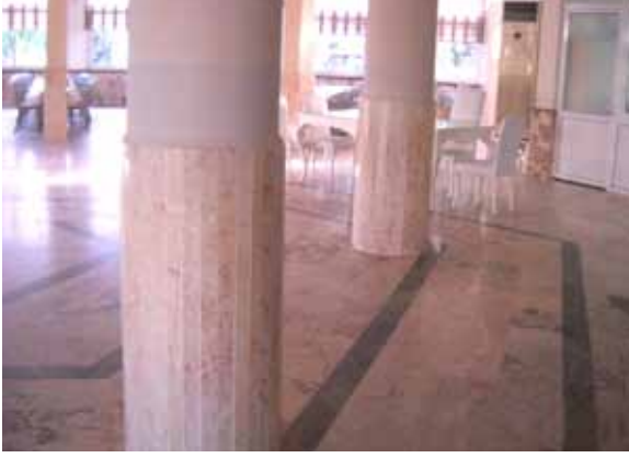
Atıfbey Mah. Belediye nikah ve düğün salonu yuvarlak kolonlara mermer kaplaması yapıp, pencere altları ve koridora mermer kaplaması ve traverten merdiven kaplaması yapılmıştır. Boya işleri gerçekleştirilmiştir.
