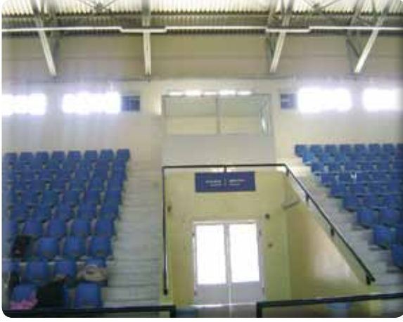
Gazikent Mah. Ahmet Taner Kışlalı spor salonu çatısı su yalıtımı ve boya işleri yapılmıştır.
