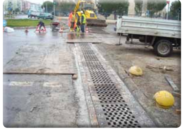
Abdülhamit Yavuz Cad.-73 Sok. keşişimi yağmur suyu kanal çalışması
