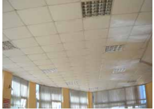
Atıfbey Mah. Belediye nikah ve düğün salonu çatı su yalıtımı, pencere su yalıtımı, taban mermer silim ve cila, taşıyıcı asmatavan paneli yapımı gerçekleştirilmiştir.
