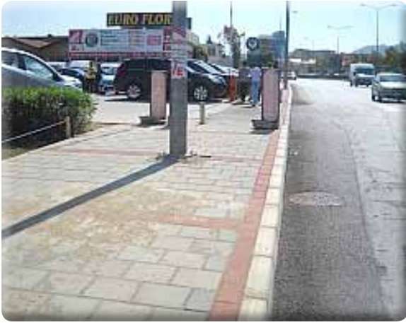
Akçay Cad. semt garajı önü tretuar ve kavşak düzenlemesi
