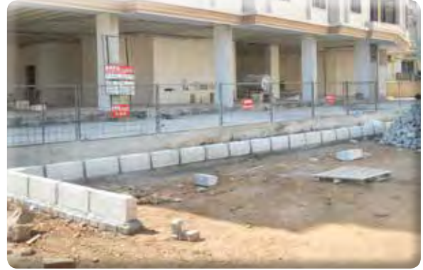
Irmak Mahallesi 16 Sokak Kaldırım Çalışması
