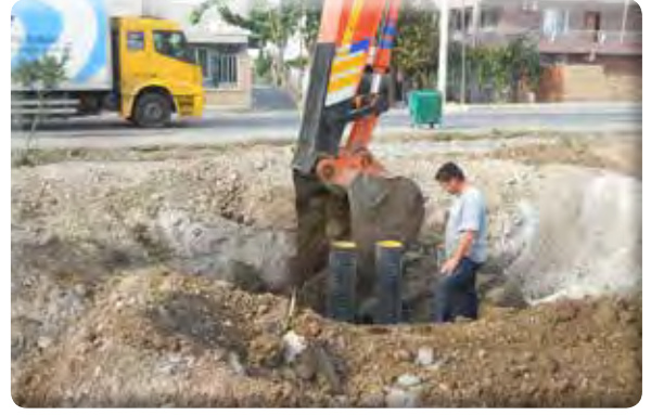
Fatih Mahallesi Çamlık Caddesi İZSU Vanaları Logar Çalışması
