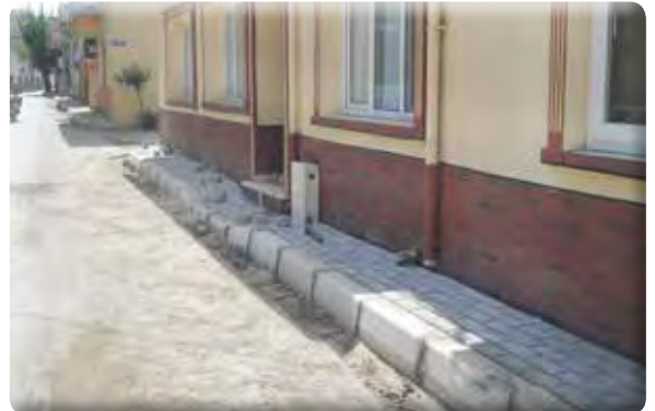
Yeşil Mahalle 40 Sokak Kaldırım Çalışması
