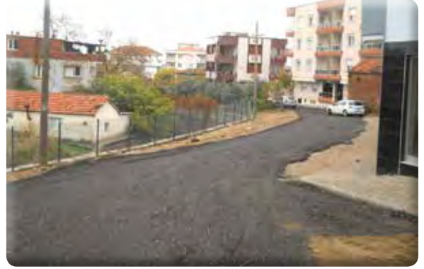
Yeşil Mahalle 40 Sokak Devamı Asfalt Kırığı Serimi
