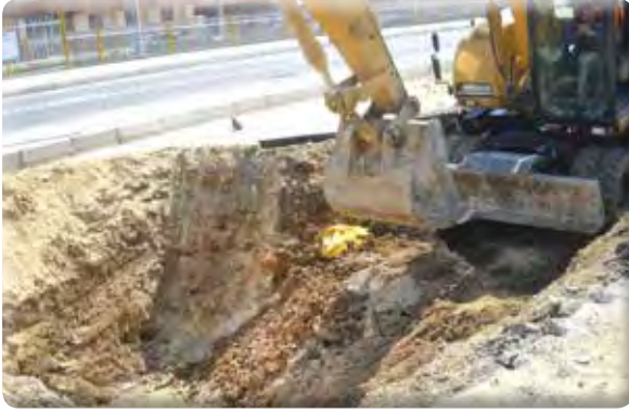
9 Eylül 309 Sokak İZSU Yağmur Suyu Kanal Çalışması
