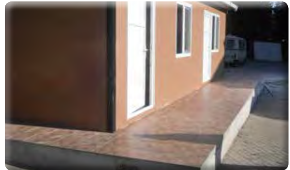
Geçici Belediye Binası Araç Amirliği, Prefabrik Bina Yapımı
