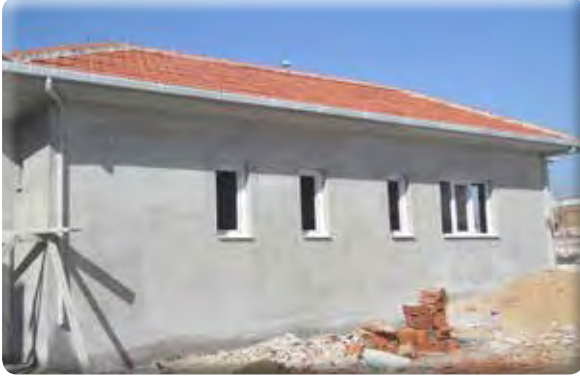
Binbaşı Reşatbey Mahallesi Çamaşırhane Tesisi Yapımı
