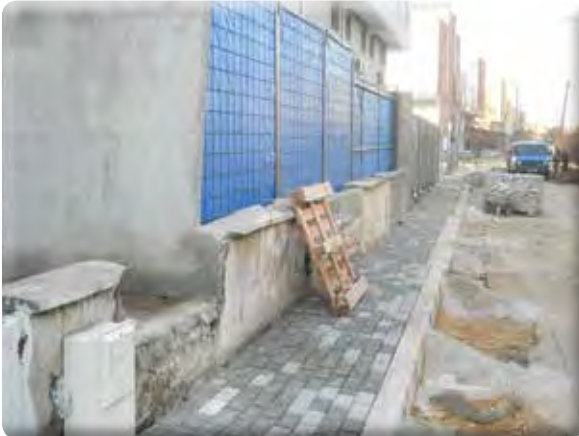
9 Eylül Mahallesi 307 Sokak Kaldırım Çalışması
