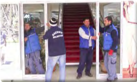
Geçici Belediye Binası Otomatik Kapı Montajı
