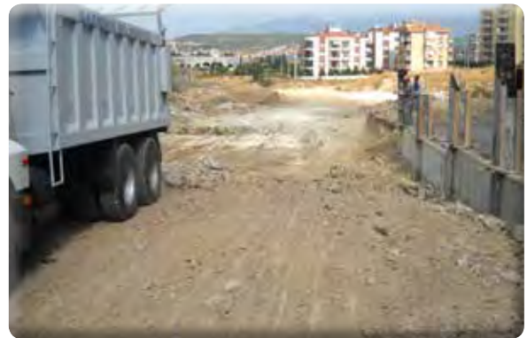
Irmak Mahallesi 38/6 Sokak Dolgu Çalışması
