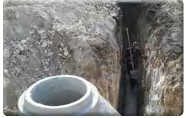
Fatih Mahallesi 1199 Sokak Kanalizasyon Hattı Yapımı
