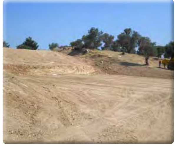
Aktepe Mahallesi Ensari Camii Park Alanı Tesviyesi ve Park Yapımı
