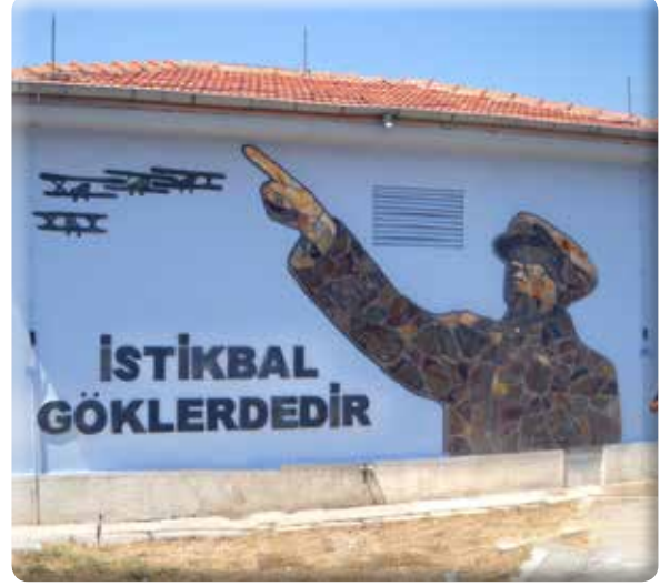
Hava Teknik Okulları Trafo Binası
