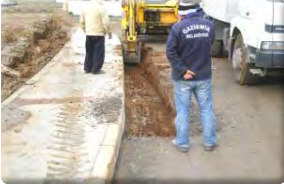
Atıfbey Mahallesi 11/3 İzgara Yapımı
