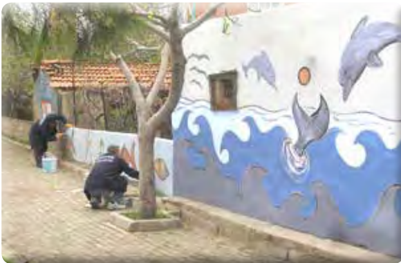
9 Eylül Mahallesi Sevgi Yolu 4. Etap Tamiratları
