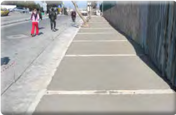
Aktepe Mahallesi Altan Aydın Caddesi Kaldırım Yapılması
