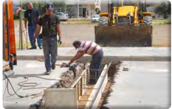
Türkan Saylan Caddesi Yağmur İzgara Yapımı
