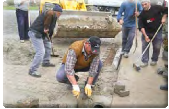
Hürriyet Mahallesi 1072 Sokak Yağmur Kanalı Yapımı
