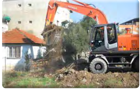
Menderes Mahallesi 1001-2 Sokak Açılması
