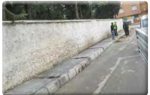
Atıfbey Mahallesi 2 Sokak Kaldırım alıřması
