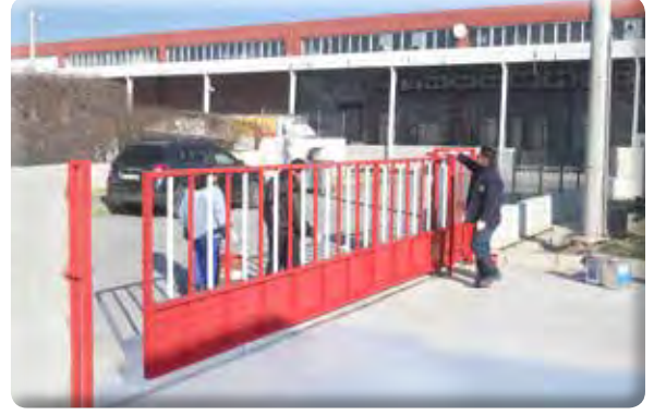
Makine İkmal Birimi Şantiyesi Kapı ve Tel Çit Yapımı
