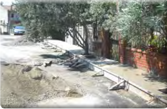
Beyazevler Mahallesi 546 Sokak Kaldırım Çalışması
