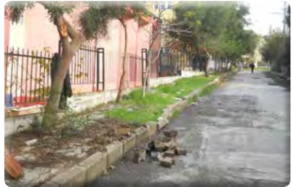
Beyazevler Mahallesi 542 Sokak Kaldırım Tamirata
