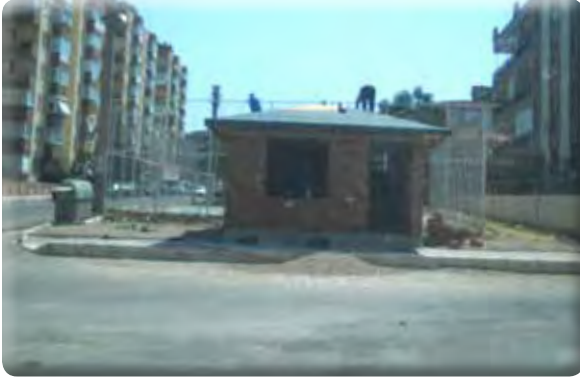
Irmak Mahallesi Muhtarlık Bina Yapımı
