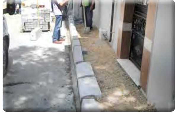
Gazi Mahallesi 28/2 Sokak Kaldırım Yapımı
