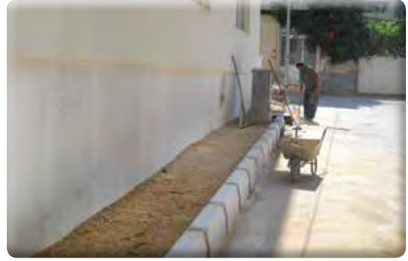
Yeşil Mahalle 47 Sokak Kaldırım Çalışması
