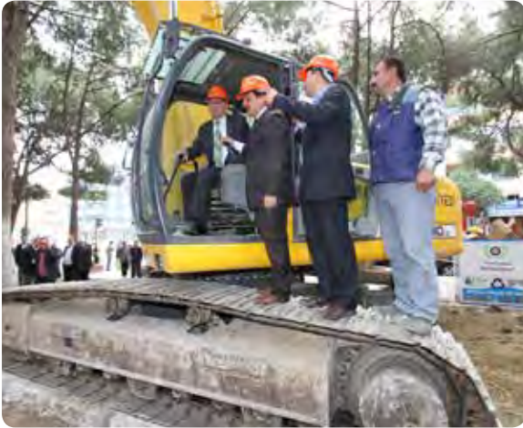
26.03.2012 Eski Belediye Binasının Yıkımı gerçekleştirilmiştir.
