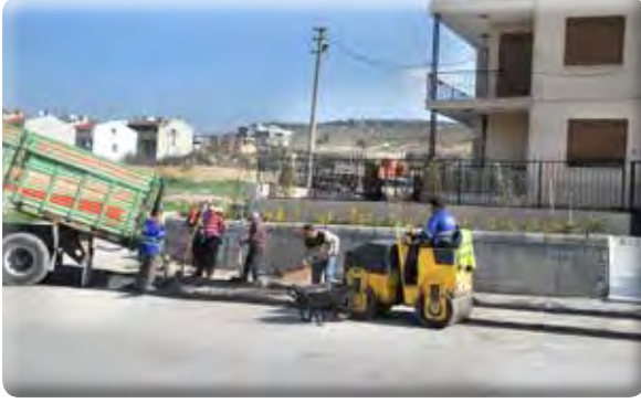
Beyazevler Mahallesi Asfalt Yama Çalışması
