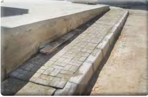
Atıfbey Mahallesi 62 Sokak Kaldırım Çalışması
