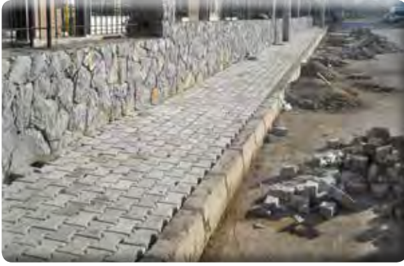
Irmak Mah. 38/23 38/25 38/26 38/27 Sokaklar Kaldırım Çalışması
