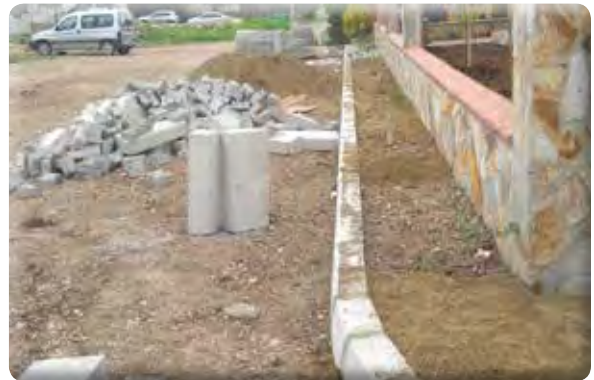
Beyazevler Mahallesi 555/1 Sokak Kaldırım Çalışması
