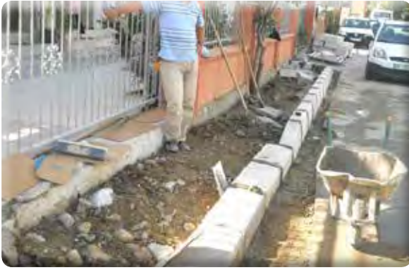
Ekim 9 Eylül Mahallesi 331 Sokak Kaldırım Çalışması
