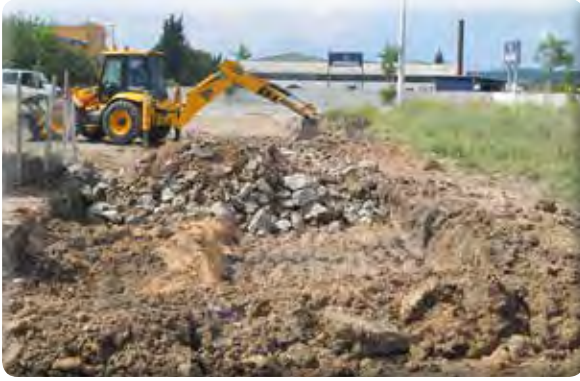
Fatih Mahallesi 1130 Sokak Yol Dolgu Çalışması
