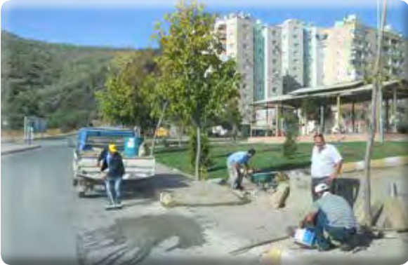
Zafer Mahallesi Evka-7 Genel Kaldırım Tamirata ve Dzenlemesi
