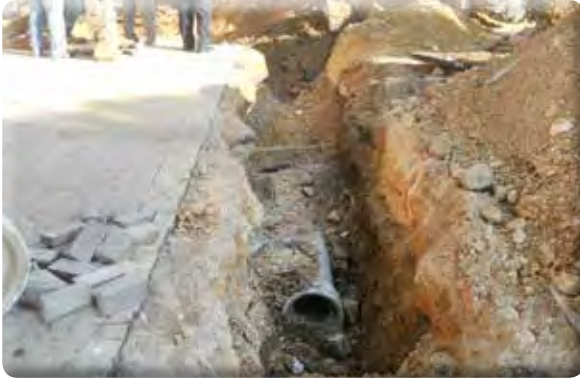
Atıfbey Mahallesi Abdullah Arda Meydanı Kanal Çalışması
