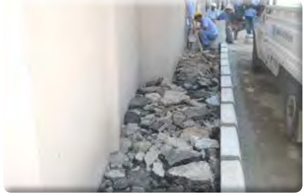
Yeşil Mahalle 53 Sokak Kaldırım Çalışması
