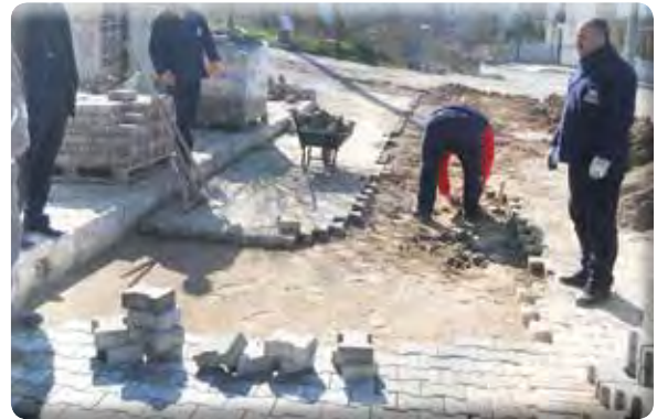
Beyazevler Mahallesi 556 Sokak Yol ve Kaldırım Tamirâtı
