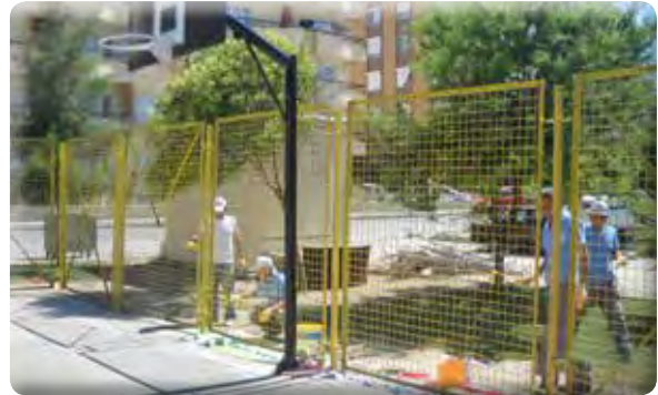
Atıfbey Mah. Esra Parkı Basketbol Sahası, Trafo Boya ve Kaynak İşleri
