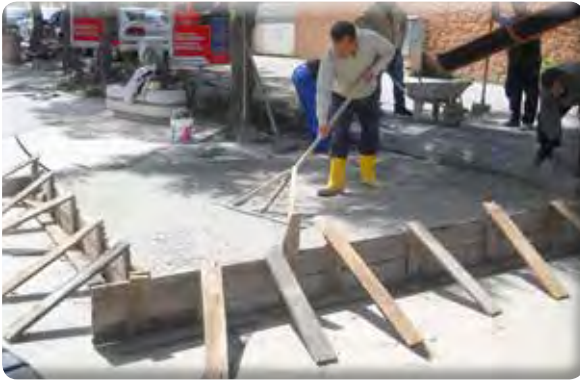
Sevgi Yolu 1. Etap Stand Betonları Yapımı
