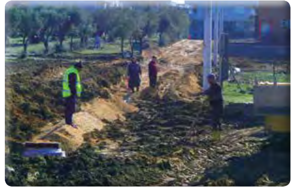
1130 Sokak Kanal Çalışması
