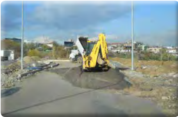
9 Eylül Mah. Ulaştırma Cad. Kaldırım Yapımı ve Asfalt Kırımı Serimi
