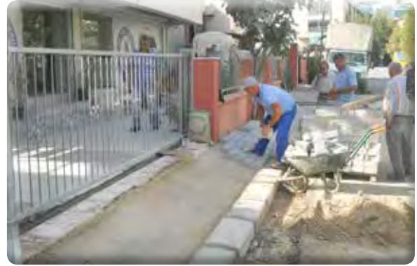
Atıfbey Mahallesi Mertler Caddesi Kaldırım Çalışması
