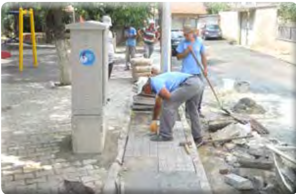
Yeşil Mahalle 46 Sokak ve 40 Sokak Kaldırım Çalışması
