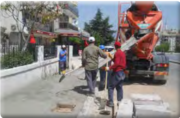
Yeşil Mahalle 56 Sokak Kaldırım Yapımı
