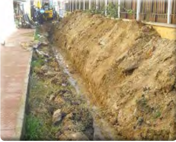
Kıpa Lisesi Kanal Yenileme Çalışması
