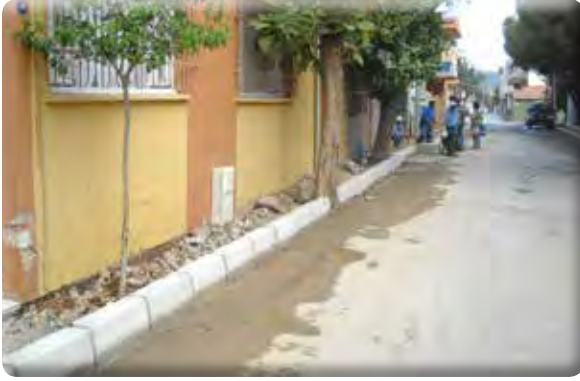
Yeşil Mahalle 40 Sokak Kaldırım Çalışması
