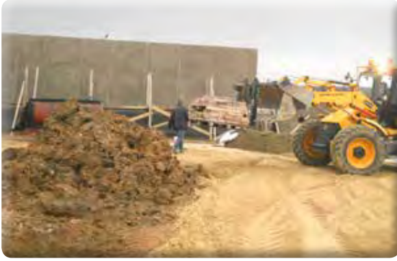
Fatih Mahallesi Atatürk Cad. Yeşil Alan Düzenleme ve Anıt Yapımı
