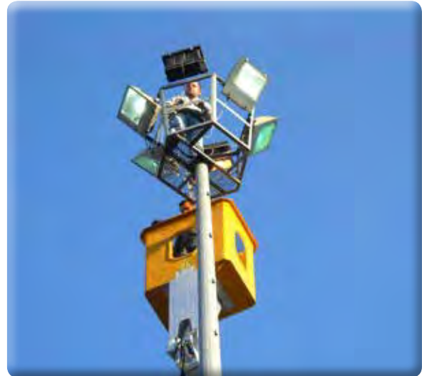
Rafet Şenbaydur Parkı Arızalı Aydınlatmaların Onarılması
