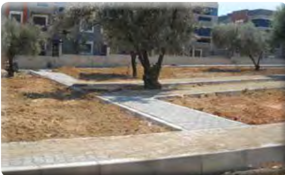
Irmak Mahallesi 702-703 Sokak Park Yapımı
