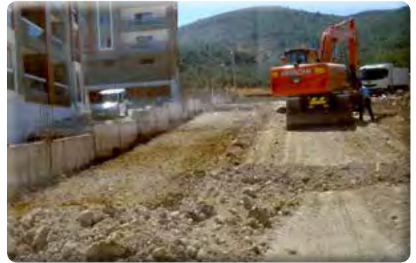
İrmak Mahallesi 38/6 Sokak Açılması ve Dolgu Çalışması
