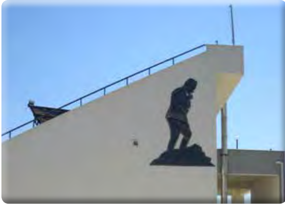
Hava Teknik Okulları Tribünü
