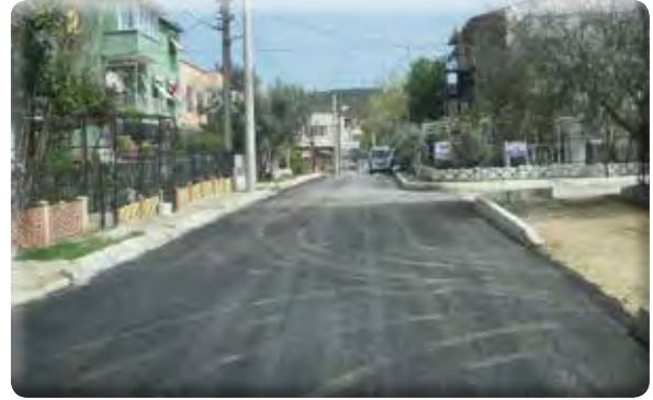
Beyazevler Mahallesi Asfalt Çalışması
