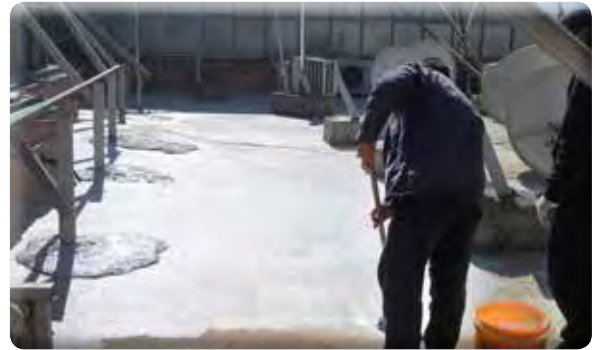
Geçici Belediye Binası Çatı İzolasyonu
