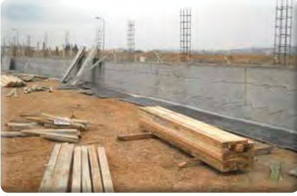
Fatih Mahallesi Atatürk Caddesi Yeşil Alan Düzenlemesi
