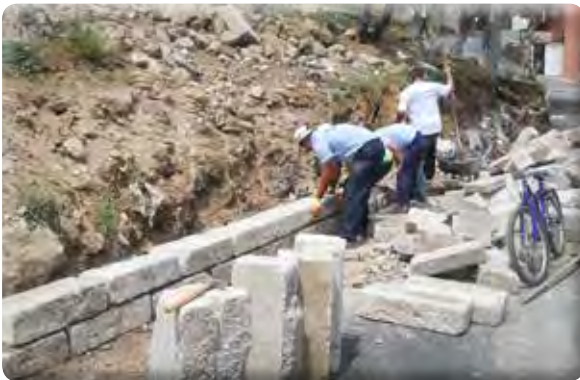
Irmak Mahallesi 39 Sokak İstinat Duvarı Yapımı
