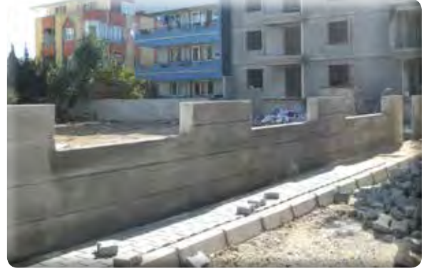
9 Eylül Mahallesi 309 Sokak Kaldırım Çalışması
