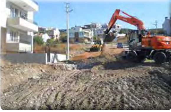
Beyazevler Mahallesi 555 Sokak Yol Dolgu Çalışması
