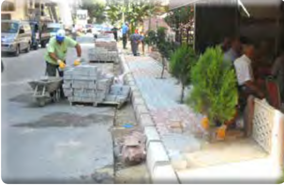
Gazi Mahallesi 25 Sokak Kaldırım Çalışması
