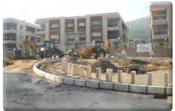
Irmak Mah. 702-703 Sok. Altı Yapı Kaldırım ve Meydan Çalışması
