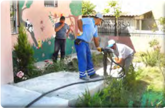
Menderes Mahallesi Sarnıç Ana Okulu Beton Kıırımı
