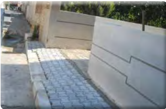
Irmak Mahallesi 23 Sokak Kaldırım Çalışması
