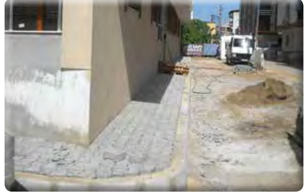
Gazi Mahallesi 17 Sokak Kaldırım Yapımı
