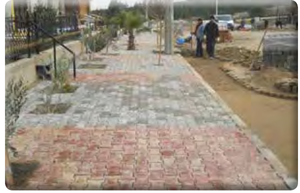
Beyazevler Mahallesi 556 Sokak Yol Tamirâtı ve Kaldırım Çalışması
