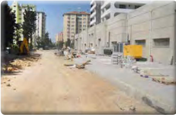
Kaldırım Yol Çalışması
