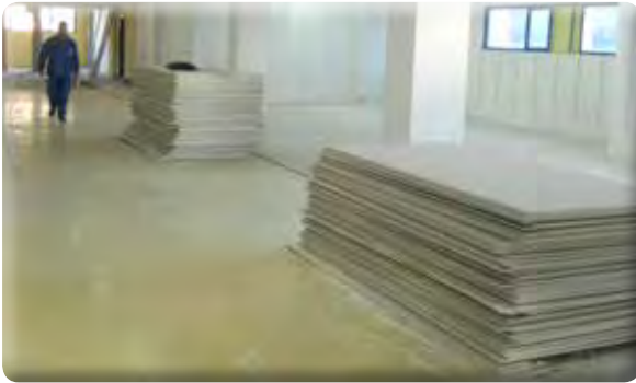
Geçici Belediye Binası Tadilat Çalışması
