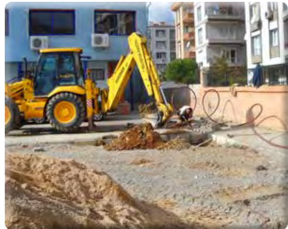
Gazi Mahallesi 25 Sokak Yeni Park Alanına Aydınlatma Yapımı
