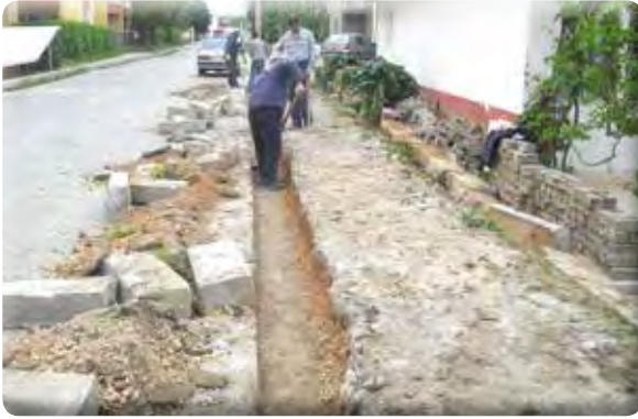
9 Eylül Mahallesi 333 Sokak No: 20 Kaldırım Düzenlemesi
