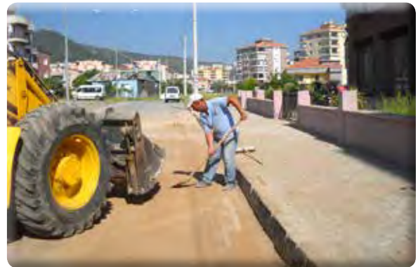
Irmak Mahallesi 90 Sokak Kaldırım Çalışması
