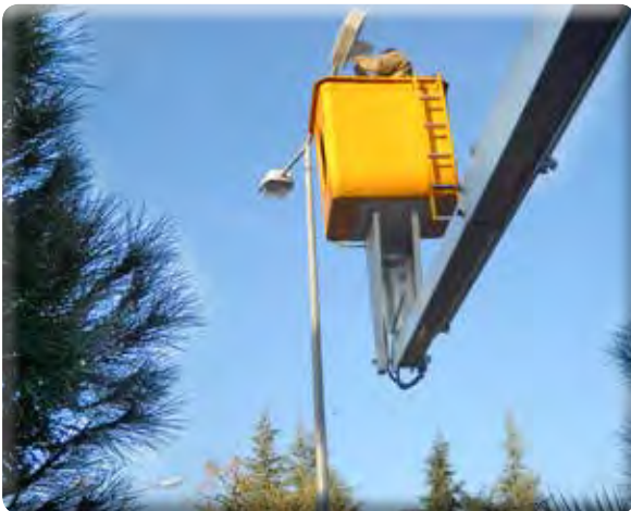
Özge Parkı Aydınlatma Arızasının Onarımı
