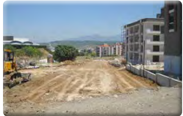
Irmak Mahallesi 38/6 Sokak Yol Açılması
