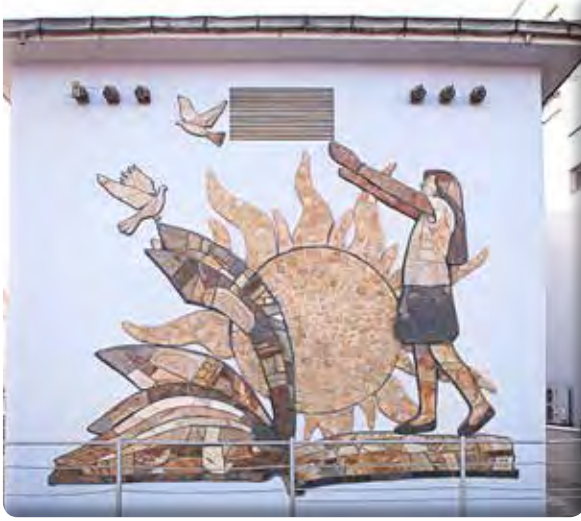
Akçay Caddesi Üzerinde Trafo Binası
