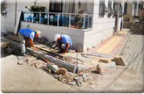
Gazi Mahallesi 22 Sokak Kaldırım Çalışması
