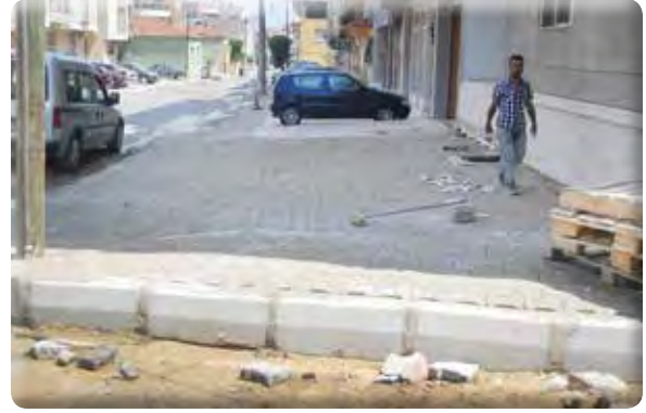
Gazi Mahallesi 19 Sokak Kaldırım Yapımı
