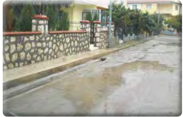
9 Eylül Mahallesi 349 Sokak Yağmur Kanalı Yapımı
