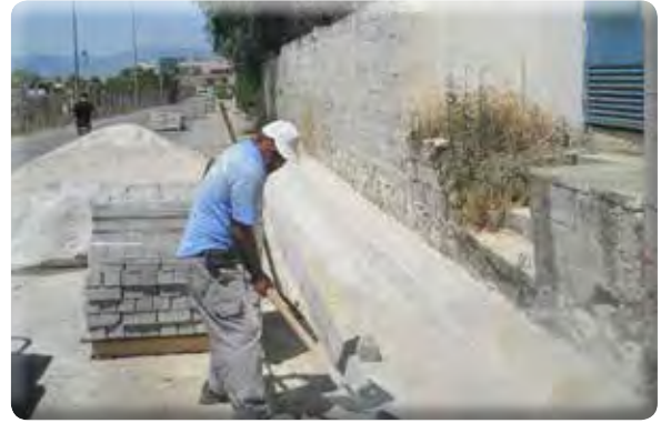
Gazi Mahallesi Hasan Güven Caddesi Kaldırım Çalışması
