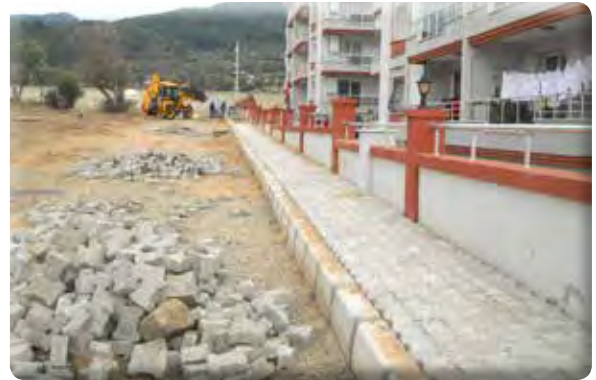
Irmak Mahallesi 719-720-721 Sokaklar Kaldırım Çalışması
