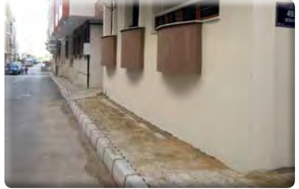
Yeşil Mahalle 49 ve 51 Sokak Kaldırım Çalışması
