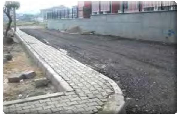
Irmak Mb. 719-720-721 Sk. Kaldırım Yapımı ve Asfalt Kırığı Serimi
