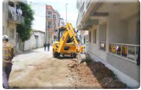
Yeşil Mahalle 53 Sokak Kaldırım Çalışması
