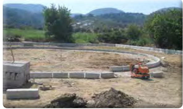
Yeşil Mahalle 41 Sokak Park Yapımı
