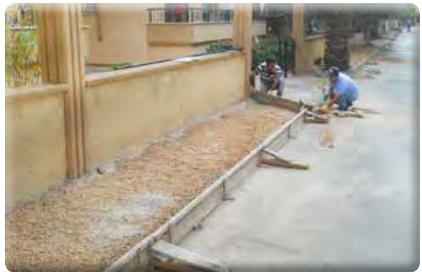
Atıfbey Mahallesi 11/1 Sokak Kaldırım Çalışması
