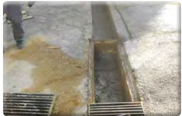
Zafer Mahallesi 810 Sokak İzgara Yapımı
