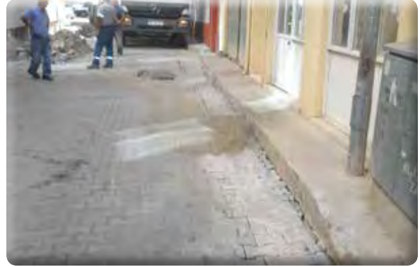
Atıfbey Mahallesi 12 Sokak Taş Tamiri
