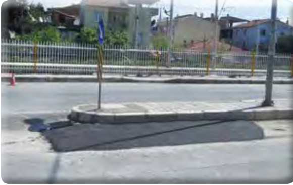
9 Eylül Mahallesi Asfalt Yama Çalışması
