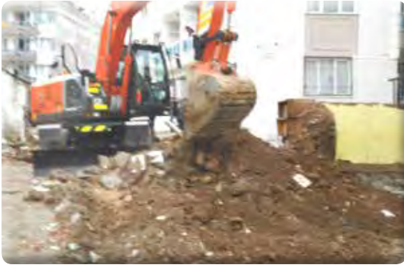
Gazi Mahallesi 21, 22 Sokak Ara Bağlantı Yolu Çalışması
