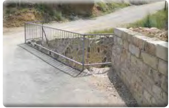
Irmak Mahallesi 39 Sokak Köprü Korkuluğu Yapımı
