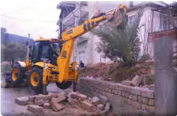
İrmak Mahallesi İstinat Duvarı ve Merdiven Tamirâtı
