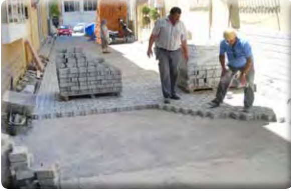
Atıfbey Mahallesi 9 Sokak Yol Tamir ve Kaldırım Çalışması
