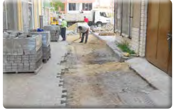
Atıfbey Mahallesi 8 Sokak Taş Tamiratu
