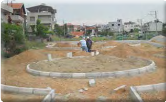
Fatih Mahallesi 1101 Sokak Park Yapımı
