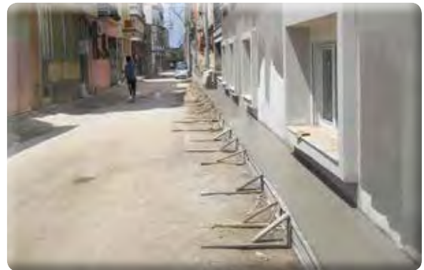
Yeşil Mahalle 54 Sokak Kaldırım Çalışması
