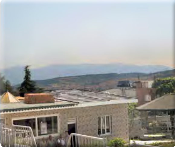
Aktepe Mahallesi Ensari Camii İçi Demir İşleri ve Çatı Onarımı
