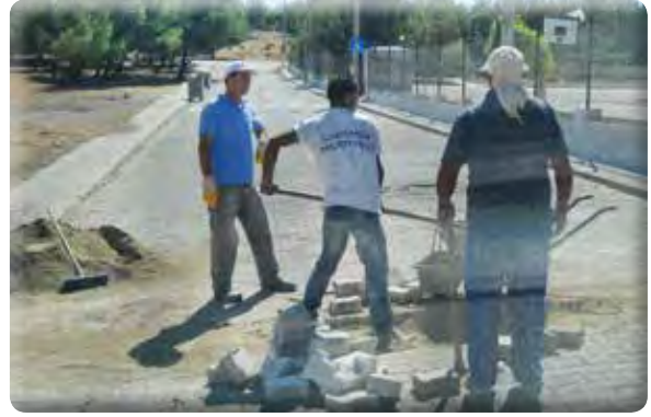
Atatürk Mahallesi 1026 Sokak Taş Tamiri
