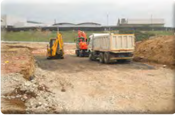
Irmak Mahallesi 38-6 Sokak Açılması Malzeme Serimi
