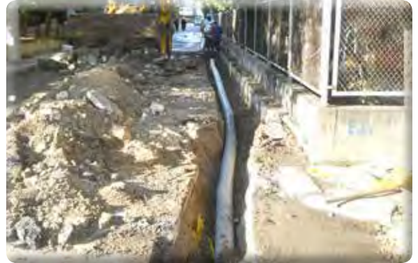
9 Eylul Mahallesi 309 Sokak No 17 İzgara Yapımı
