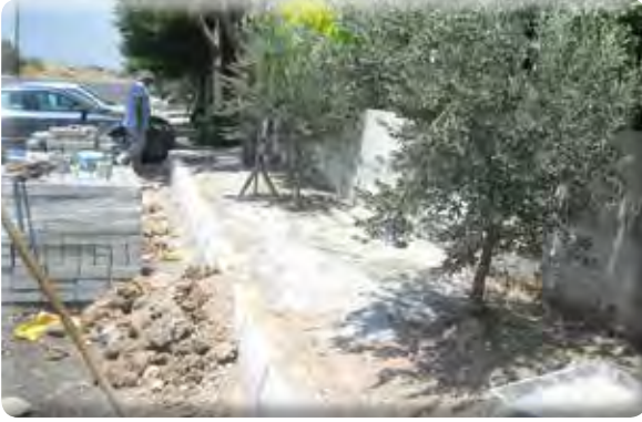
Beyazevler Mahallesi 548 Sokak Kaldırım Çalışması
