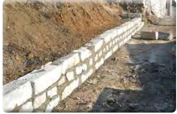
Irmak Mahallesi 39 Sokak İstinat Duvarı Yapımı
