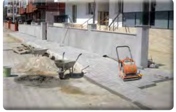
Gazi Mahallesi 28/13 Sokak Kaldırım Çalışması
