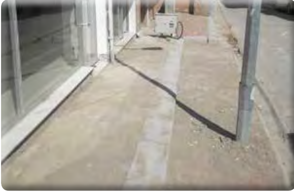
Yeşil Mahalle Metin Henkoğlu Caddesi Kaldırım Yapımı
