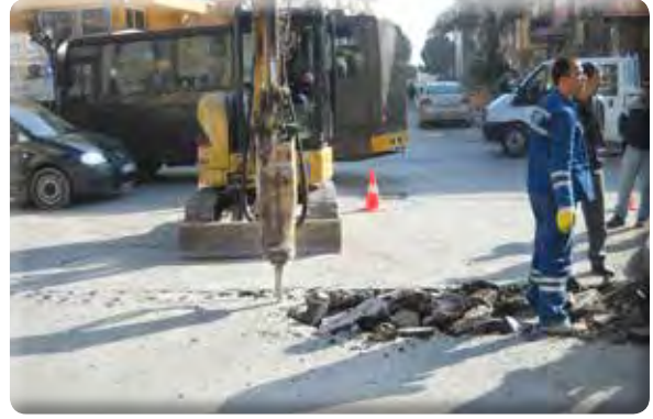
25 Sokak İZSU Yağmur Suyu Kanal Çalışması
