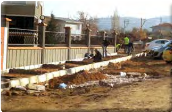
Irmak Mahallesi 702-703 Sokak Kaldırım Çalışması
