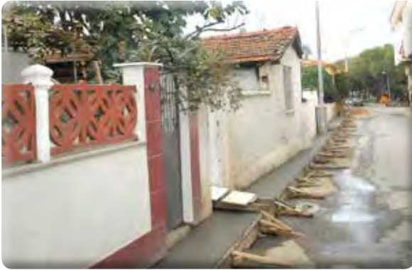
Yeşil Mahalle 40 Sokak Kaldırım Çalışması
