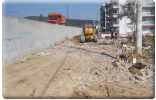
Irmak Mahallesi 718-719-720 Sokak Açılması ve Malzeme Serimi
