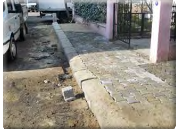
9 Eylül Mahallesi 331 Sokak Kaldırım Çalışması
