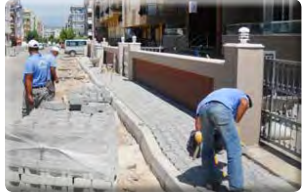
Gazi Mahallesi 27 Sokak Kaldırım Çalışması
