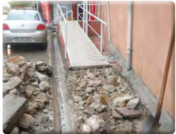
Menderes Mahallesi Sağlık Ocağı Önü Rampa Yapımı
