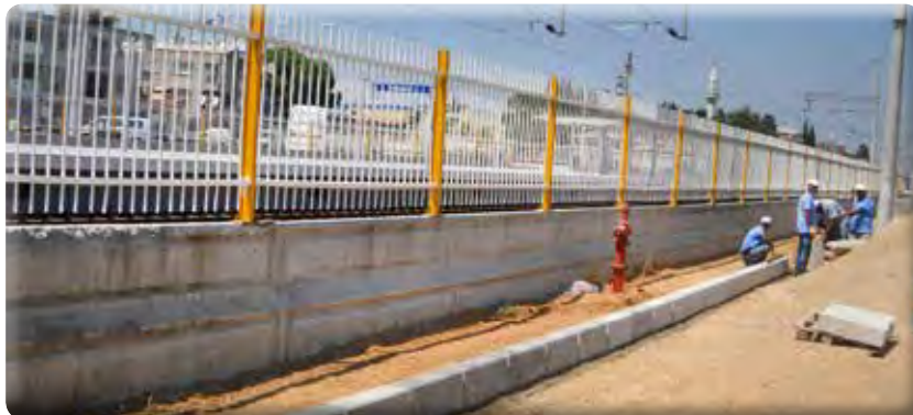
9 Eylül Mahallesi 315 Sokak Malzeme Serimi ve Kaldırım Çalışması
