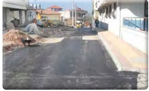
Gazi Mahallesi Asfalt Yama Çalışması
