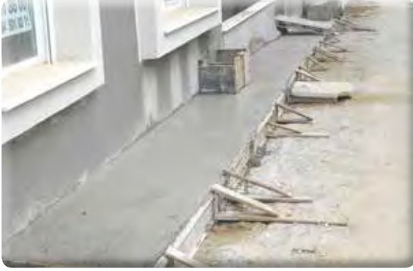
Yeşil Mahalle 50 Sokak Kaldırım Çalışması
