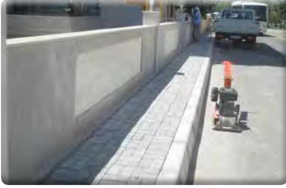
Gazi Mahallesi 28/17 ve 28/15 Sokak Kaldırım Çalışması
