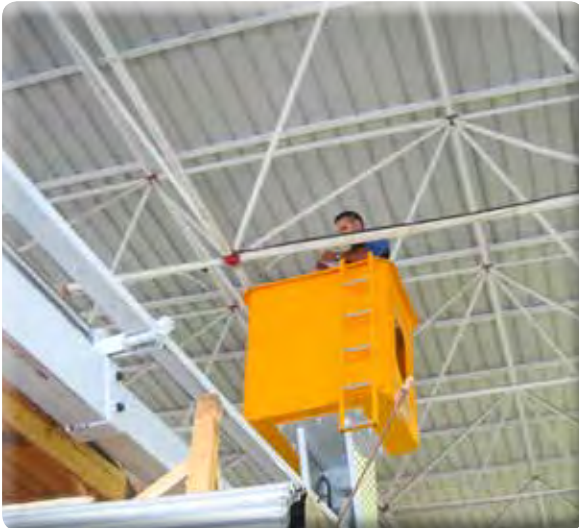
Atıfbey Mahallesi Pazaryeri Aydınlatmalarının Onarılması
