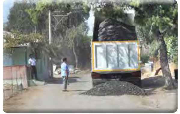
Sevgi Mahallesi 950-951 Sokak Asfalt Kırm Serimi
