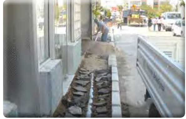
Gazi Mahallesi Sinema Sokak Kaldırım Çalışması
