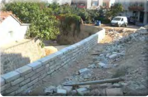
Irmak Mahallesi Derekenarı İstinat Duvarı Çalışması
