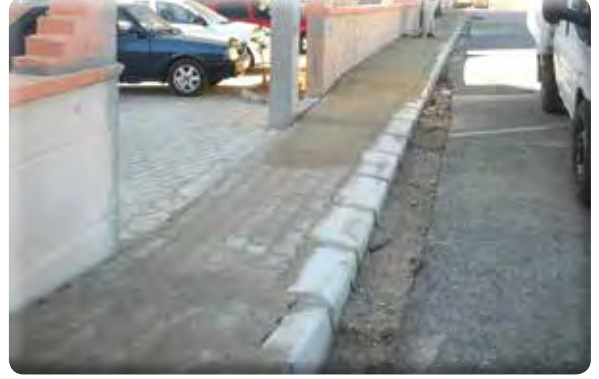
Irmak Mahallesi 38 Sokak Kaldırım alıřması
