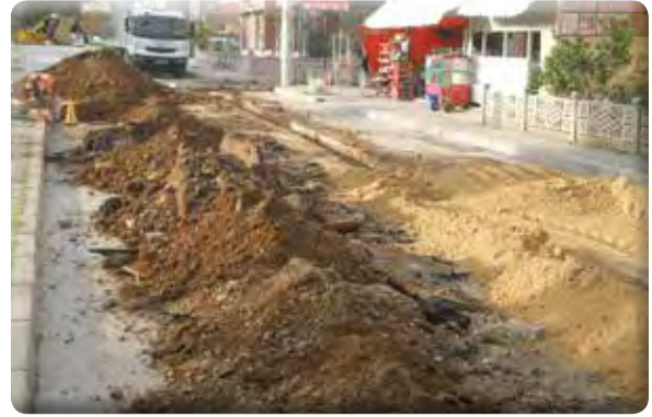
Irmak Mahallesi 93 Sokak İzgara Yapımı
