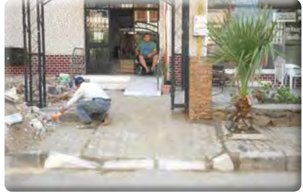
Atıfbey Mahallesi 63 Sokak Özürlü Rampa Yapımı
