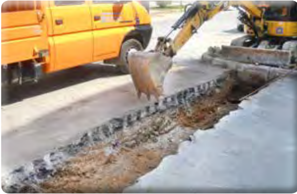
26 Sokak İZSU Yağmur Suyu Kanal Çalışması
