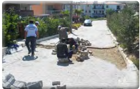
Yeşil Mahalle 58/1 Sokak Taş Tamirâtı
