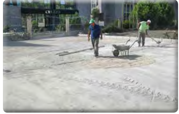
Fatih Mahallesi Çamlık Caddesi Otopark Yapımı
