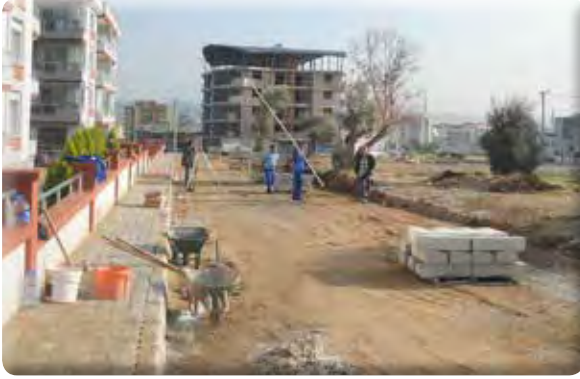
Irmak Mahallesi 719-720-721 Sokak Kaldırım Yapımı
