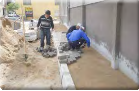
Gazi Mahallesi 19 Sokak Kaldırım Yapımı
