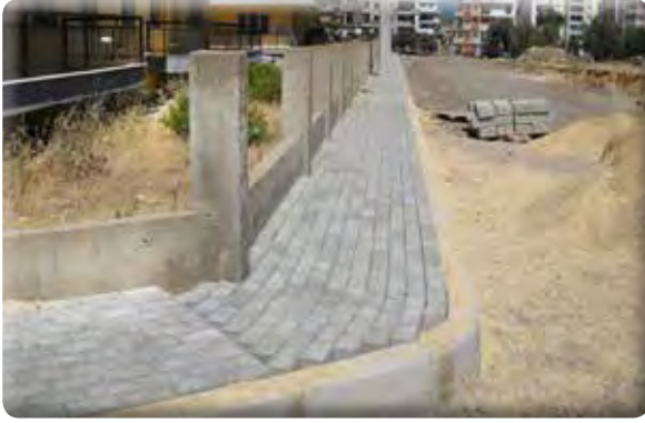
Irmak Mahallesi 38/22 Sokak Kaldırım ve Yol Çalışması
