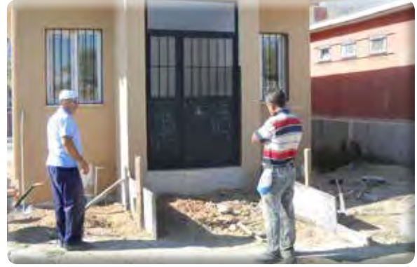
Binbaşreşatbey Mahallesi Çamaşırhane Çevre Düzenlemesi
