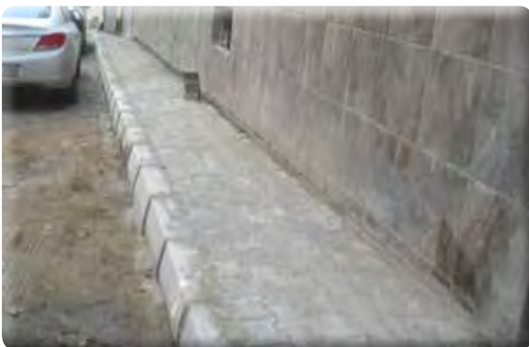
Atıfbey Mahallesi 8/1 Sokak Kaldırım Yapımı
