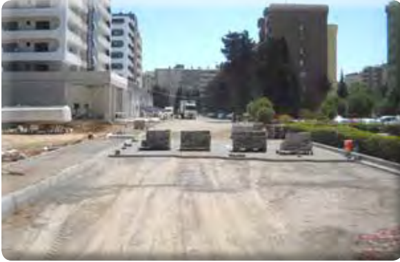
Gazikent Mahallesi 80/2 ve 674/1 Sokak Yol Kaldırım Çalışması
