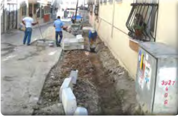
Yeşil Mahalle 49 Sokak Kaldırım Çalışması
