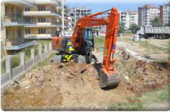
Irmak Mahallesi 38/22 Sokak Yol Açılması
