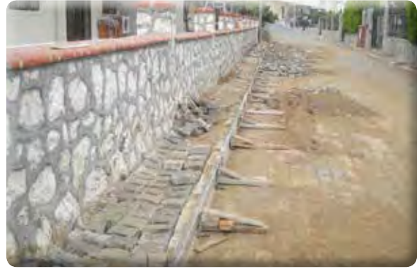
9 Eylül Mahallesi 349 Sokak Kaldırım Taminatı
