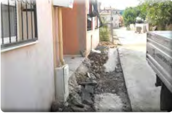
Yeşil Mahalle 55 Sokak Kaldırım Çalışması
