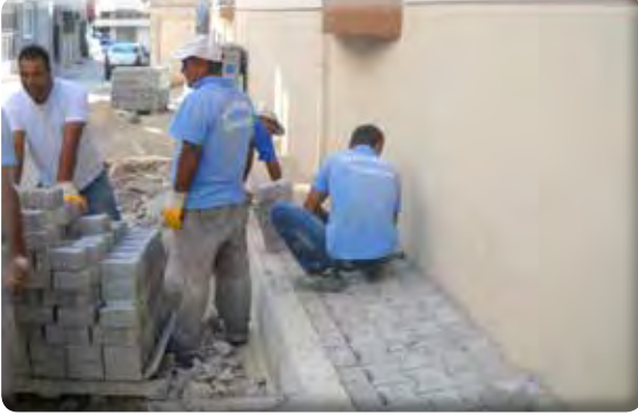
Irmak Mahallesi 49 Sokak Kaldırım Çalışması
