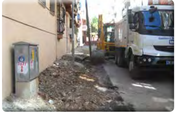
Yeşil Mahalle 49 Sokak Kaldırım Çalışması
