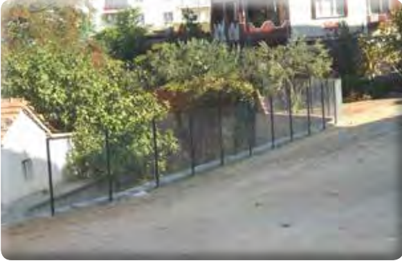
Irmak Mahallesi Dere Kenarı İstinat Duvarı Tel ekimi
