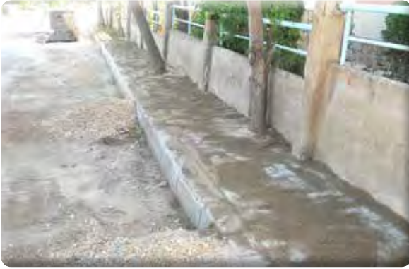
Irmak Mahallesi 89-90-96 Sokaklar Kaldırım Yapımı
