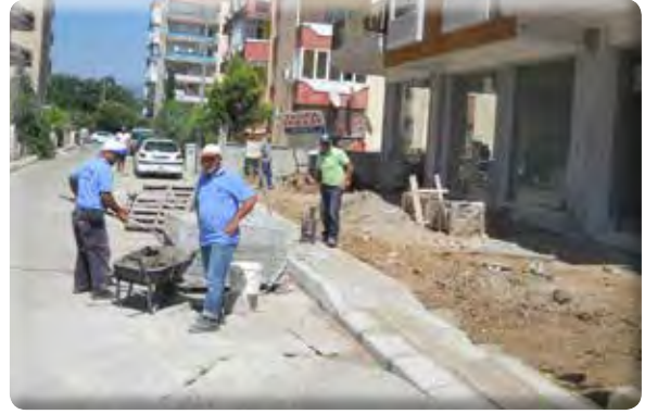
Gazi Mahallesi 28/14 Sokak kaldırım yapılması işi.
