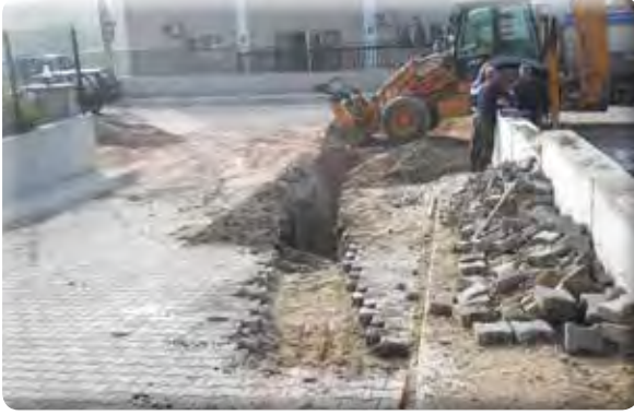
Fatih Mahallesi 1143/2 Sokak kanalizasyon döşenmesi işi.
