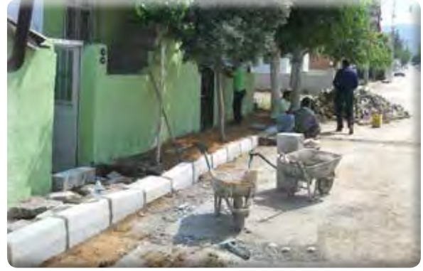
Irmak Mahallesi 98 Sokak kaldırım yapılması işi.
