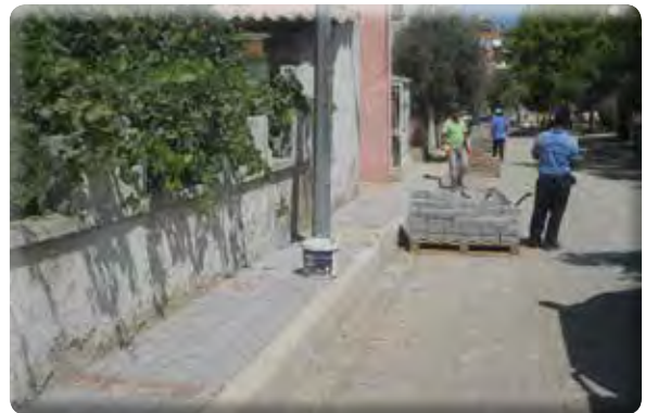
Yeşil Mahalle 40/3 ve 53 Sokak kaldırım çalışması.
