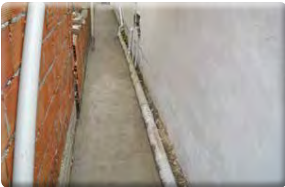
Atatürk Mahallesi 1031 Sokak açık yağmur kanalı yapılması işi.
