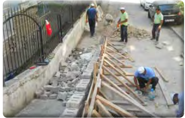
Sevgi Mahallesi 80/9, 80/10 Sokak kaldırım çalışması.
