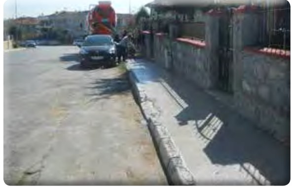
Yeşil Mahalle 40 ile 56 Sokak keşişimi kaldırım yapılması işi.
