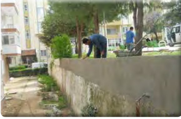
Sevgi Mahallesi Günlük Parkı tamirat işi.
