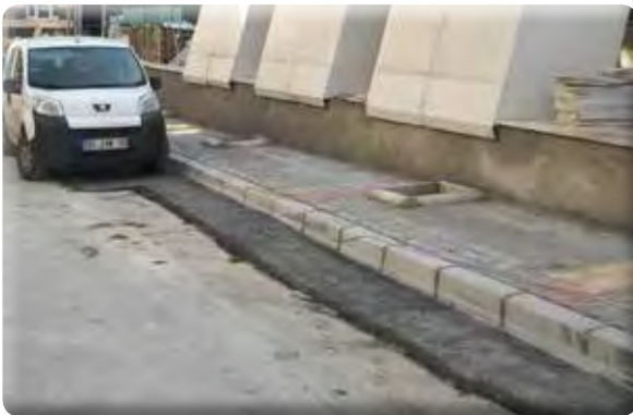
Gazi Mahallesi 25 Sokak Yarbay Refik Cesur Caddesi kaldırım yapımı ve taş tamirati işi.
