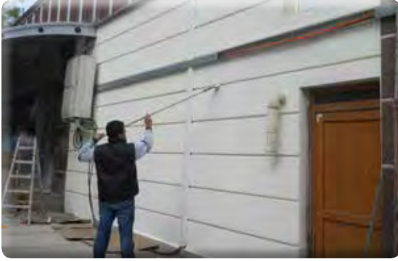
Gazikent Mahallesi Kültür evi tadilat ve boya işi.
