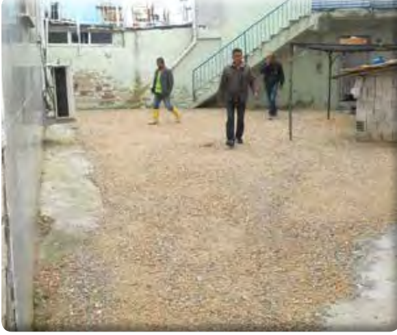
Atatürk Mahallesi birlik Camii lojman içi beton atılması işi.
