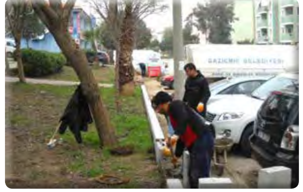
Sevgi Mahallesi Mimoza Parkı bordür yapılıması işi.
