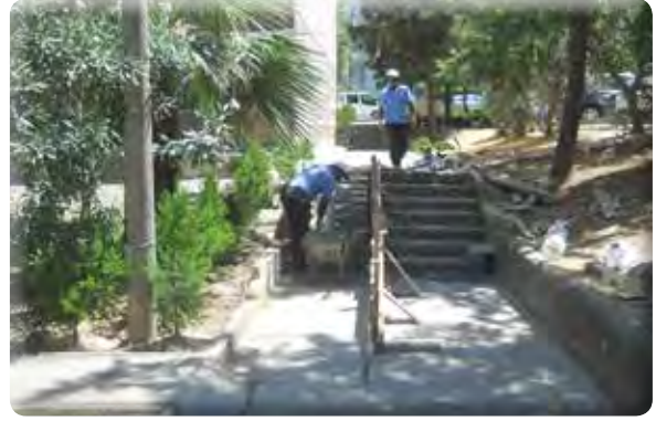
Gazikent Mahallesi 80/5 Sokak özürlü rampaları yapılması işi.
