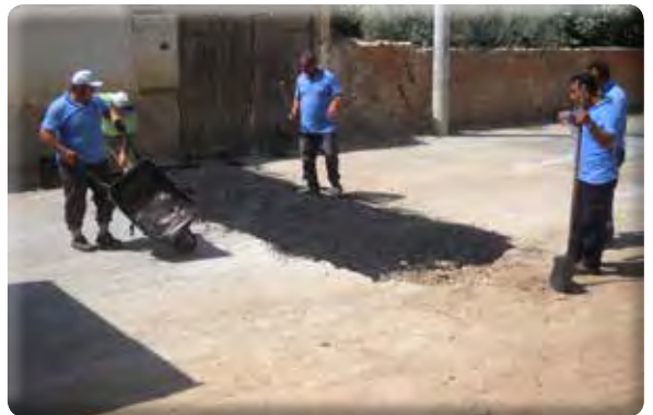
Irmak Mh. 23 ve 702 Sk. ile H.Güven Cd. asfalt yama yapılması işi.
