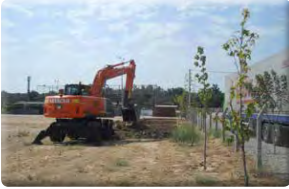
Fatih Mahallesi Sarnıç Sosyal Tesisleri Otopark yapılması işi.
