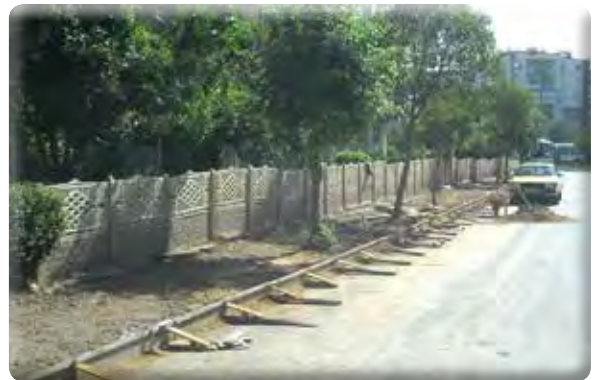
Yeşil Mahalle 56 Sokak kaldırım yapılması işi.
