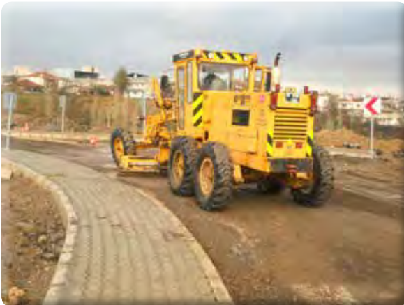
Dokuz Eylül Mahallesi Ulaştırma alt geçidi yol çalışması.
