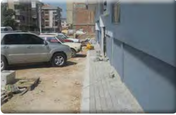
Gazi Mahallesi 21 Sokak kaldırım yapılması işi.
