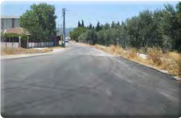
Fatih Mahallesi asfalt yapılması işi.
