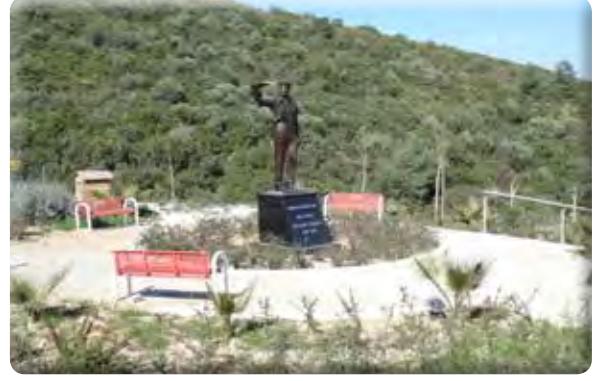
Zafer Mahallesi Bülent Ecevit parkı yapılması işi.
