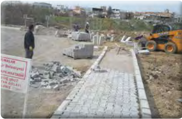
Dokuz Eylül Mahallesi 350 Sokak kaldırım yapılması işi.
