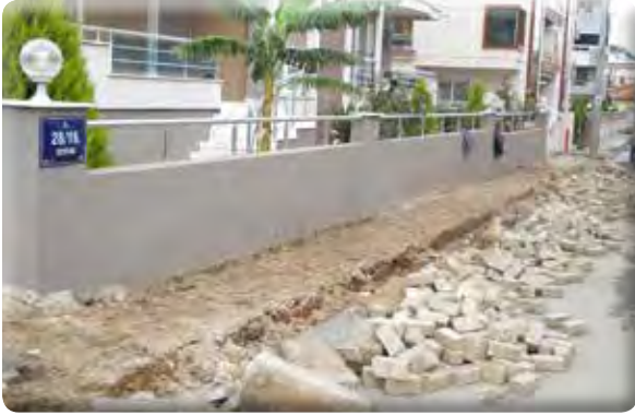
Gazi Mahallesi 28/16 ve 28/13 Sokaklar kaldırım yapılıması işi.
