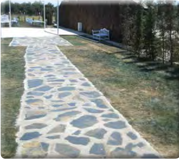
Fatih Mahallesi Sarnıç Sosyal Tesisleri içi kayrak kaplama çalışması.
