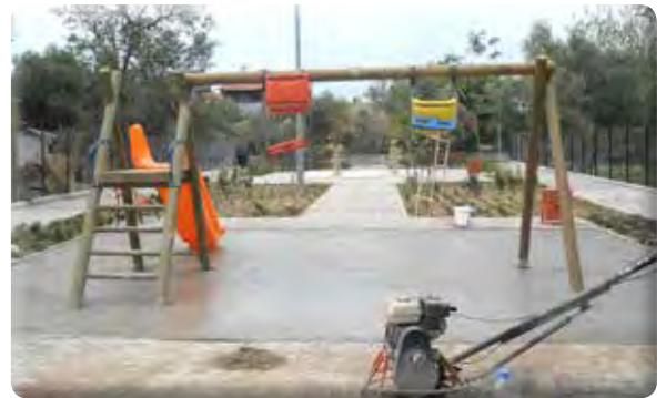
Atatürk Mahallesi 1038 Sokak park yapılması işi.
