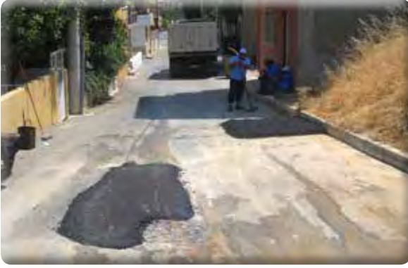
Aktepe Mahallesi asfalt yama yapılması işi.
