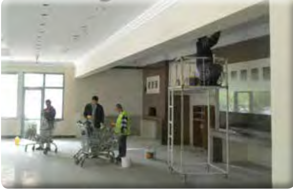
Gazikent Mahallesi Kardeş Ülkeler Müzesi tadilatı.
