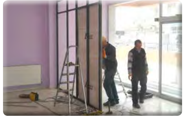
Gazi Mahallesi 25 Sokak Eski Zabıta Binası (Gazigem) tadilatı.
