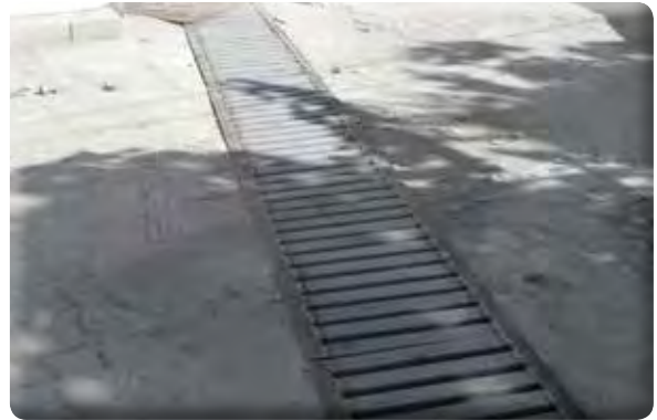
Atatürk Mahallesi 1018, 1038 Sokak ızgara yapılması işi.
