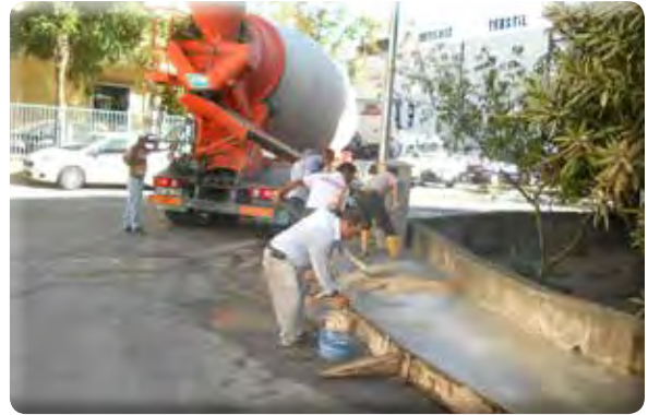
9 Eylül Mahallesi Menekşe Sokak kaldırım yapılması işi.
