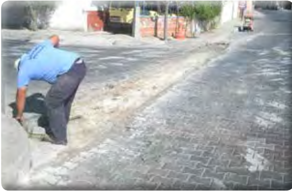
Atatürk Mahallesi 1018 Sokak kasis yapılması işi.
