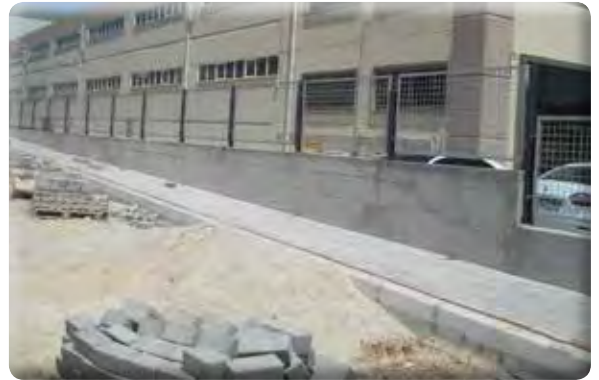
Fatih Mahallesi 1210 Sokak kaldırım çalışması.
