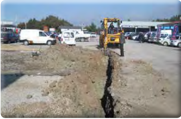
Beyazevler Mahallesi İzokom yağmur ızgarası yapılıması işi.
