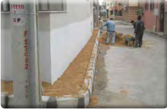
Irmak Mahallesi 36/1, 36/3, 36/5 sokaklar kaldırım yapılması işi.
