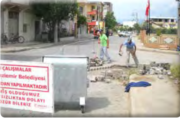
Menderes Mahallesi 1104 Sokak taş tamirâtı işi.
