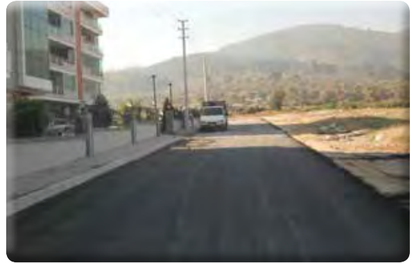
Irmak Mahallesi 38/31, 38/32 sokaklar asfalt yapılması işi.
