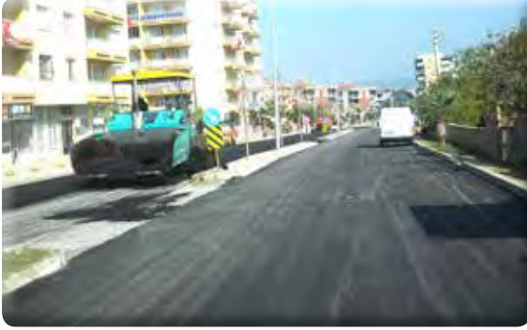
Irmak Mahallesi 38 ve 38/2 Sokaklar asfalt yapılması işi.
