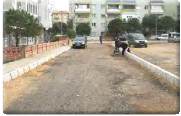
Atıfbey Mahallesi 8/2 ve 8/3 Sokaklar kaldırım yapılması işi.
