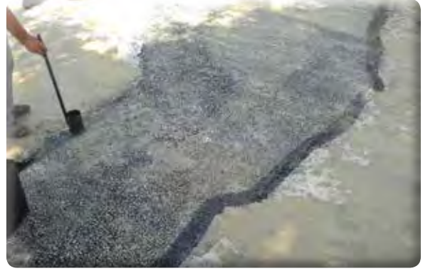
Sevgi Mahallesi 663 Sokak asfalt yama yapılması işi.
