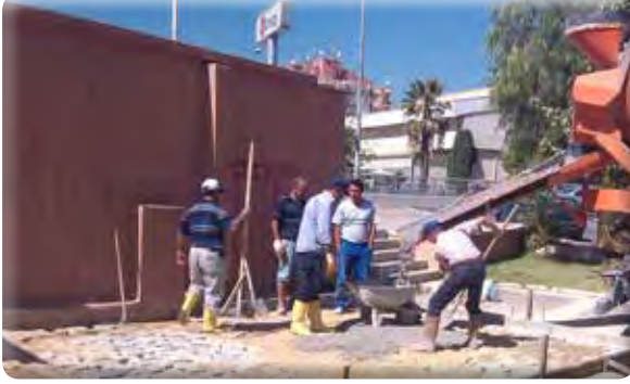
9 Eylül Mahallesi Şehitlik Parkı konteynır betonu atılması.
