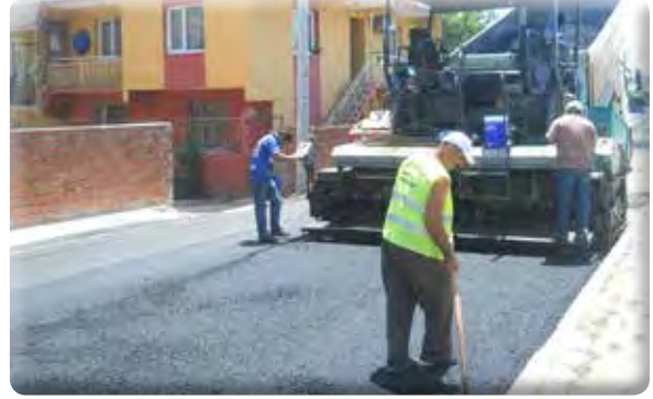
9 Eylül Mahallesi 351 Sokak asfalt yapılması işi.
