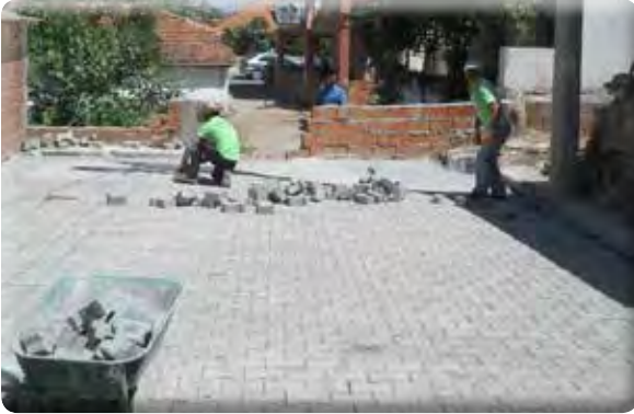
Fatih Mahallesi 1039/1 Sokak taş tamiri.
