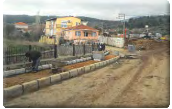
Irmak Mahallesi 38/1, 39, 700 sokaklar kaldırım yapılması işi.
