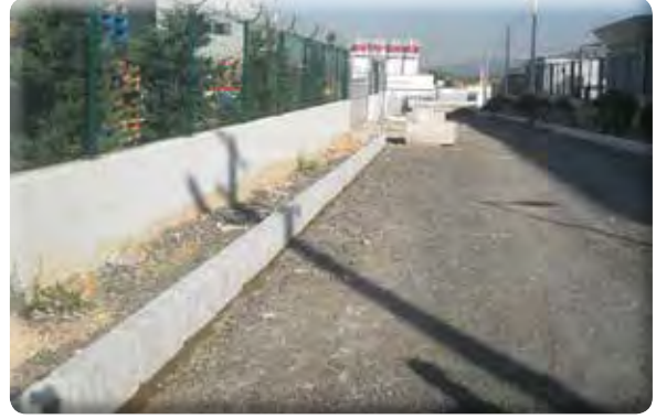
Fatih Mahallesi 1209 kaldırım yapılması işi.
