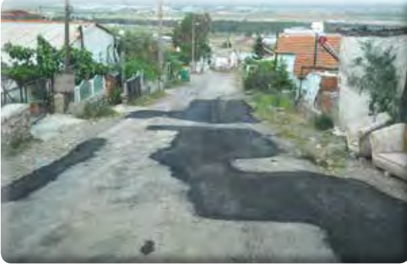
Sevgi Mahallesi 850 Sokak asfalt yama yapılması işi.
