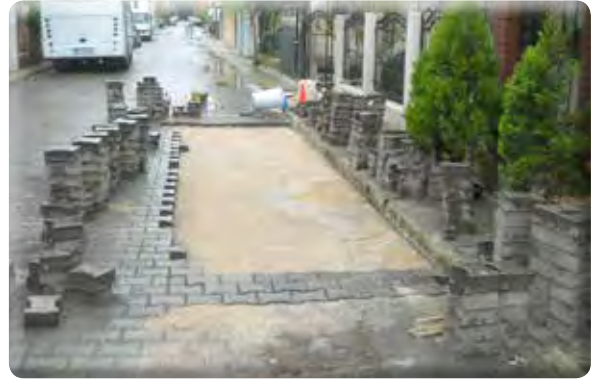
Hürriyet Mahallesi 1070 Sokak taş tameratı işi.
