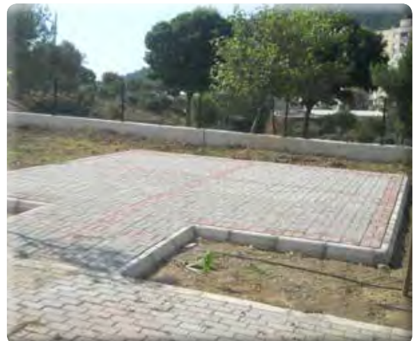
Zafer Mahallesi Evka-7 Camii kamelya yeri yapılması işi.
