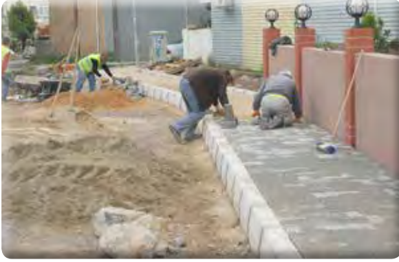
Gazi Mahallesi 28/13 ve 28/15 Sokak kaldırım yapılması işi.
