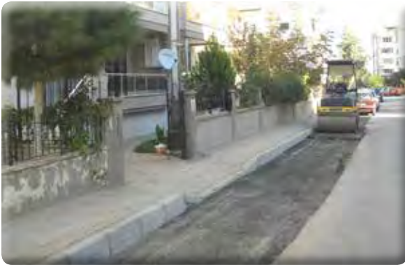
Gazi Mahallesi asfalt yama yapılması işi.
