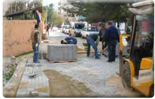
Atıfbey Mahallesi 5 Sokak taş tamirati.
