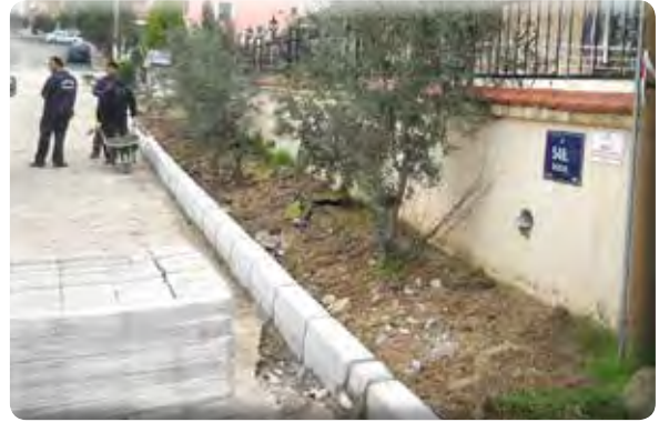
Beyazevler Mahallesi 546 Sokak kaldırım yapılması işi.
