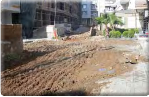
Atıfbey Mahallesi 2/3 Sokak yol yapılıması işi.
