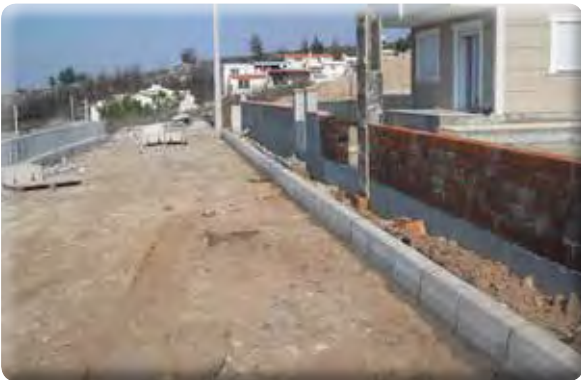
Beyazevler Mah. 560 ve 563 Sokak kaldırım ve istinat duvarı işi.
