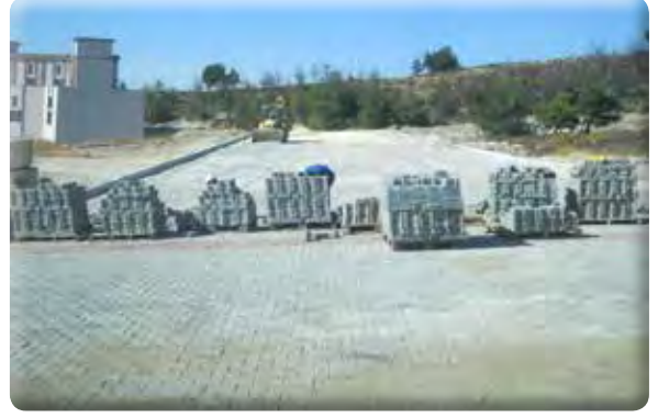
Beyazevler Mahallesi 556, 563 Sokaklar kilit taş döşenmesi işi.
