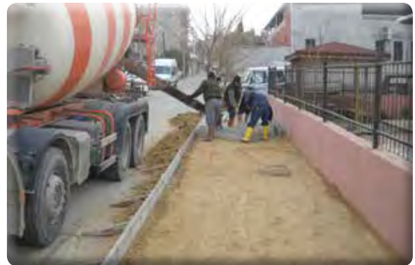
Hürriyet Mahallesi 1053 Sokak kaldırım yapılması işi.
