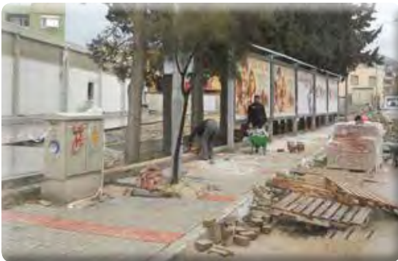
Gazi Mahallesi 28/24 Sokak kaldırım yenileme işi.
