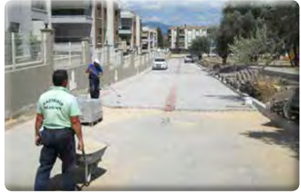
Irmak Mahallesi 703 Sokak taş döşeme yapılması işi.
