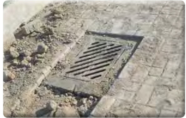
Bnb. Reşatbey Mah. 351/1 Sokak yağmur suyu ızgarası yapılması işi.
