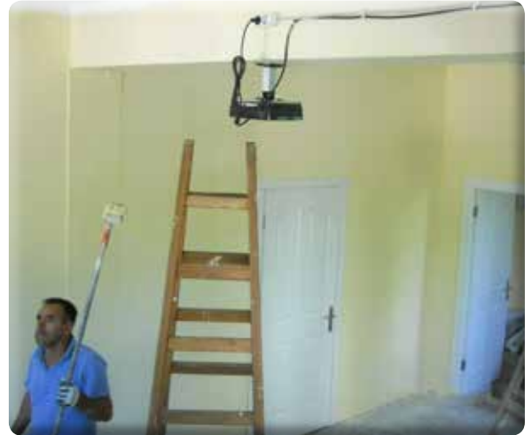
Atıfbey Mahallesi Gülhane Camii boya işi.
