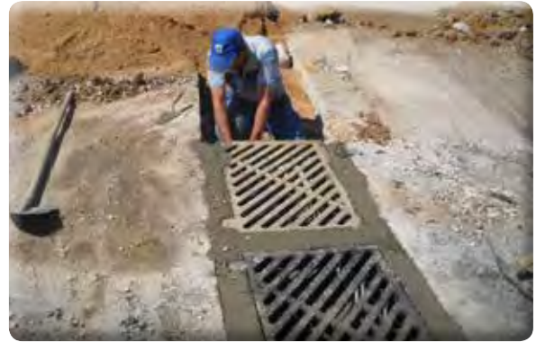
Yeşil Mahalle 651 Sokak Kipa Lisesi önü ızgara yapılması işi.
