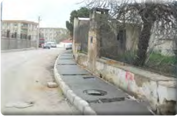
Irmak Mahallesi 39 Sokak ve 700 sokaklar kaldırım yapılması işi.
