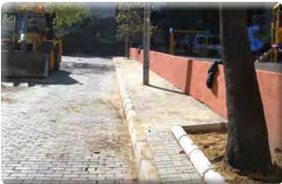
Gazikent Mahallesi 73/3 Sokak kaldırım yapılıması işi.
