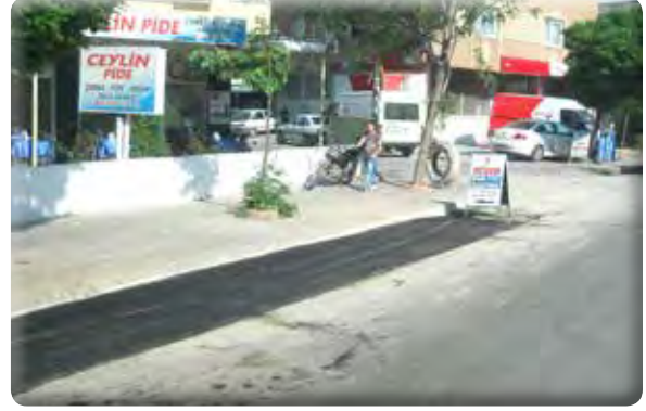
Atatürk Mahallesi Atatürk Caddesi asfalt yama yapılması işi.
