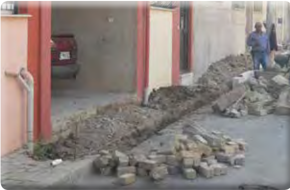
Dokuz Eylül Mahallesi 319 Sokak kaldırım yapılması işi.
