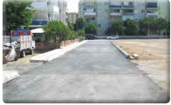
Gazi Mahallesi 8/3, 13, 28/24 Sokak ve Hasan Güven Caddesi asfalt yapılması işi.
