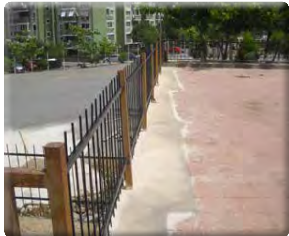
Yeşil Mahalle 651 Sokak Kıpa Lisesi bahçe içi tamirâtı.
