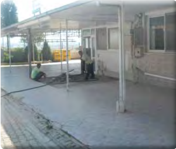
Sevgi Mahallesi Mehmet Akif Ersoy camii bahçe düzenlemesi işi.
