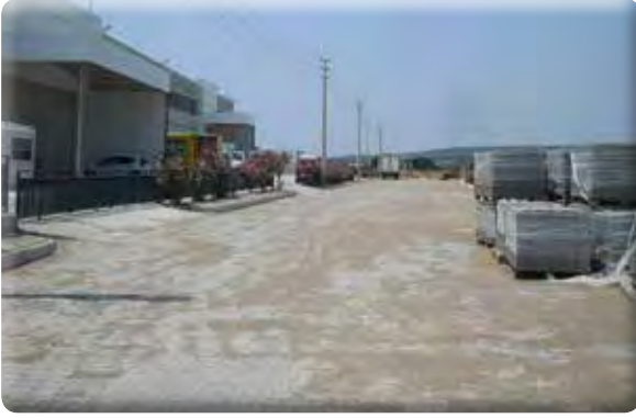
Fatih Mahallesi 1210 Sokak kaldırım ve yol yapılması işi.
