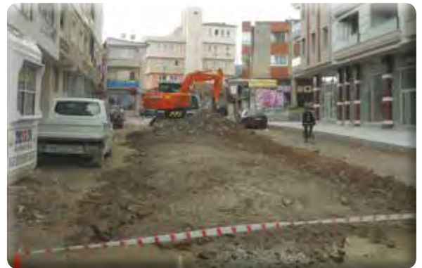
Irmak Mahallesi Hasan Güven Caddesi 31 ile 23 Sokaklar arası taş sökümü ve malzeme serimi işi.
