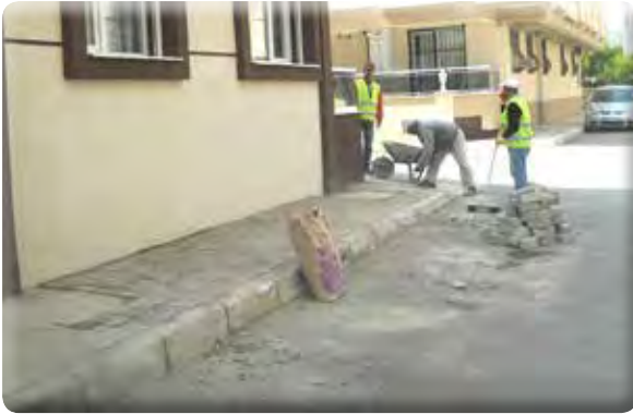
Irmak Mahallesi 19 Sokak kaldırım tameratı işi.
