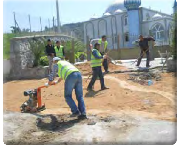
Yeşil Mahalle Özer Acıtaş Camii önu taş döşeme işi.
