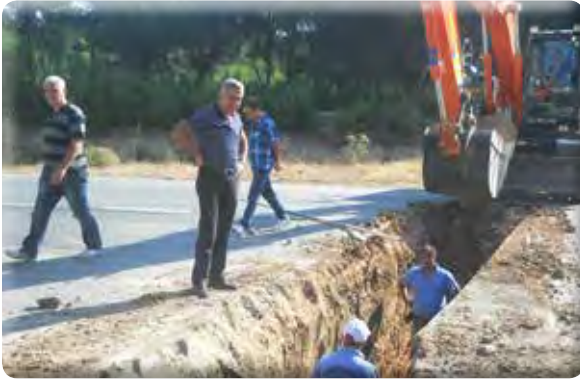
Hürriyet Mahallesi 1075 Sokak kanal yapılması işi.
