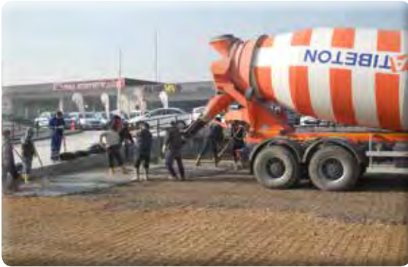
Beyazevler Mahallesi İzokom yağmur suyu ızgara yapımı ve otopark betonu atılması işi.
