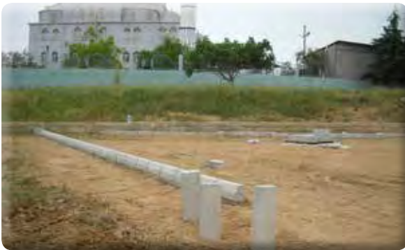
Aktepe Mahallesi park yapılması işi.
