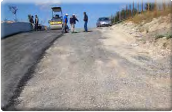
Fatih Mahallesi asfalt yapılması işi.
