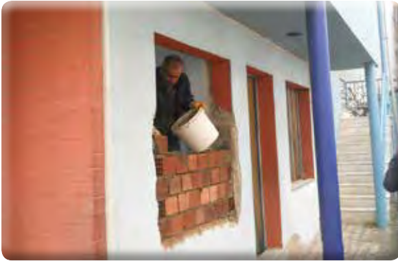
Gazi Mahallesi 25 Sokak Sağlık İşleri tadilatı.
