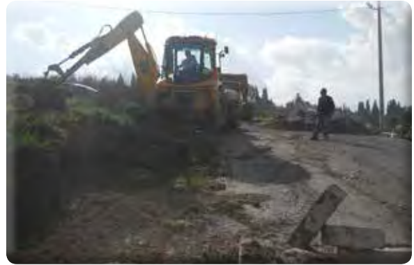
Beyazevler Mahallesi 548/1 ve 547 Sokaklar kaldırım yapılması işi.
