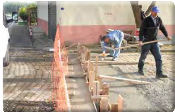
Hürriyet Mahallesi 1083, 1084 ve 1086 Sokaklar ızgara yapılıması işi.
