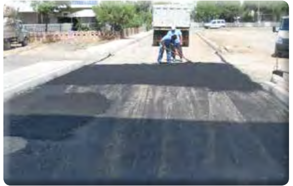
Atıfbey Mahallesi asfalt yapılması işi.
