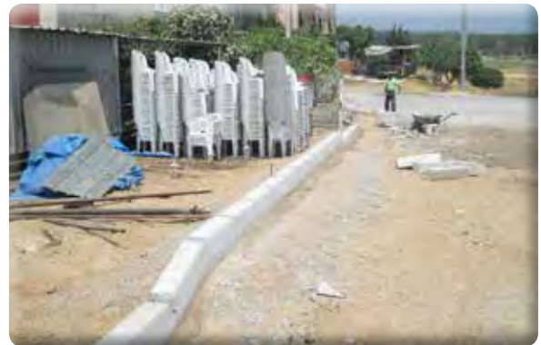
9 Eylül Mahallesi 351, 364 Sokak kesişimi kaldırım yapılması işi.
