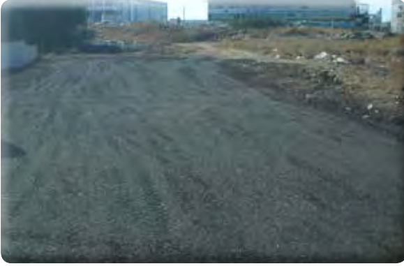
Fatih Mahallesi 1210 Sokak asfalt kırığı serimi yapılması işi.
