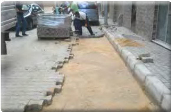
Atıfbey Mahallesi 9 Sokak taş tamirati yapılması işi.
