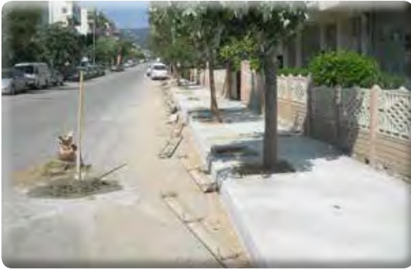
Yeşil Mahalle 56 Sokak kaldırım yapılması işi.
