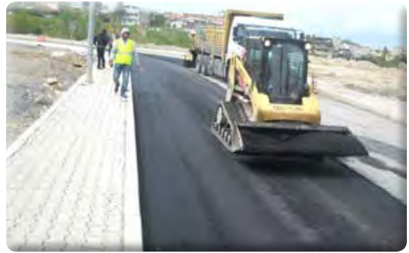
9 Eylül Mahallesi 309, 315, Orhangazi Caddesi ve Ulaştırma alt geçidi asfalt yapılması işi.
