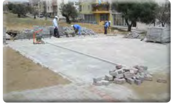
Aktepe Mahallesi Ensari Camii yanı park yapılması işi.
