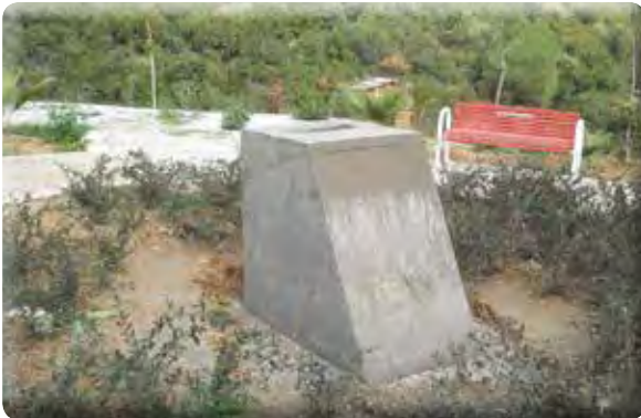
Zafer Mahallesi Evka 7 park içi heykel kaidesi işi.
