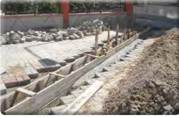
Atıfbey Mahallesi Etiler Caddesi No: 49 ızgara yapılması işi.
