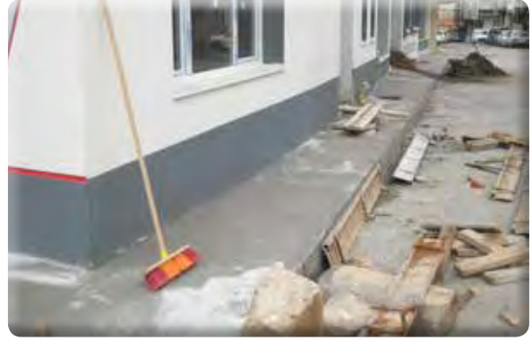
Yeşil Mahalle 40 ve 50 sokaklar kaldırım çalışması.
