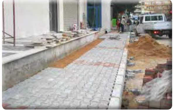
Gazi Mah. 25 Sokak Yb. Refik Cesur Caddesi kaldırım yapılması işi.
