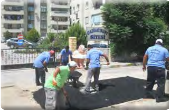
Irmak Mb. 36/3, 37, 38/2 Sk. H. Güven Cd. asfalt yama yapılması işi.
