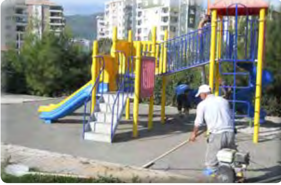
Irmak Mahallesi Gülhan Boran Parkı beton atılması işi.
