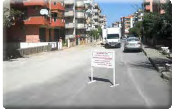
Gazi Mahallesi 28/25 Sokak kaldırım yapılması işi.
