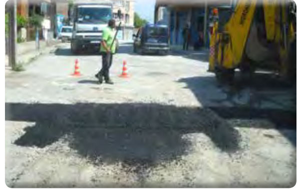
Emrez Mahallesi asfalt yama yapılması işi.
