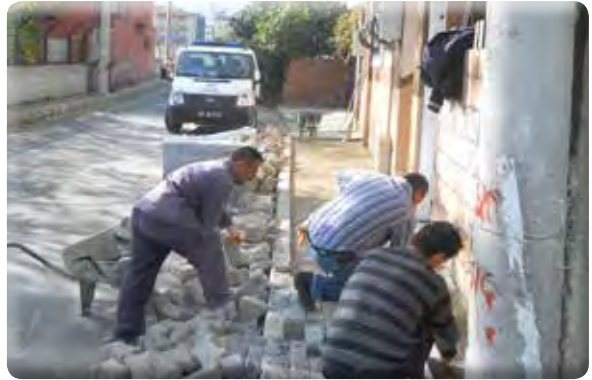
9 Eylül Mahallesi 318 Sokak kaldırım yapılması işi.
