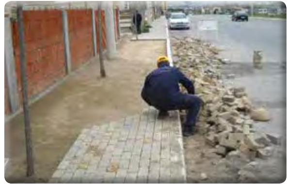
9 Eylül Mahallesi 369 Sokak kaldırım tamirâtı.
