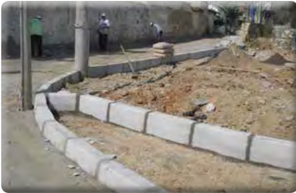
Irmak Mahallesi Seydi Baba Türbesi bordür taş ve kayrak işi.
