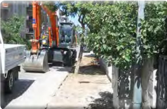
Gazi Mahallesi 27 Sokak kaldırım yapılması işi.
