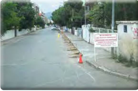
Gazi Mahallesi 27 Sokak kaldırım yapılması işi.
