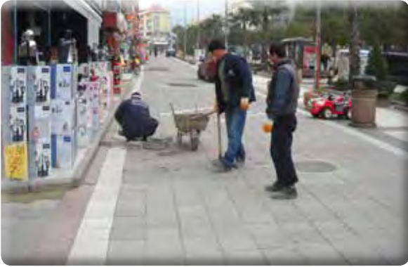
Atıfbey Mahallesi Sevgi Yolu 2. Etap tamirat işi.
