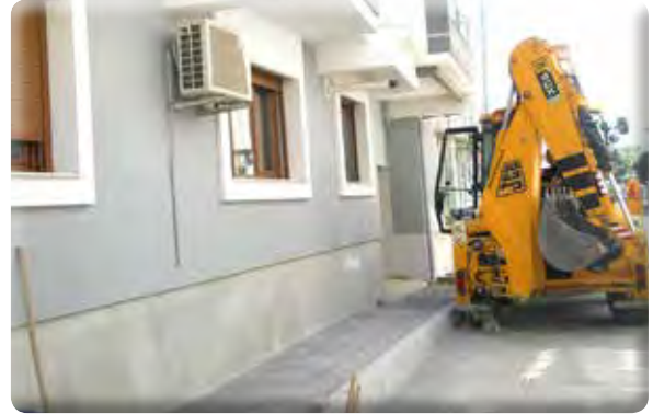
Yeşil Mahalle 53 ve 46/2 sokaklar kaldırım yapılması işi.
