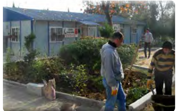
Sevgi Mahallesi Atatürkçü Düşünce Derneği tadilatı işi.
