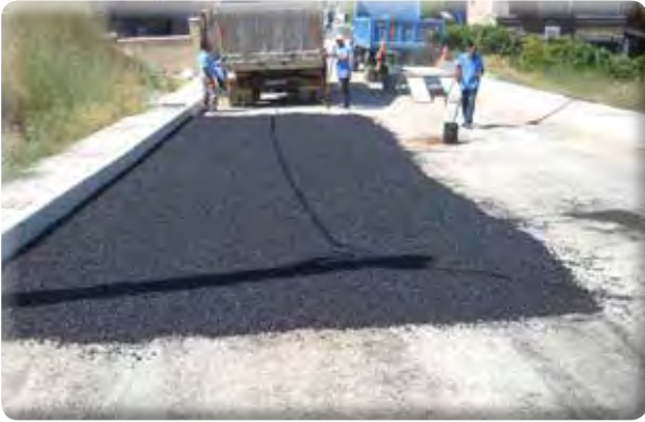
Beyazevler Mahallesi 548/1 Sokak asfalt yama yapılması işi.
