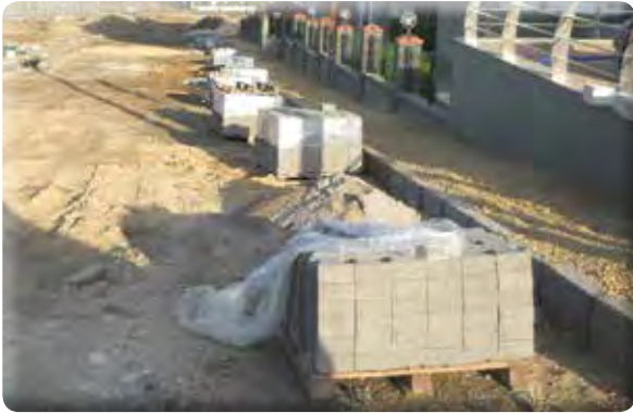
Irmak Mahallesi 38/6 Sokak kaldırım yapılması işi.
