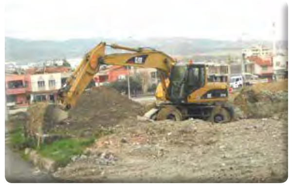
Beyazevler Mahallesi 547 Sokak park yapılması işi.
