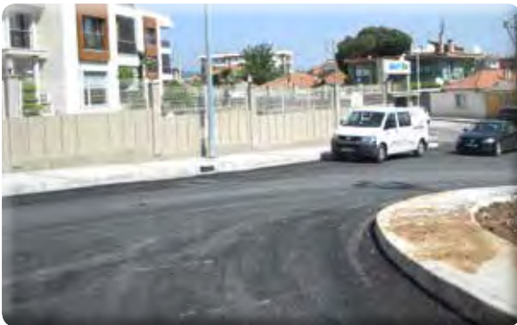
Irmak Mahallesi 700, 703, 702 Sokaklar asfalt yapılması işi.
