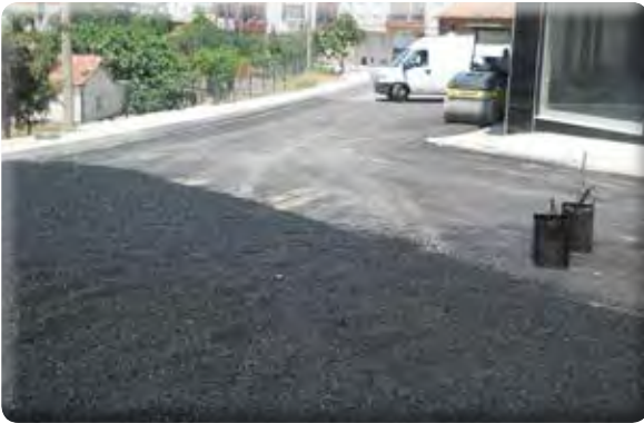
Yeşil Mahalle 650 Sokak asfalt yapılması işi.
