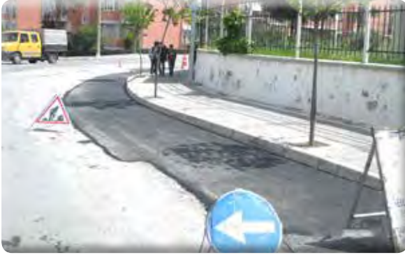
Sevgi Mahallesi Nevvar Salih İğören Caddesi asfalt yama yapılması işi.
