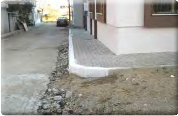
Irmak Mahallesi 34 Sokak kaldırım yapılması işi.
