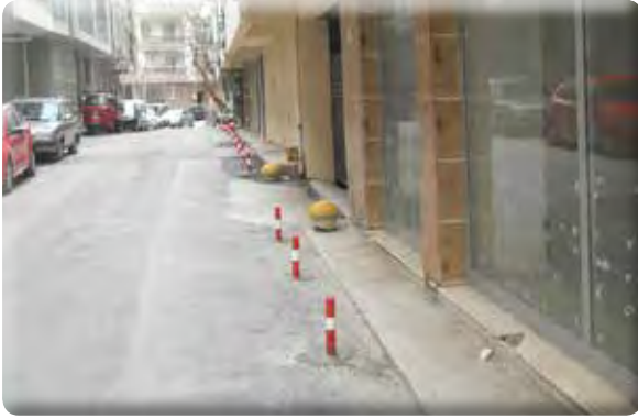
Yeşil Mahalle 52 Sokak demir bariyer dikilmesi işi.
