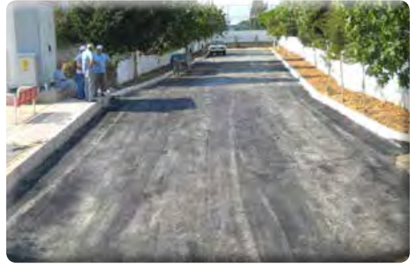
Yeşil Mahalle 41 Sokak asfalt yapılması işi.
