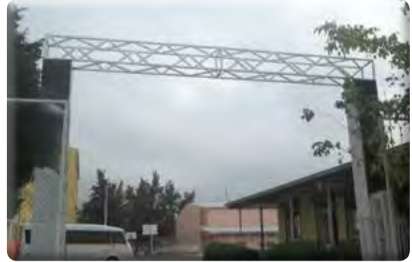
Beyazevler Mahallesi Ticaret Meslek Lisesi tak yapılması işi.
