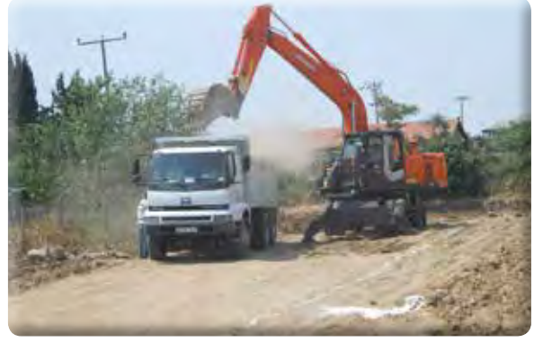
9 Eylül Mahallesi 693 Sokak açılması işi.
