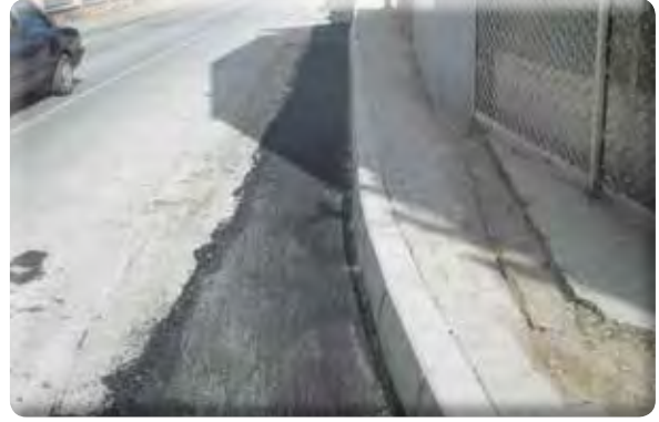
Gazi Mahallesi 28/24 ve Millet Caddesi asfalt yama yapılması işi.
