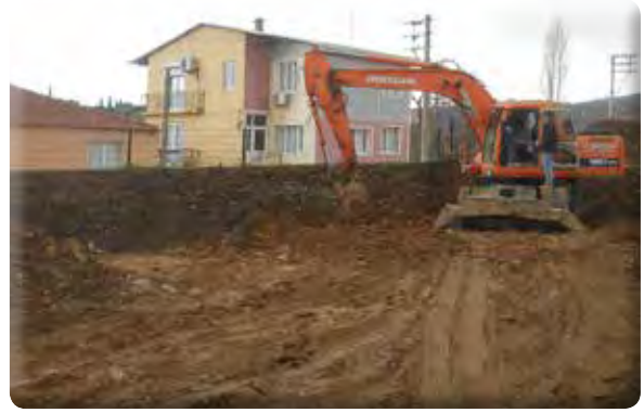
Irmak Mahallesi Seydi Baba Türbesi hafriyat yapılması işi.
