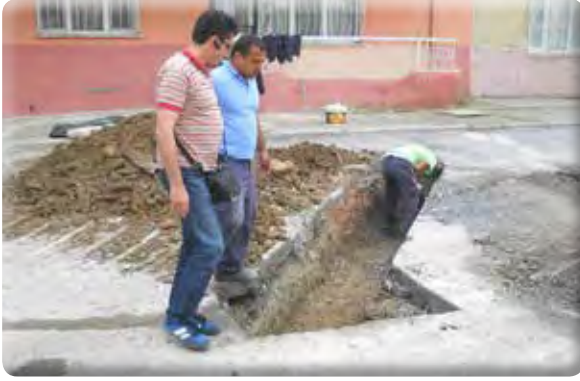
Irmak Mahallesi 38/10 Sokak yağmur suyu ızgarası yapılması işi.
