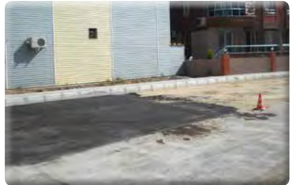
Gazi Mb. 16, 17, 28/15 Sk. ve Kubilay Cd. asfalt yama yapılması işi.
