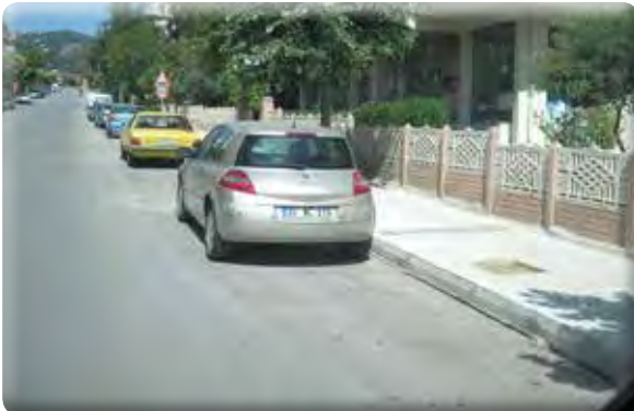
Yeşil Mahalle 56 Sokak kaldırım yapılması işi.
