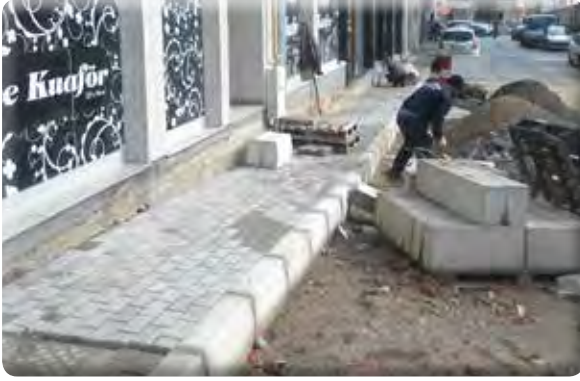
Atıfbey Mahallesi 5 kaldırım yapılması işi.
