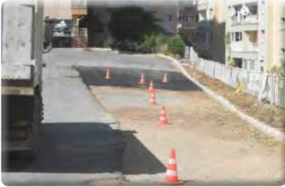
Zafer Mahallesi 810 ve 812 Sokaklar asfalt çalışması.
