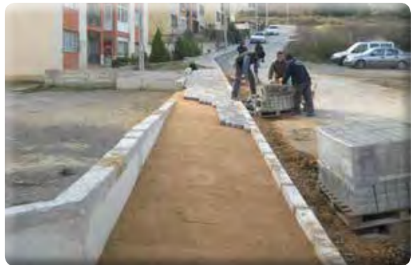
Zafer Mahallesi 804 Sokak kaldırım yapımı.
