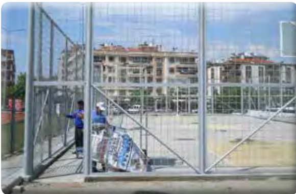
Gazikent Mahallesi Basketbol sahası boya işleri.
