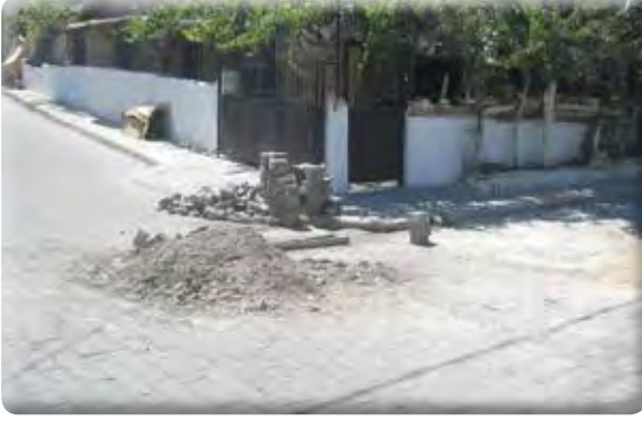
Fatih Mahallesi 1142 Sokak yağmur ızgarası yapılması işi.
