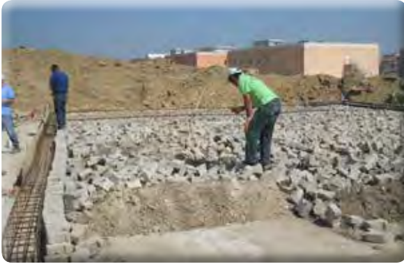
Sevgi Mahallesi Heykeltraş Evi temel atma işi.
