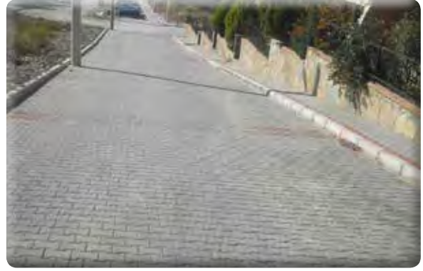
Beyazevler Mahallesi 560, 563, 555, 555/1 Sokaklar kaldırım ve taş döşenmesi işi.
