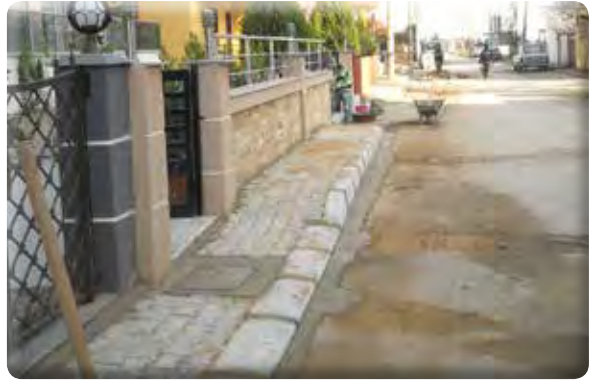
Irmak Mahallesi 97 Sokak kaldırım yapılması işi.
