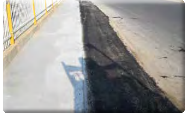
9 Eylül mahallesi 349 Sokak asfalt yama yapılması işi.
