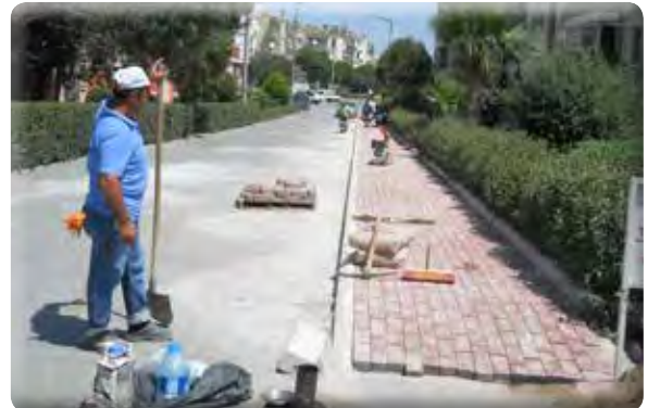
Yeşil Mahalle 59 Sokak kaldırım yapılması işi.
