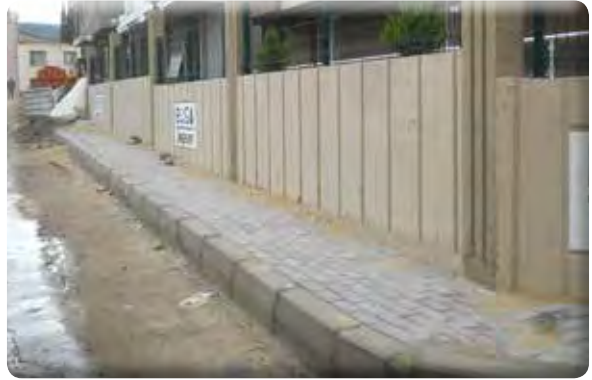
Irmak Mahallesi 35 ve 37 Sokaklar kaldırım yapılması işi.
