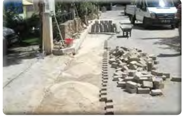
Atıfbey Mahallesi 11/1 Sokak taş tamirâtı işi.
