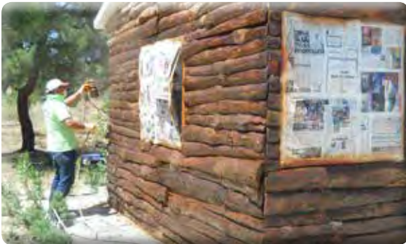
Fatih Mahallesi Sarnıç Sosyal Tesisler boya işleri.
