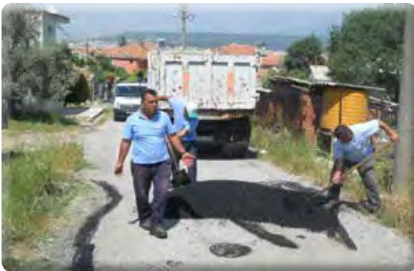
Yeşil Mahalle 40 Sokak asfalt yama işi.
