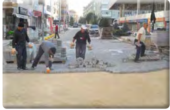
Atıfbey Mahallesi 6/4 Sokak taş döşenmesi işi.
