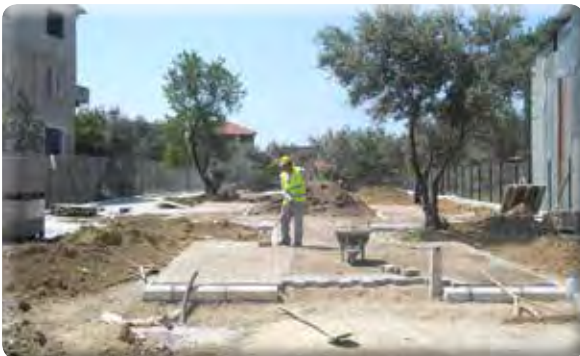
Atatürk Mahallesi 1040 Sokak park yapılması işi.
