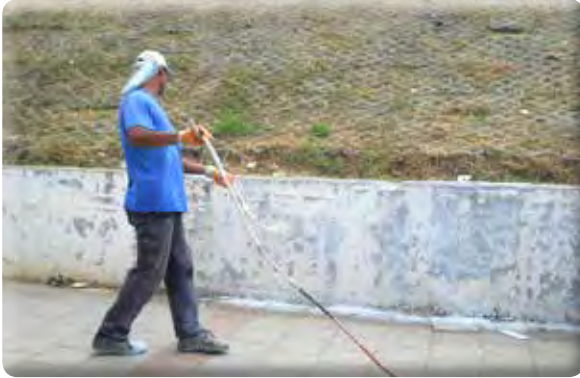
Sevgi Mahallesi Nevvar Salih İşören Caddesi kireçleme işi.
