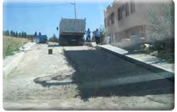
Beyazevler Mahallesi asfalt yapılması işi.
