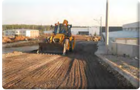
Fatih Mahallesi 1194/1, 1194/2, 1195, 1197, 1191, 1208, 1209 Sokaklar asfalt hazırlığı ve asfalt atılması işi.
