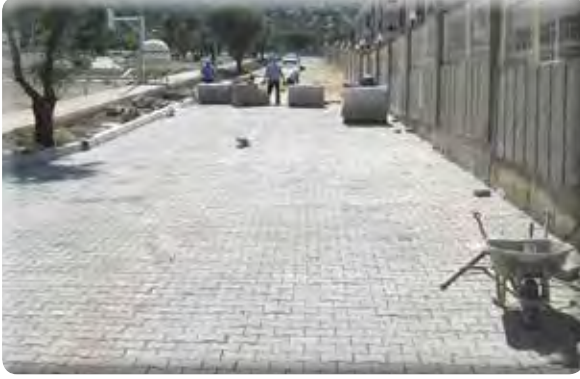
Irmak Mahallesi 703 Sokak park yanı kaldırım ve yol yapılması işi.
