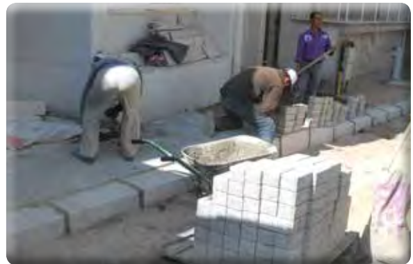
Gazi Mahallesi 17 Sokak kaldırım yapılması işi.
