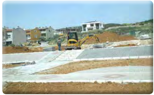
Beyazevler Mahallesi 544 Sokak park yapılması işi.
