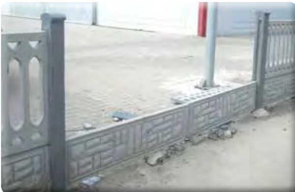
Fatih Mahallesi Uçak Teknolojileri MYO bahçe çit onarımı işi.
