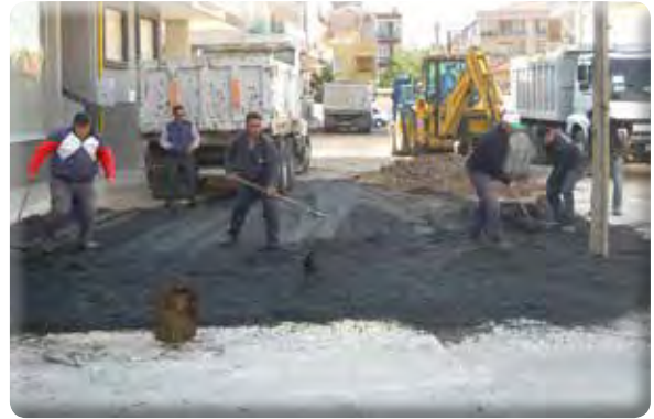
Irmak Mb. 711, 713 Sk. ve Hasan Güven Cd. asfalt yapılması işi.
