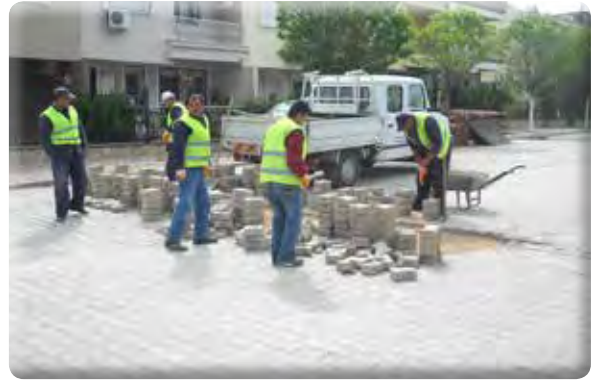
Beyazevler Mahallesi 556 Sokak taş tamiri işi.
