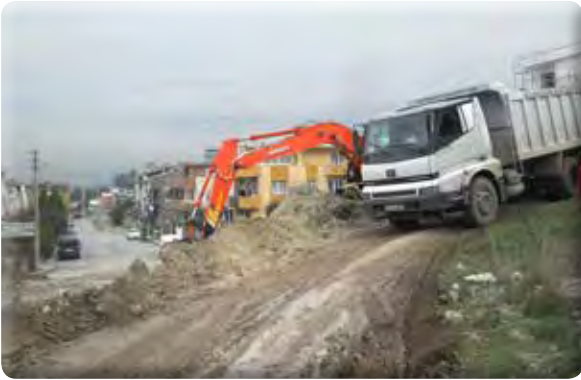
Beyazevler Mahallesi 547 Sokak yol açılması işi.
