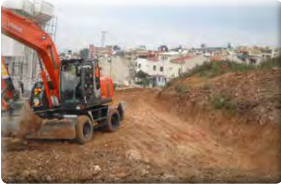
Beyazevler Mahallesi 547 Sokak yol açılması işi.
