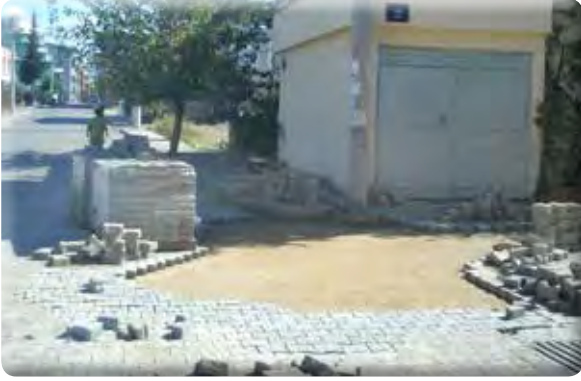
Menderes Mahallesi 1115 Sokak taş tamiri işi.
