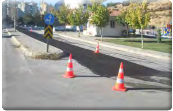
Zafer Mahallesi 800 ve 810 sokaklar asfalt yama yapılması işi.
