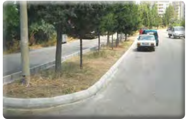
Zafer Mahallesi 801 Sokak orta refüj bordür döşemesi.
