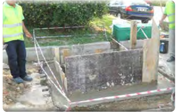
Sevgi Mahallesi Ünsal Yaman Parkı beton işi.
