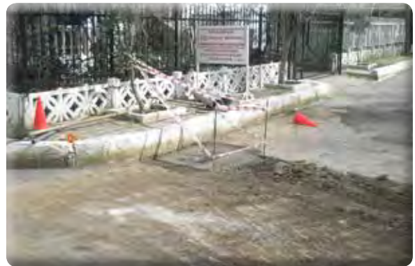
Beyazevler Mahallesi 521 Sokak kaldırım düzenleme ve ızgara yapılması işi.
