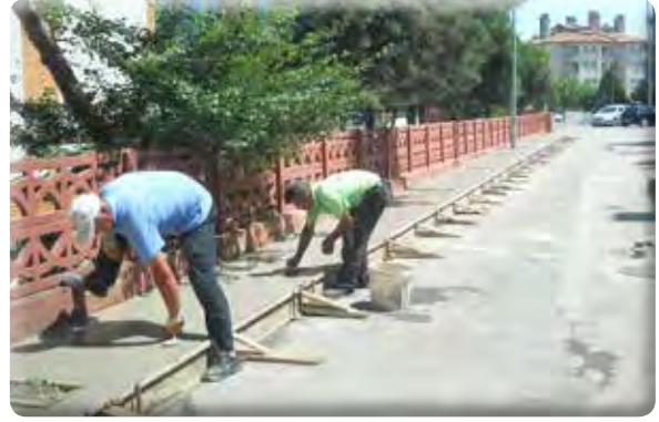
Atıfbey Mahallesi 6 Sokak kaldırım yapılması işi.
