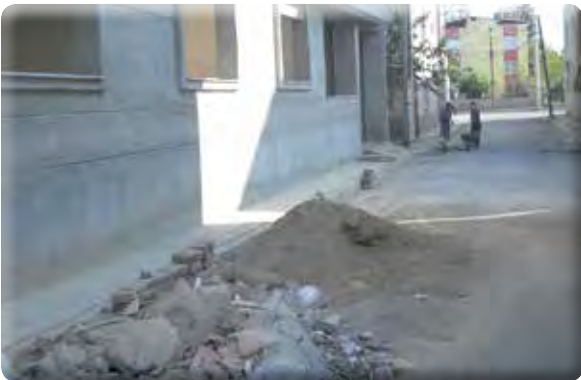
9 Eylül Mahallesi 319 Sokak kaldırım yapılması işi.
