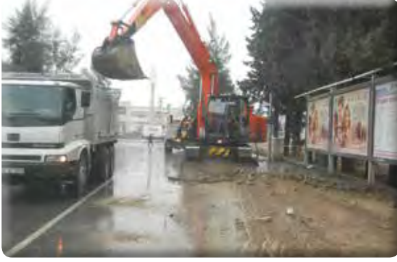
Gazi Mahallesi 28/24 Sokak kaldırım yenileme işi.
