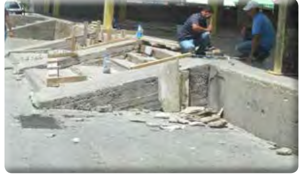
Atıfbey Mahallesi Merkez Pazar yeri merdiven tamir işi.
