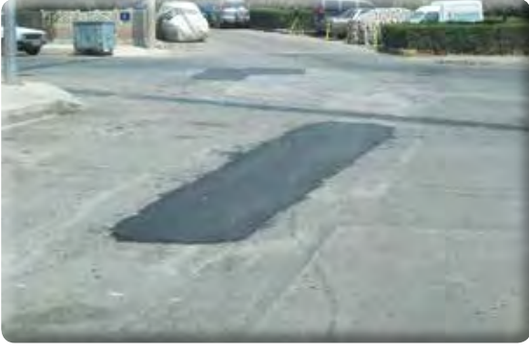
Yeşil Mahalle 56 ve 59 Sokaklar asfalt yama yapılması işi.
