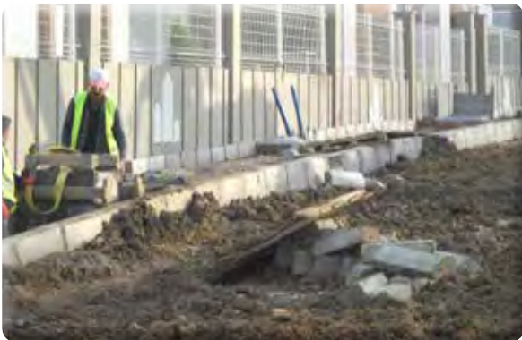
Irmak Mahallesi 700 Sokak kaldırım ve yol yapılması işi.
