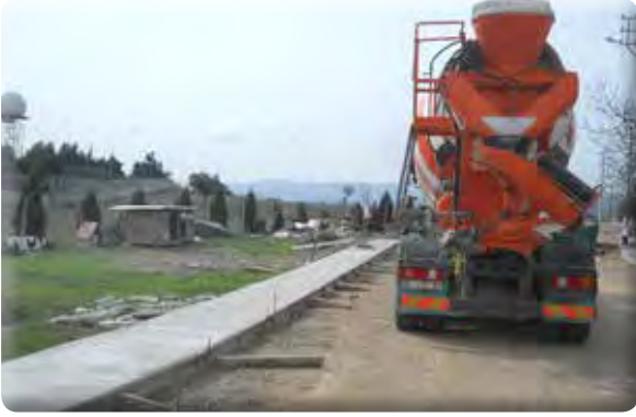
Atatürk Mahallesi 1112/1 Sokak kaldırım yapılması işi.
