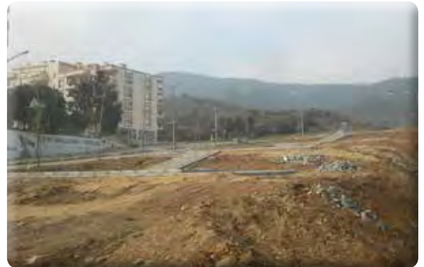
Zafer Mahallesi 800 Sokak Park yapılıması işi.
