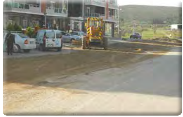
Irmak Mahallesi 38 Sokak stabilize malzeme serimi işi.
