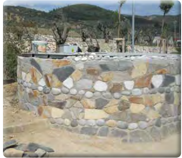
Irmak Mahallesi Seydibaba Türbesi kayrak kaplama çalışması.
