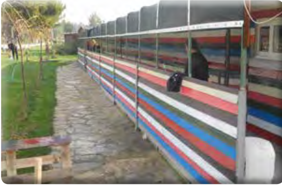
Fatih Mahallesi Sarnıç Sosyal Tesisleri boya işleri.
