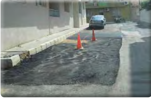
Gazi Mahallesi 17 ve 27 sokaklar asfalt yama yapılması işi.
