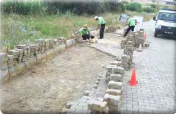
Zafer Mahallesi 801 Sokak taş tamirâtı işi.
