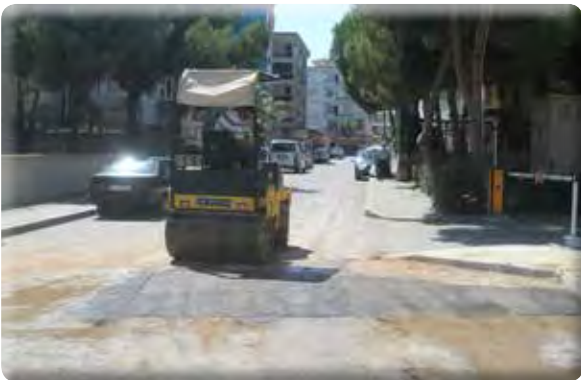
Gazi Mahallesi Muhtelif Bölgelerinde asfalt yama yapılması işi.
