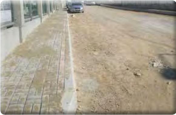
Fatih Mahallesi 1194/1 Sokak kaldırım yapılması işi.
