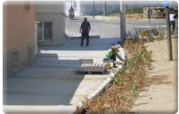
Irmak Mahallesi 39 Sokak Park içi kaide yapımı ve bordür işi.
