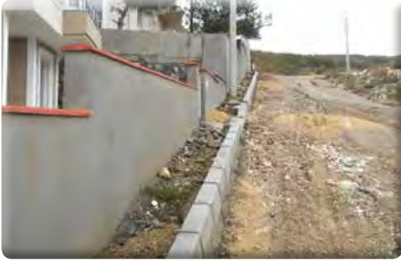
Beyazevler Mahallesi 584 ve 563 Sokaklar kaldırım yapılması işi.
