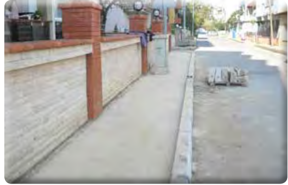
Gazi Mahallesi 28/17 ve 28/16 kaldırım yapılıması işi.
