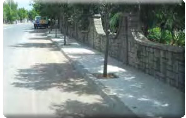
Fatih Mahallesi Ege Caddesi kaldırım yapılması işi.
