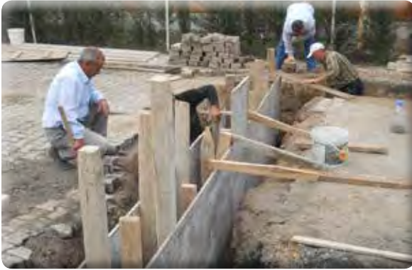
Hürriyet Mahallesi 1083, 108 ve 1086 Sokaklar ızgara yapılması işi.
