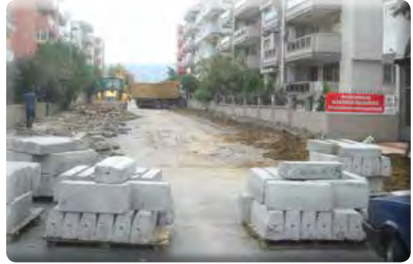
Gazi Mahallesi 28/25 Sokak kaldırım yapılması işi.
