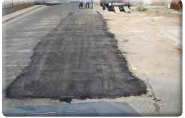
9 Eylül Mahallesi 315, 316 ve 319 Sokaklar asfalt yama yapılması işi.
