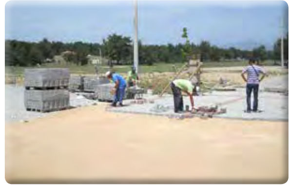
Fatih Mahallesi Sarnıç Sosyal Tesisleri girişi taş döşenmesi işi.
