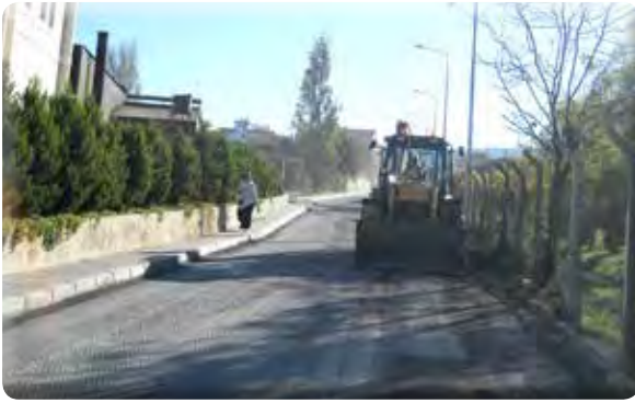
Gazi Mahallesi Hasan Güven Caddesi asfalt işi.
