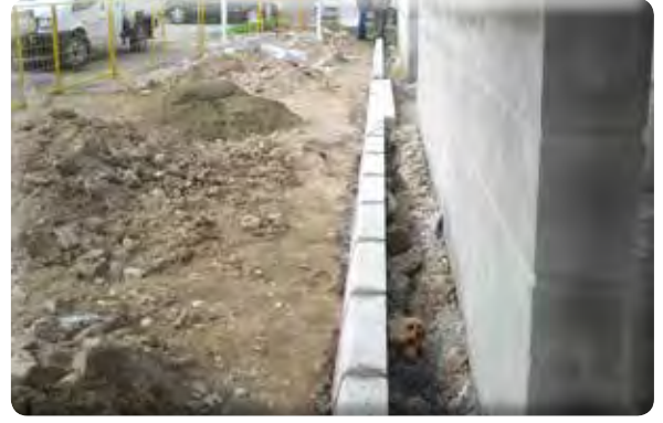
Gazi Mahallesi 27 Sokak kaldırım yapılması işi.
