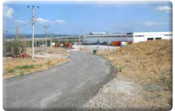
Sevgi Mahallesi 955 Sokak asfalt kırığı serimi yapılması işi.
