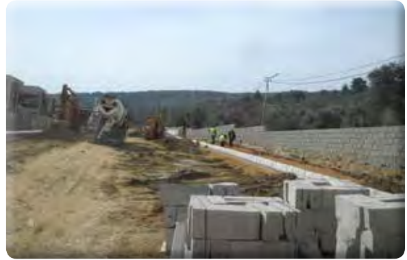
Irmak Mahallesi 700, 702, 703 sokaklar asfalt hazırlığı.
