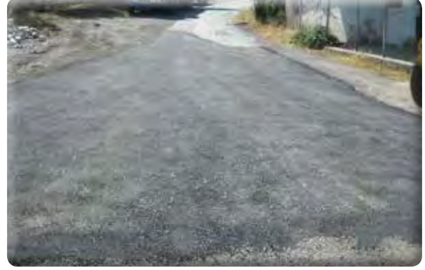
Sevgi Mahallesi asfalt yapılması işi.
