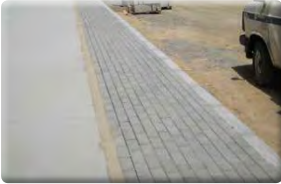
Irmak Mahallesi Hasan Güven Caddesi kaldırım yapılması işi.
