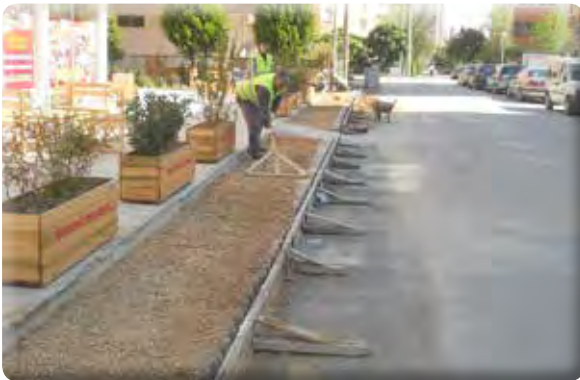
Atıfbey Mahallesi 6 Sokak kaldırım yapılması işi.
