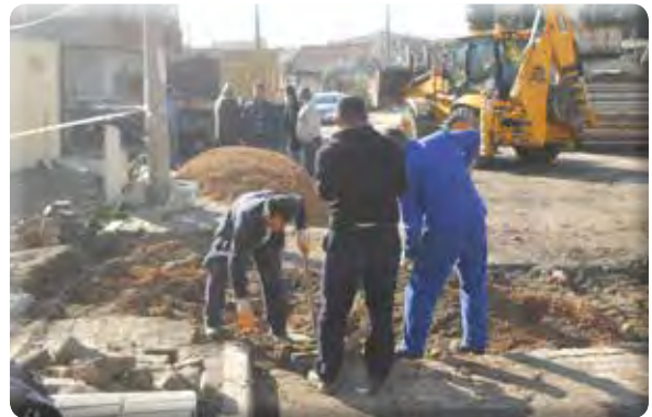
Fatih Mahallesi 1188/1 Sokak taş tamirâtı.
