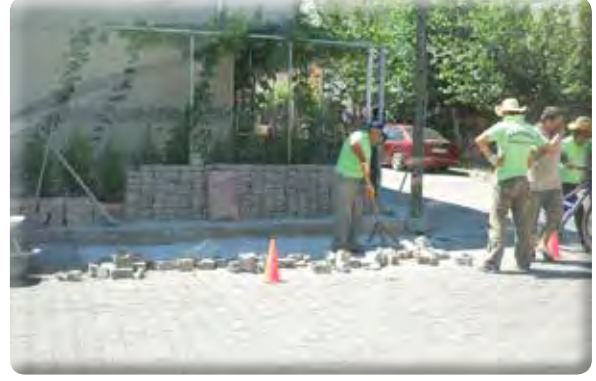
Hürriyet Mahallesi Vatan Caddesi taş tamiratı işi.
