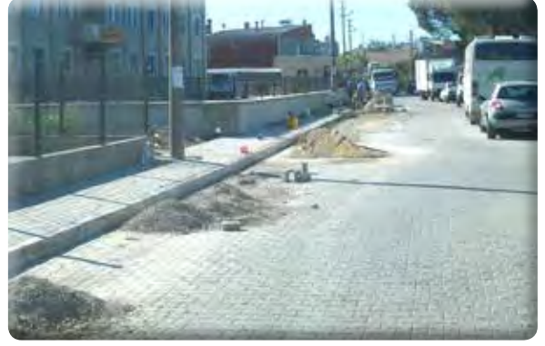
Fatih Mahallesi 1187/1 Sokak kaldırım tamirata yapılması işi.
