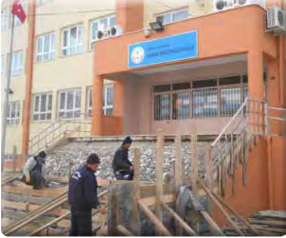
Yeşil Mahalle Sabiha Gökçen İ.Ö.Okulu merdiven yapılması işi.
