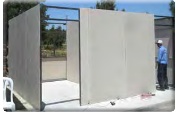
Fatih Mahallesi Sarnıç Sosyal Tesisleri pasta odası yapılması işi.
