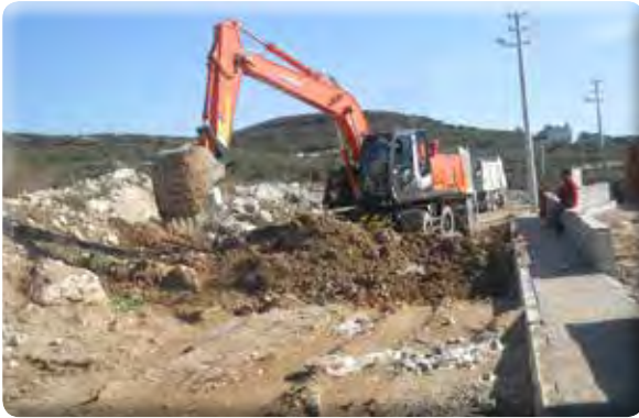
Beyazevler Mahallesi 563 Sokak yol açılması işi.
