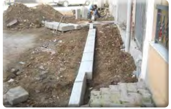
Gazi Mahallesi 22 Sokak kaldırım yapılması işi.
