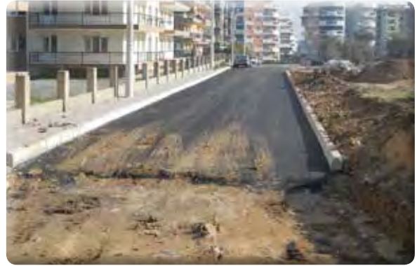
Irmak Mahallesi 38/22 Sokak asfalt yapılması işi.
