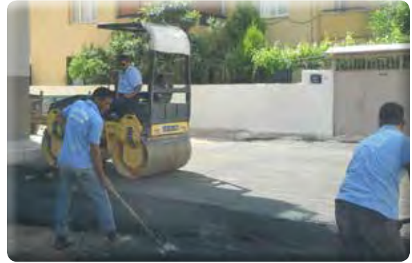
Irmak Mahallesi 19 Sokak asfalt yama yapılması işi.
