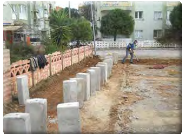
Atıfbey Mahallesi 8/2 ve 8/3 Sokaklar yol yapımı işi.
