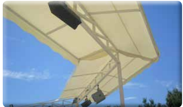
Fatih Mahallesi Sarnıç Sosyal Tesisler sabne üzeri branda takılması.
