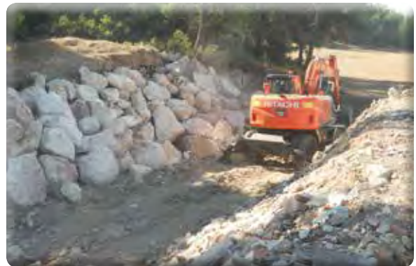
Atatürk Mahallesi Sarınc Gölet çıkış savaklarına taş duvar yapılması işi.
