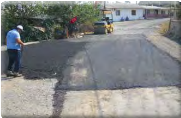
Sevgi Mahallesi 950 Sokak asfalt yapılması işi.
