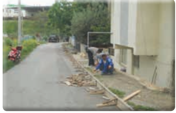
Irmak Mahallesi 38/16 Sokak kaldırım yapımı işi
