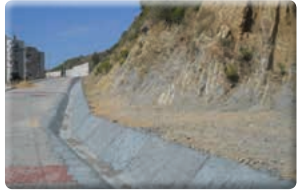
Zafer Mahallesi 813 Sokak V kesit yapımı işi
