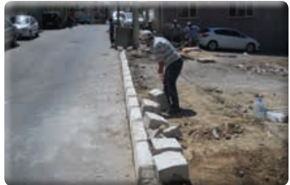
Emrez Mahallesi 194 Sokak Bordür yapımı işi
