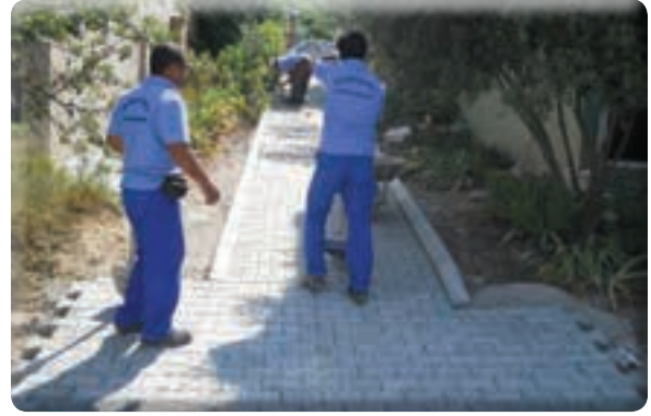
Beyazevler Mahallesi genel tamiratlar
