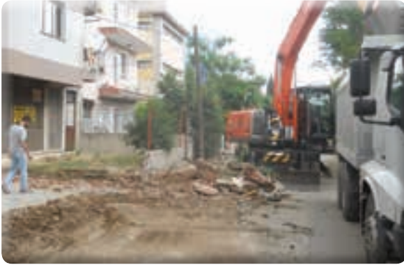
9 Eylül Mahallesi Çiçek Sokak kaldırım yenileme işi
