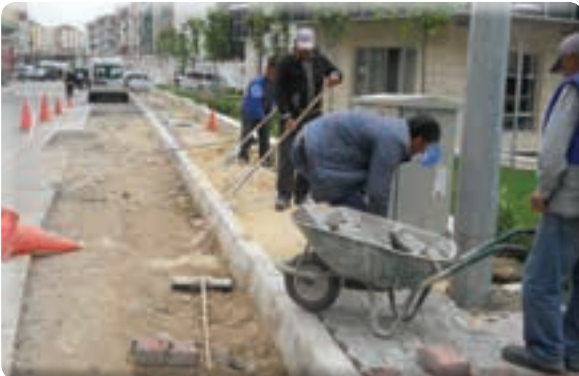
Gazi Mahallesi 16 Sokak kaldırım yapımı işi
