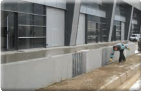
Fatih Mahallesi 1203 Sokak Kaldırım yapılması işi
