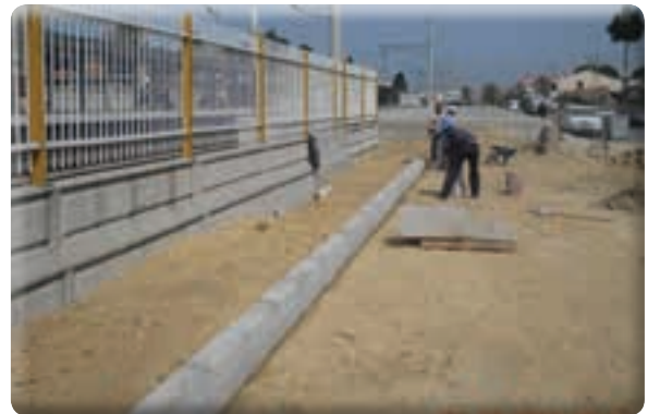
9 Eylül Mahallesi 351 Sokak kaldırım yapımı işi
