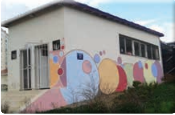
Zafer Mahallesi Cumhuriyet Semt Evi Tuvalet Boya Çalışması
