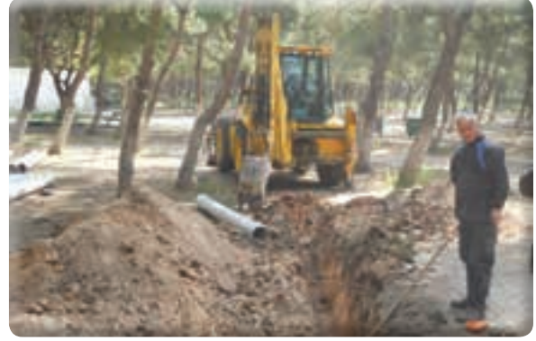
Fatih Mahallesi Sarnıç Piknik Alanı tuvaletlerin kanal bağlantısının yapılması işi
