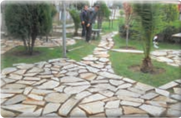
Fatih mahallesi 1194 sokak dolmuş son durakları otopark yapımı ve kayrak döşenmesi iş
