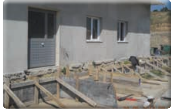
Sevgi Mahallesi hayvan barınakları inşaat işleri
