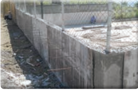
Zafer Mahallesi basketbol sahasına perde beton yapılması işi
