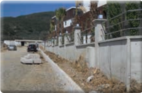
Irmak Mahallesi 38 Sokak kaldırım yapımı işi
