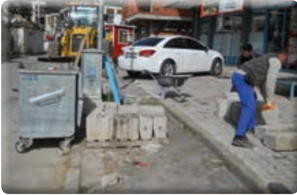
Irmak Mahallesi 31 Sokak ve 35 sokaklar kaldırım çalışması
