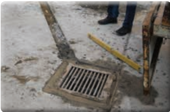
Gazikent Mahallesi 80/4 Sokak Izgara yapımı işi
