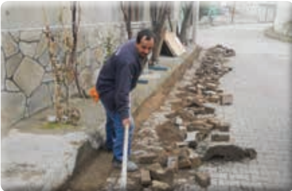
Menderes Mahallesi 1002 Sokak taş tamiratı işi
