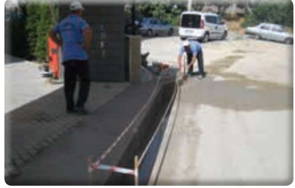
Irmak Mahallesi 38/14 Sokak İzgara yapımı işi
