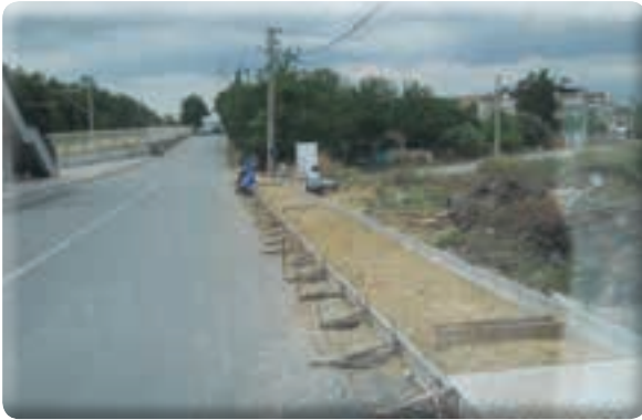
9 Eylül Mahallesi 351 Sokak kaldırım yapımı işi
