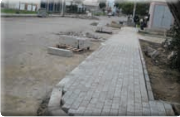
Beyazevler Mahallesi 518 Sokak kaldırım çalışması
