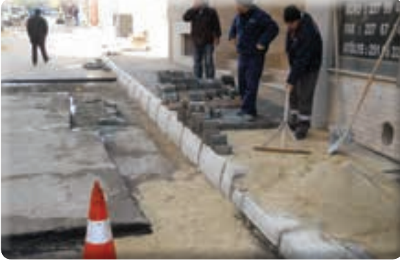
Gazi Mahallesi Millet Caddesi kaldırım yapımı işi
