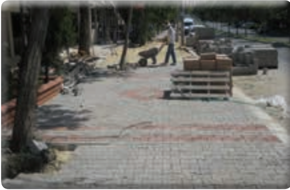
Gazikent Mahallesi Abdulhamit Yavuz Caddesi kaldırım yapımı işi
