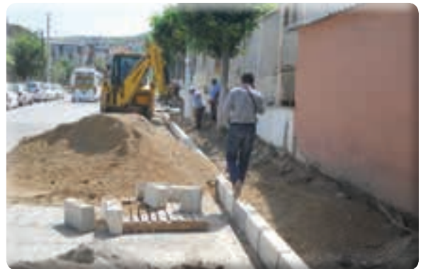
Beyazevler Mahallesi 518-539-541-542 Sokak kaldırım yenileme işi
