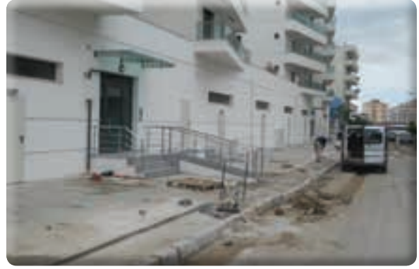
Atıfbey Mahallesi 67 Sokak kaldırım yapımı işi
