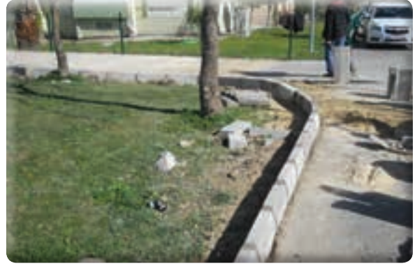
Sevgi Mahallesi 667 Sokak Bordür döşenmesi işi
