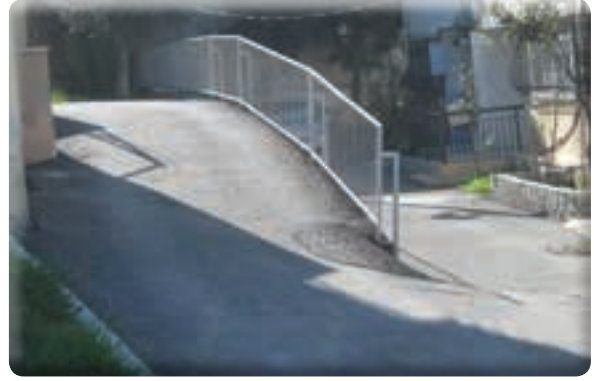
Beyazevler Mahallesi 556 Sokak korkuluk yapım işi
