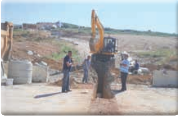
Beyazevler Mahallesi 548/2 Sokak pis su kanal hattı yapılması işi
