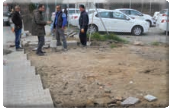
Aktepe Mahallesi Altın Aydın Caddesi yol açılması işi
