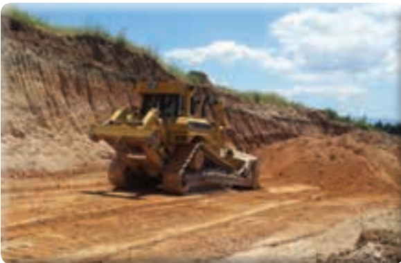
Beyazevler Mahallesi 548/2 Sokağın açılması işi
