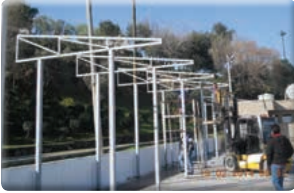
Sevgi Mahallesi Pazaryeri ızgaralar ve çatı kaplaması işi
