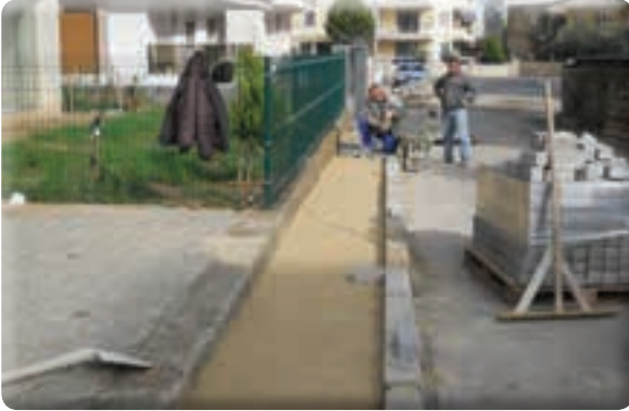
Gazi Mahallesi 28/15 Sokak kaldırım yapımı işi
