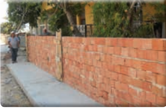
9 Eylül Mahallesi 351 Sokak kaldırım ve bahçe duvarı yapımı işi
