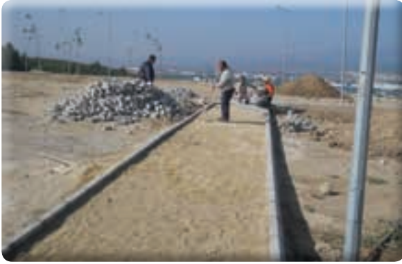
Menderes Mahallesi Seyir Terası taş tamirati
