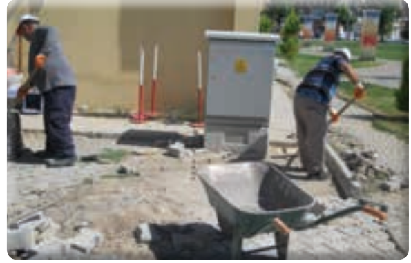
Atıfbey Mahallesi Esbaş Spor Salonu taş tamirâtı işi
