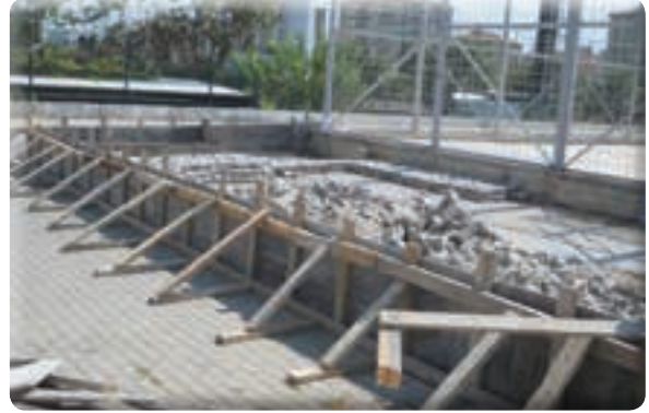
Atıfbey Mahallesi Esbaş Futbol Sahası Tel çit ve tuvalet yapımı
