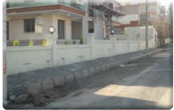
Irmak mahallesi 98 sokak ve 99/4 sokaklar kaldırım yapımı işi
