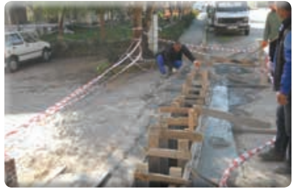
Yeşil Mahalle 59 Sokak ızgara yapımı işi
