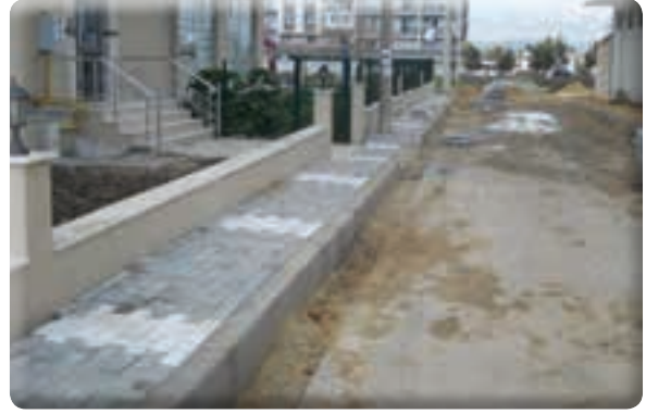
Beyazevler Mahallesi 538 Sokak kaldırım çalışması
