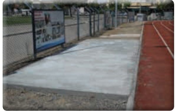
Atıfbey Mahallesi Esbaş Futbol Sahası beton işleri
