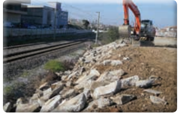
9 Eylül Mahallesi 351 sokak demiryolu yanı dolgu yapılması işi
