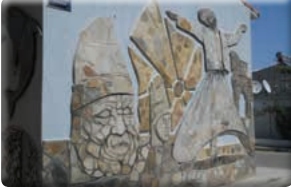
Hürriyet Mahallesi Plevne Caddesi Trafo kayrak kaplama işi
