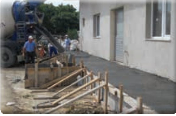
Sevgi Mahallesi Hayvan Barınağı çevre düzenlemesi işi
