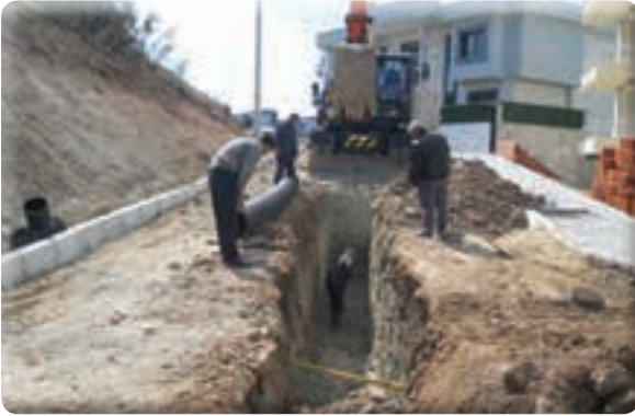
Beyazevler Mahallesi 547 Sokak kanal döşenmesi işi
