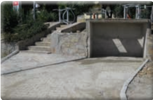
9 Eylül Mahallesi Nasır sitesi Kapalı çöp konteynır cebi yapımı işi
