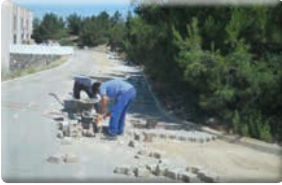
Beyazevler Mahallesi 556 Sokak taş tamiri işi
