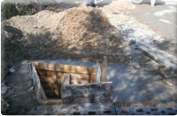
Yeşil Mahalle 40 Sokak ızgara yapımı işi
