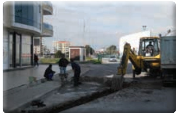
Gazikent Mahallesi 681 Sokak Izgara yapımı işi
