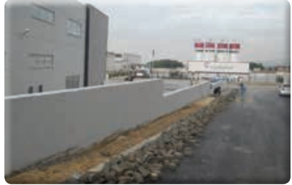
Fatih Mahallesi 1208 Sokak kaldırım çalışması
