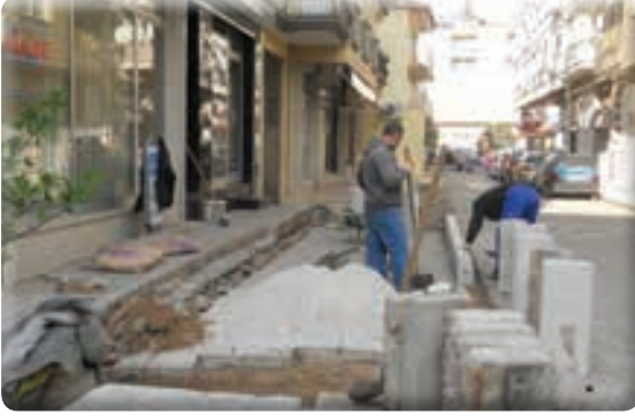
Atıfbey Mahallesi 1 Sokak kaldırım çalışması
