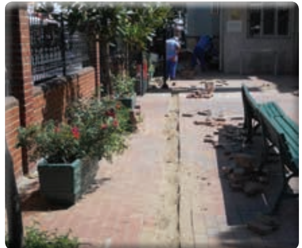
Gaziemir Merkez Camii taş tamiratı ve döşeme işleri
