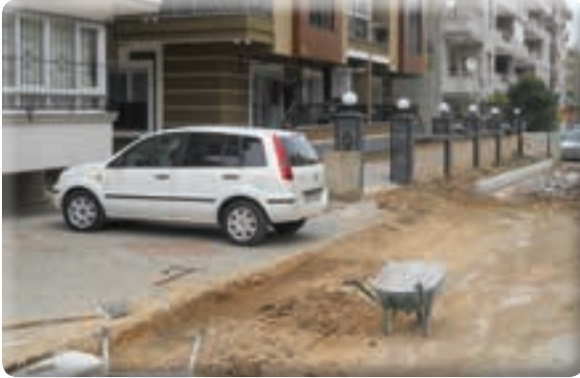
Gazi Mahallesi 27 Sokak kaldırım yapılması işi
