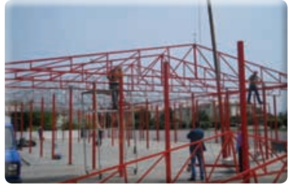
Sevgi Mahallesi Pazaryeri çatı kapatılması işi
