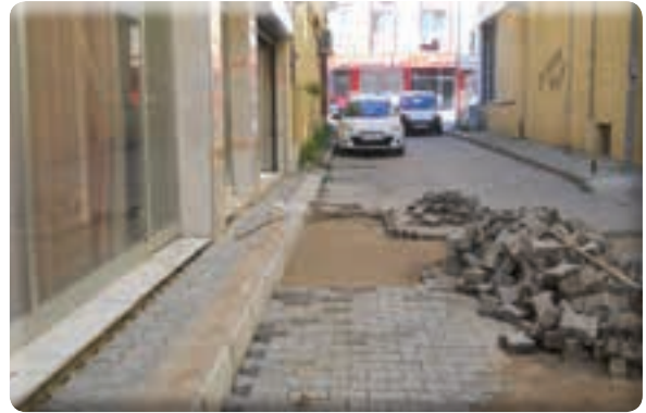
Atıfbey Mahallesi 10 Sokak kaldırım yapımı ve taş tamiri işi
