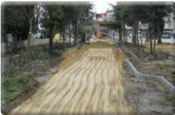
9 Eylül Mahallesi 4. Etap Sevgi Yolu yenileme çalışmaları
