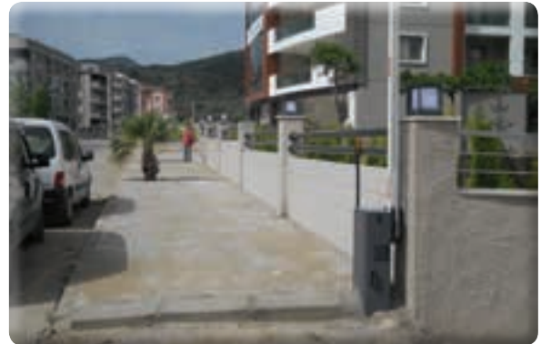
Irmak Mahallesi 38/2 Sokak kaldırım yapılması işi
