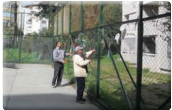
Gazikent Mahallesi Muhtarlık yanı Basketbol Sahası tel örgü tamirleri
