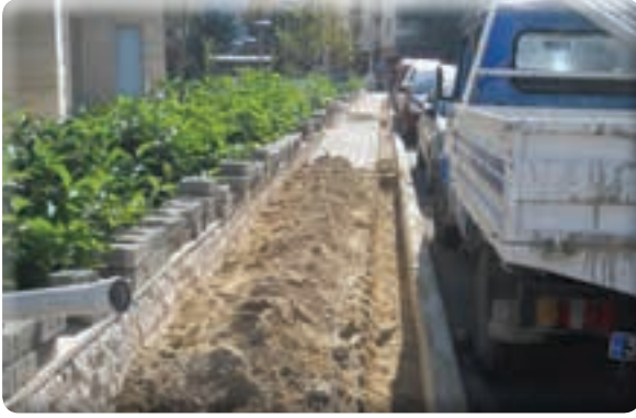
Gazi Mahallesi 16 Sokak kaldırım yapımı
