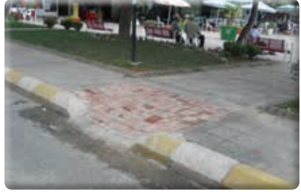
Yeşil Mahalle Abdullah Arda Meydanı taş tamaratı işi
