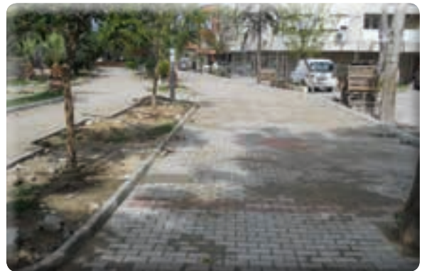
9 Eylül Mahallesi 4. Etap Sevgi Yolu yenileme çalışmaları
