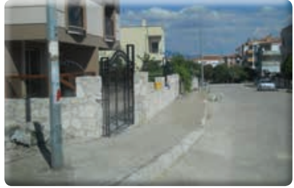
Yeşil Mahalle 40/3 Sokak kaldırım yapımı işi
