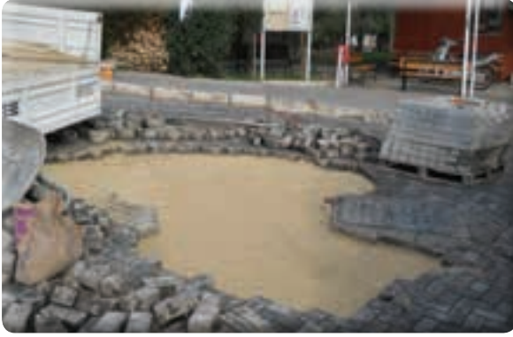
Sevgi Mahallesi Pazar yeri girişi taş tamiratı işi
