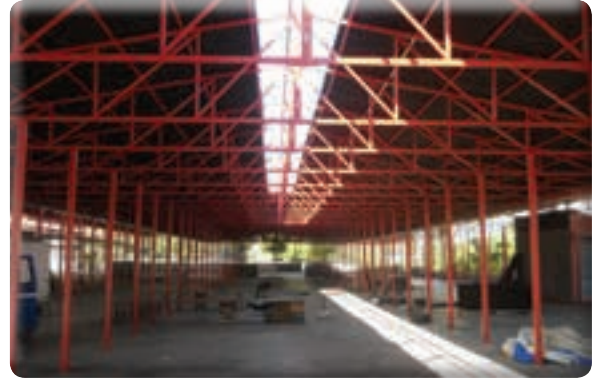
Sevgi Mahallesi Pazaryeri çatı kapatılması işi
