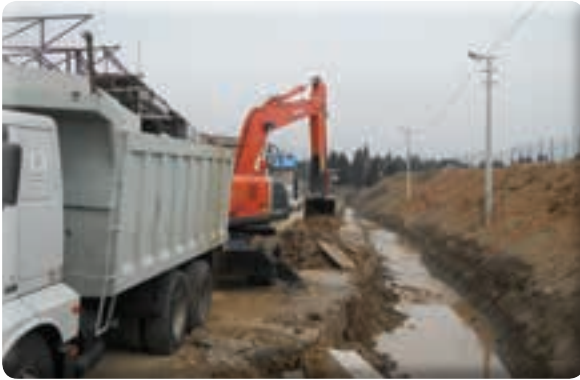
9 Eylül Mahallesi 695 sokak kanal çalışması
