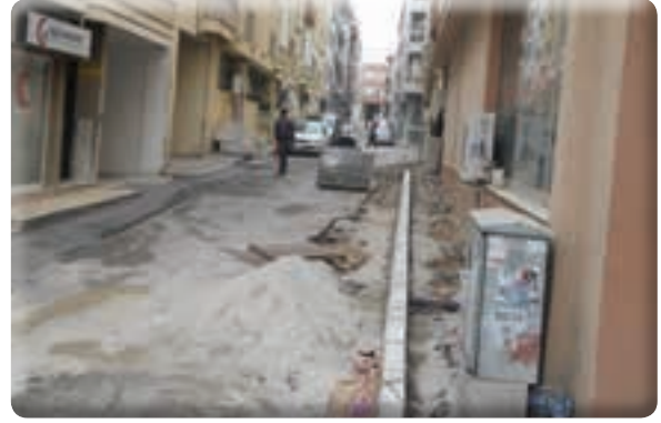
Yeşil Mahalle 48/1 Sokak kaldırım çalışması
