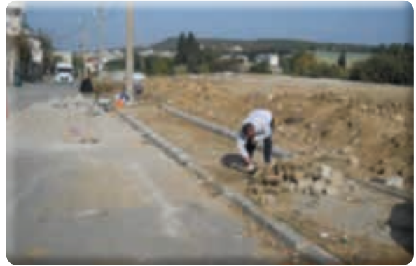
9 Eylül Mahallesi 352 Sokak kaldırım yapımı
