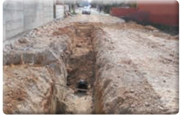
Beyazevler Mahallesi 547 Sokak kanal döşenmesi ve dolgu işlemi
