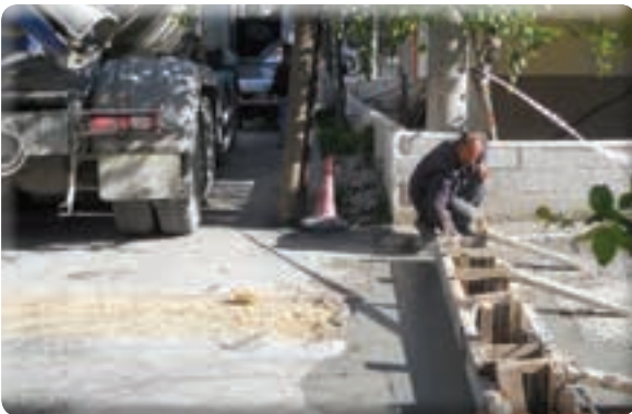
Gazi mahallesi 28/3 sokak yağmur ızgarası yapımı
