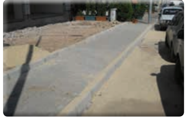
Gazi Mahallesi Kubilay Caddesi 16 Sokak kaldırım yapımı
