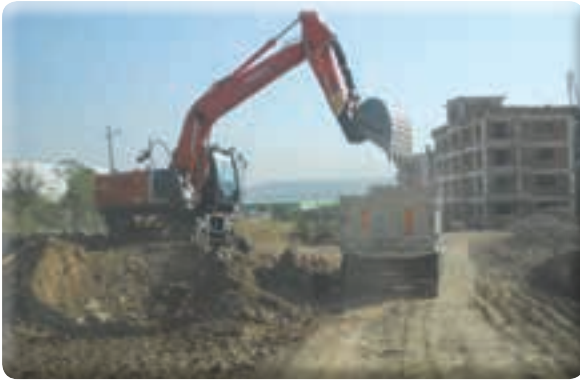
Irmak Mahallesi 38/16 Sokağın açılması işi
