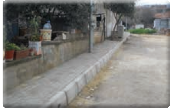
Yeşil Mahalle 46/1 Sokak , 46/2 Sokak ve 53 sokaklarda kaldırım yapımı işi
