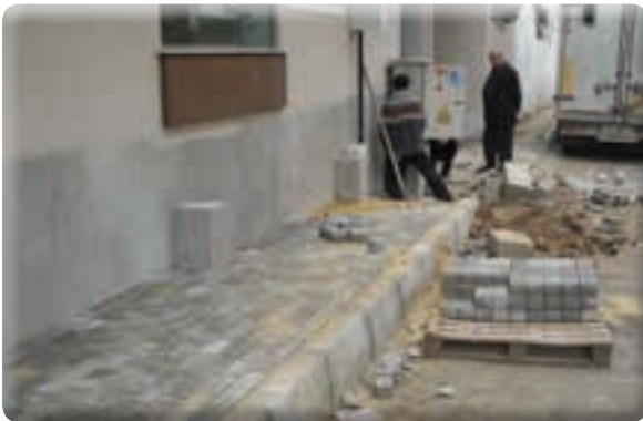
Yeşil mahalle 53 Sokak kaldırım çalışması
