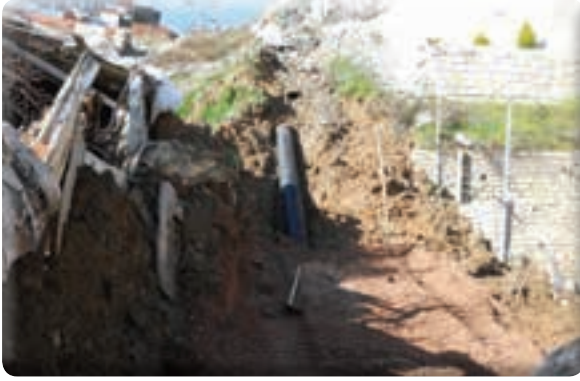
9 Eylül Mahallesi 367 Sokak kanal yapımı
