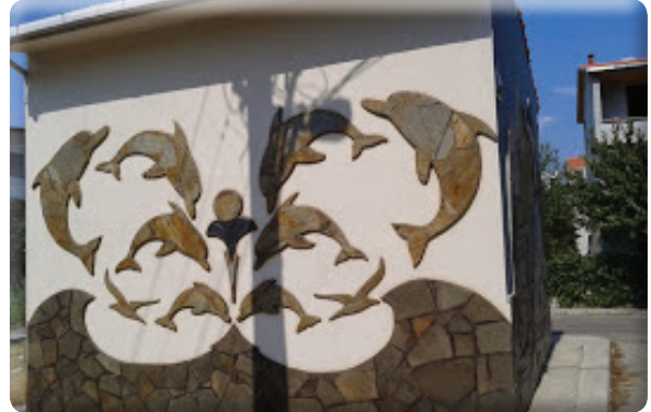
Sarnıç Plevne Caddesi Trafo Kayrak Çalışması
