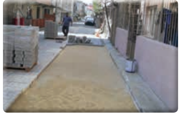
Hürriyet Mahallesi 1067 Sokak taş tamaratı işi
