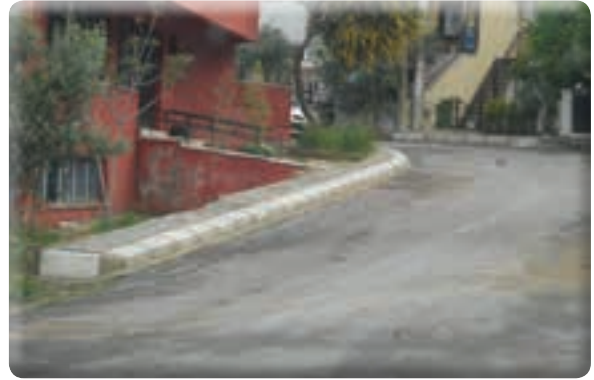
Beyazevler mahallesi 545 sokak kaldırım yapımı işi
