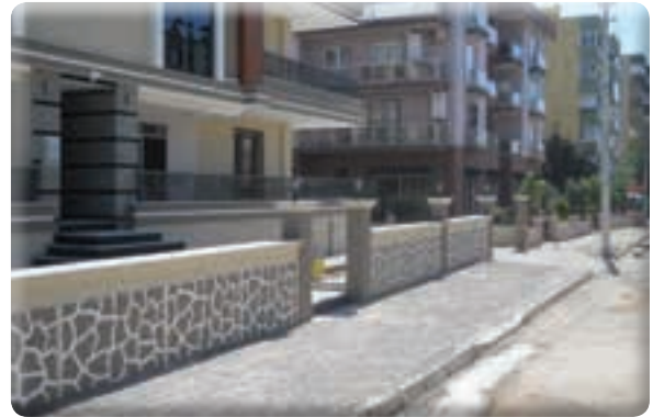
Irmak Mahallesi 93 Sokak kaldırım yapımı işi
