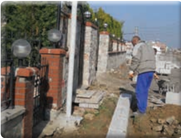
9 Eylül Mahallesi 347 sokak kaldırım çalışması
