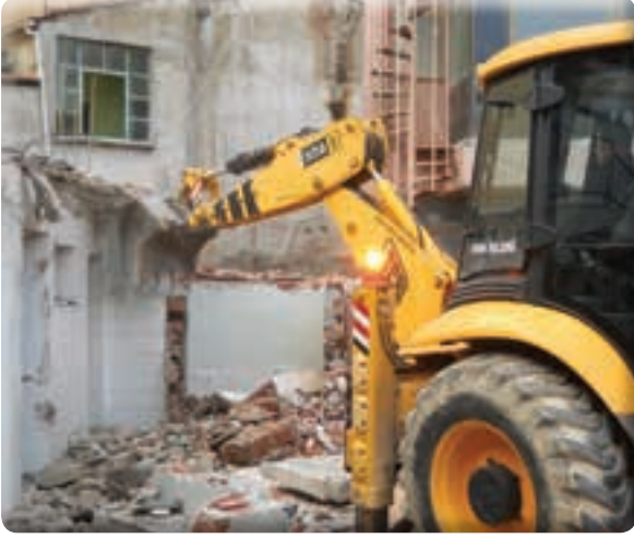
Gaziemir Merkez Camii tuvaleti yıkımı işi
