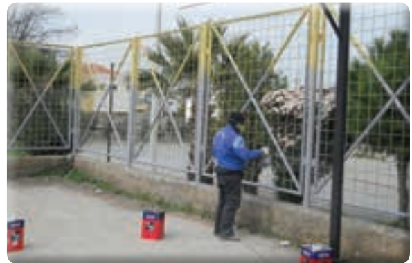
Beyazevler Mahallesi Basketbol sahası tamirat ve boya işleri
