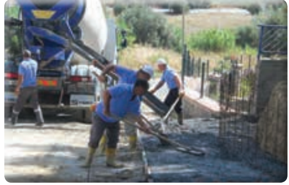
Zafer Mahallesi 803 Sokak kaldırım ve istinat duvarı yapımı
