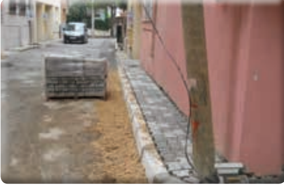
Irmak Mahallesi 38/6 Sokak kaldırım yapımı işi
