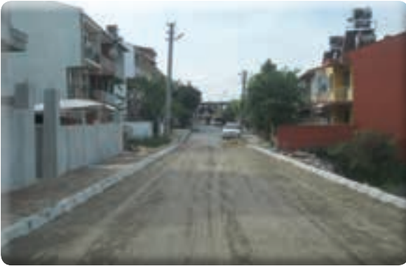
Beyazevler Mahallesi 547 Sokak açılması bordür ve taş döşenmesi işi
