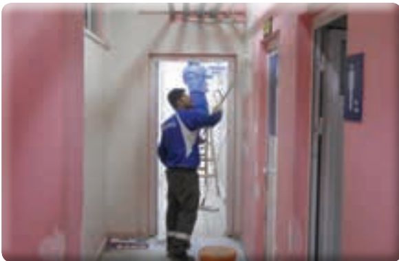
Atıfbey Mahallesi Ahmet Taner Kışlalı Spor Salonu boya işleri
