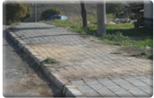
9 Eylül Mahallesi Nazım Hikmet Parkı kaldırım tamaratı
