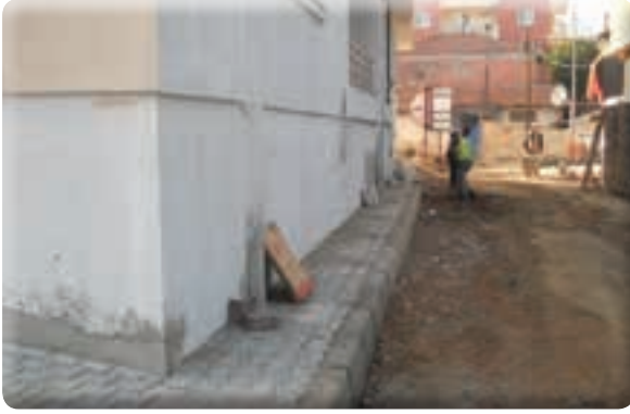
Irmak Mahallesi 34 ve 34/4 sokaklarda kaldırım yapımı işi
