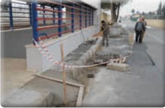
9 Eylül Mahallesi 351 Sokak kaldırım yapımı işi
