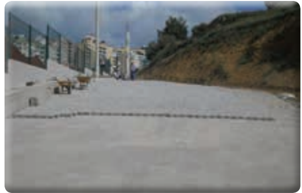
Zafer Mahallesi 813 Sokağın açılması ve taş döşeme işi
