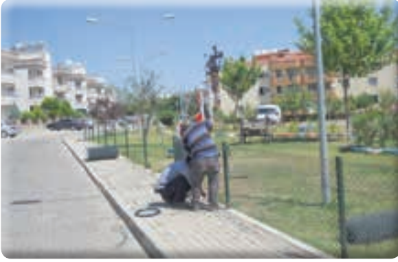
Yeşil Mahalle Hasan Toyun Parkının tel çit ile çevrilmesi işi
