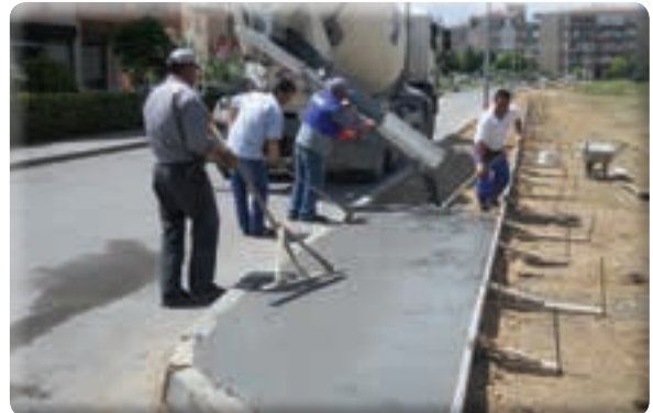
Gazi Mahallesi 28/27 Sokak kaldırım yapımı işi
