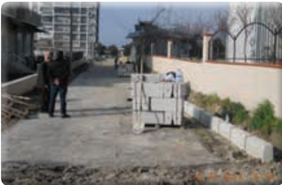
Beyazevler Mahallesi 538 Sokak kaldırım yapımı işi
