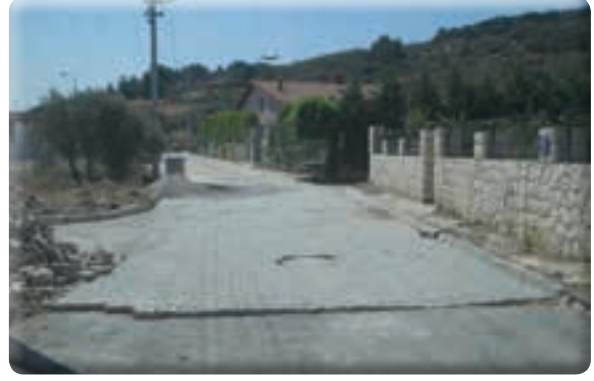
Yeşil Mahalle 40/5 Sokak taş tamirâtı işi
