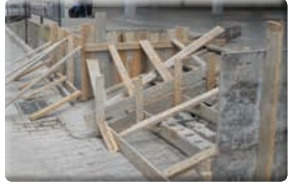
Atıfbey Mahallesi Merkez Pazar yeri rampa ve korkuluk yapımı işi
