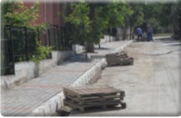
Beyazevler Mahallesi 518-539-541-542 Sokak kaldırım yenileme işi
