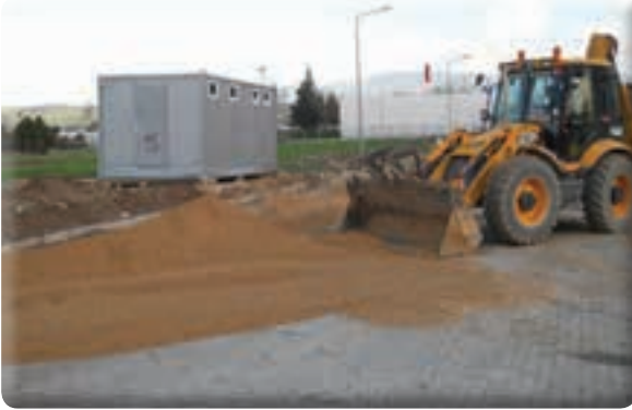
Atıfbey Mahallesi 680 Sokak taş tamirâtı
