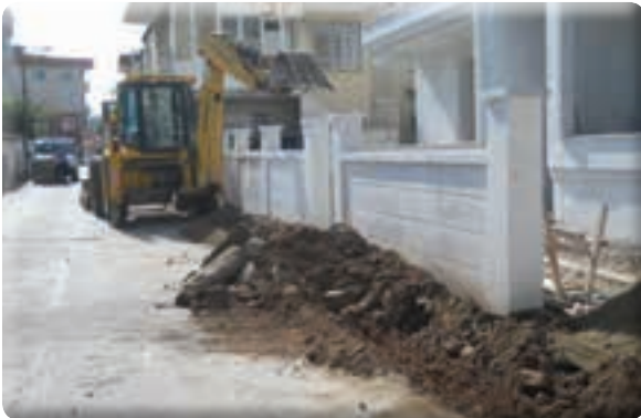
Irmak Mahallesi 23 Sokak kaldırım yapılması işi
