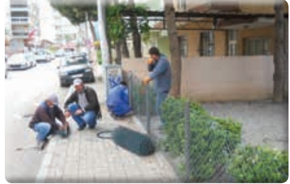
Gazi Mahallesi 25 Sokak parkın tel çitlerinin çekilmesi işi
