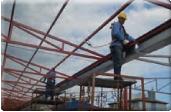
Sevgi Mahallesi Pazar yeri çatı yapılıması işi
