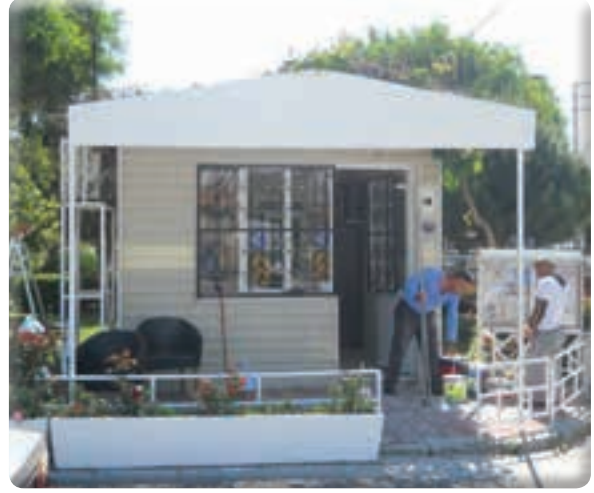
9 Eylül Mahallesi Muhtarlık binası boya işleri
