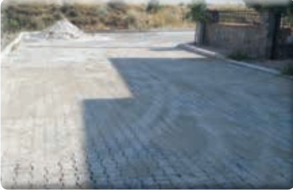
Yeşil Mahalle 40/4 Sokak ve 40/5 Sokak taş tamiri işi
