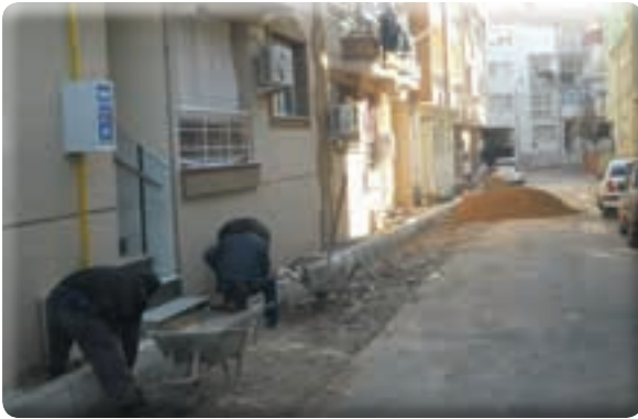
Yeşil Mahalle 55 Sokak kaldırım yapımı işi
