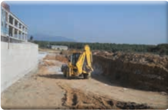
Fatih Mahallesi 1196 Sokağın açılması işi
