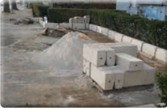
Atıfbey Mahallesi, Atatürk Bulvarı kaldırım çalışması
