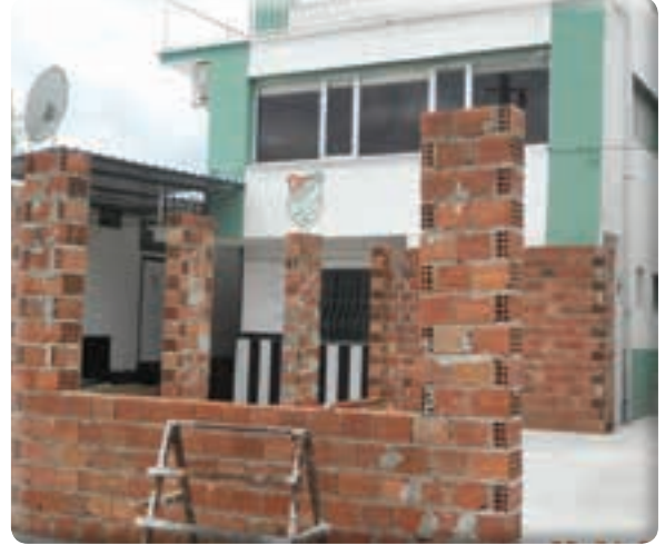
Gaziemir Gücü Spor Tesisi kafeterya yapımı işi
