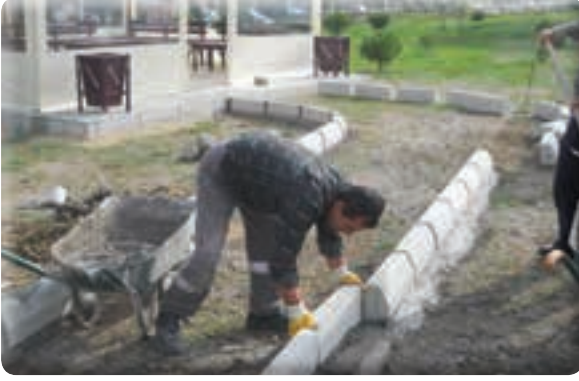
Kipa Lisesi Kamelya betonu, taş bordür ve taş döşeme işleri
