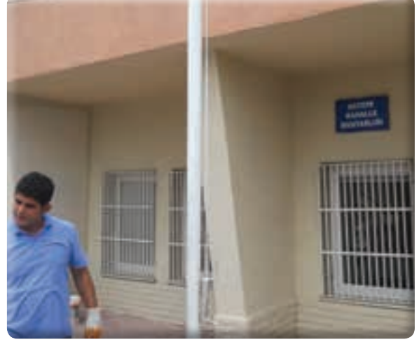
Aktepe Muhtarlık binası boya işleri
