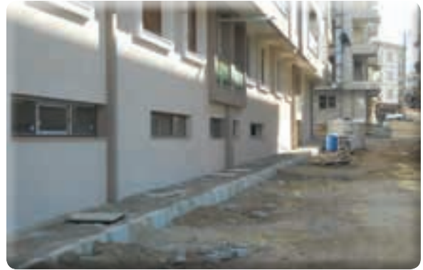
Gazi Mahallesi 19/1 sok 21 sokaklarda kaldırım çalışması
