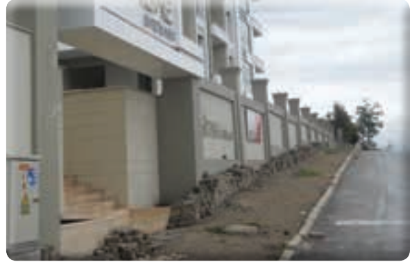
Beyazevler Mahallesi Osman Yüksel Serdengeçti Caddesi kaldırım yapımı işi
