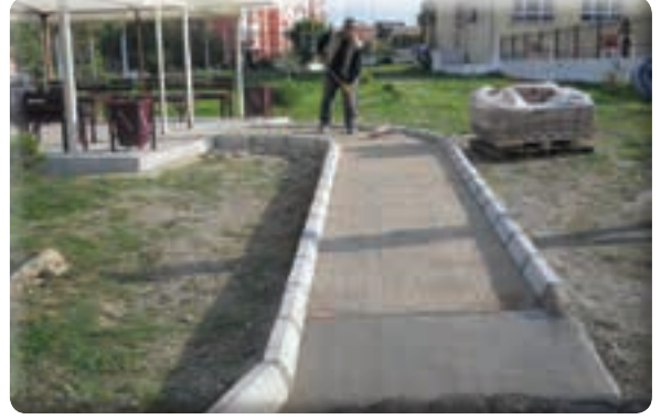
Kipa Lisesi Kamelya betonu, taş bordür ve taş döşeme işleri
