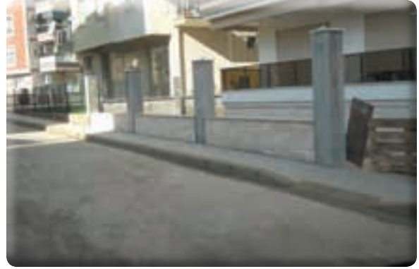
Gazi Mahallesi 28/15 Sokak Kaldırım yapılması işi
