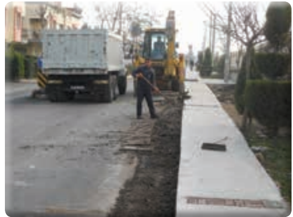
9 Eylül Mahallesi 315 sokak kaldırım çalışması
