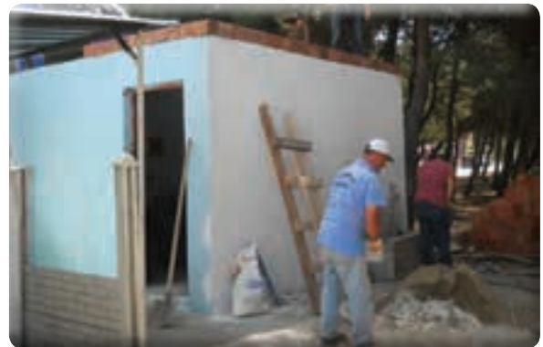
Atatürk Mahallesi Pazaryeri tuvalet yapımı işi
