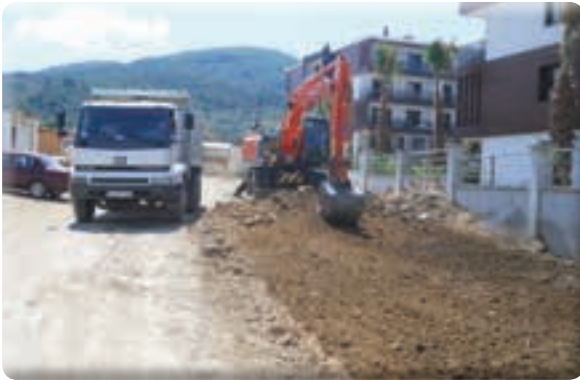
Irmak Mahallesi 38 Sokak hafriyat işleri
