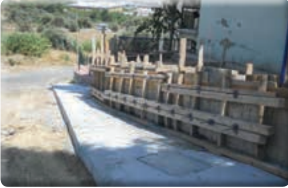
Zafer Mahallesi 803 Sokak Kaldırım ve istinat duvarı yapılması işi
