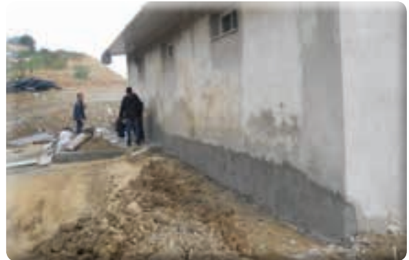
Sevgi Mahallesi hayvan barınağı sıva işleri
