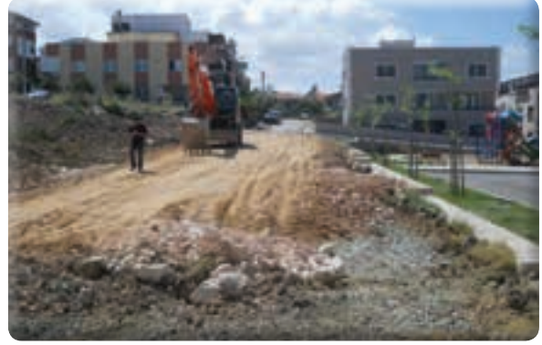
Beyazevler Mahallesi 545 Sokak yol açılması işi
