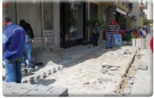
Atıfbey Mahallesi 1 Sokak kaldırım yapımı işi
