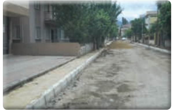
9 Eylül Mahallesi Çiçek Sokak kaldırım yapımı işi
