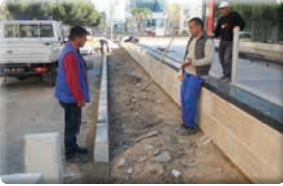
Atıfbey Mahallesi Mertler Caddesi kaldırım çalışması işi
