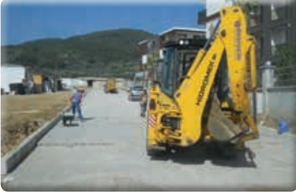
Irmak Mahallesi 711 Sokak taş döşeme işi
