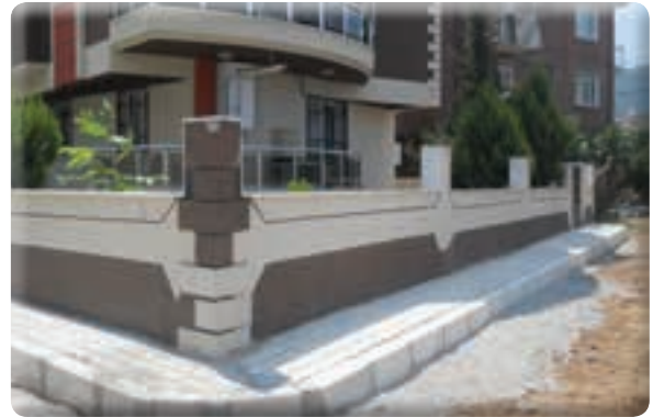
Irmak Mahallesi 91 Sokak ve 93 Sokaklar kaldırım yapımı işi
