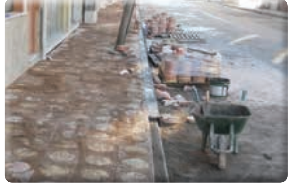
Menderes Mahallesi Menderes Caddesi kaldırım taşı döşeme işi
