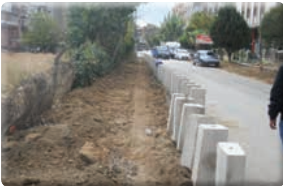
Gazi Mahallesi Yarbey Refik Cesur Caddesi kaldırım yapımı
