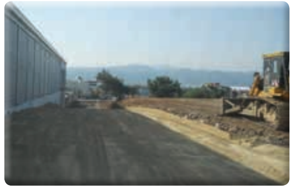
Fatih Mahallesi 1197/1 Sokağın açılması işi
