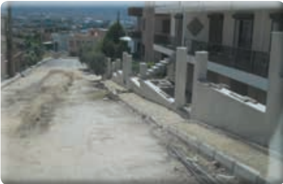
Beyazevler Mahallesi 548/1 Sokak kaldırım yapımı işi
