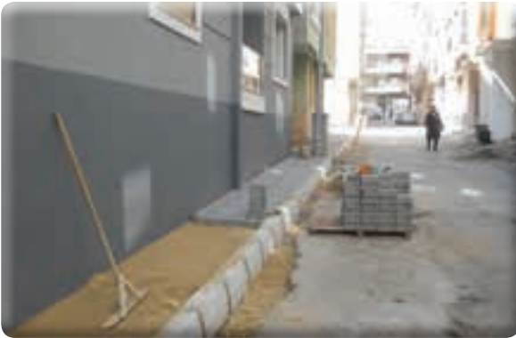
Yeşil Mahalle 47 Sokak kaldırım yapımı işi
