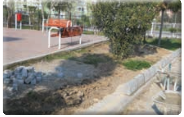
Kipa Lisesi Kamelya betonu, taş bordür ve taş döşeme işleri
