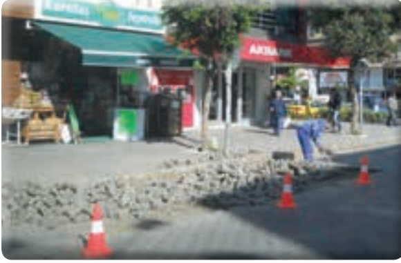
Gazi Mahallesi Önder Caddesi Taş tamiri
