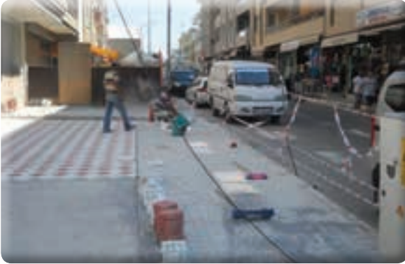
Atıfbey Mah. 6 Sok. Çolak Molla Mümin Hoca Sok.kaldırım yapımı
