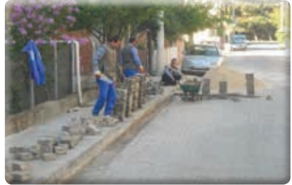
Hürriyet Mahallesi 1078 Sokak taş tamirâtı işi
