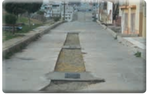
Emrez Mahallesi 201 Sokak ızgara yapımı işi
