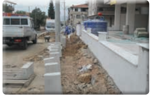
Irmak Mahallesi 38 Sokak kaldırım yapımı işi
