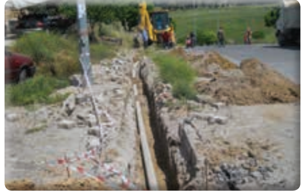
9 Eylül Mahallesi 364 Sokak ızgara yapımı işi
