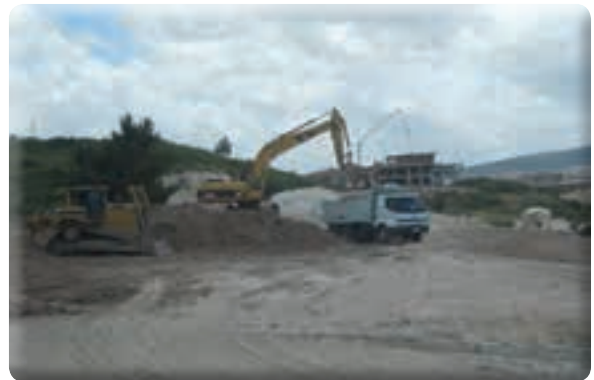
Beyazevler Mahallesi 548 Sokağın açılması işi
