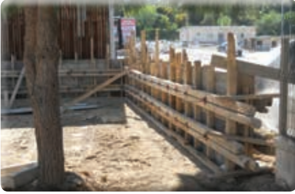
Sevgi Mahallesi Nevvar Salih İşgören Caddesi köpek parkı yapımı işi
