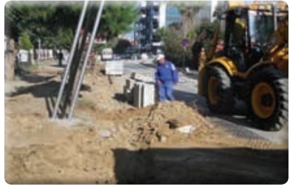
Gazi Mahallesi Yarbay Refik Cesur Caddesi kaldırım yapımı
