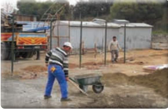
Sevgi Mahallesi hayvan barınağı tel çit çekilmesi işi
