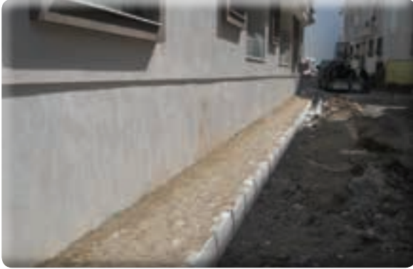
Gazi Mahallesi 21 Sokak kaldırım yapılması işi
