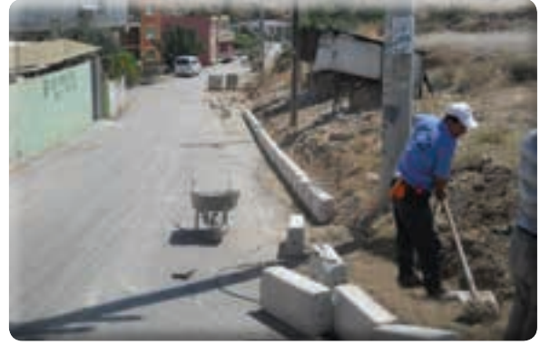
Binbaşı Reşat Bey Mahallesi 351, 377, 376, 384, 382/1 ve 387/1 Sokaklar kaldırım taş tamiri ve beton atılması
