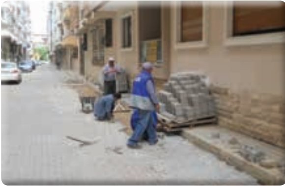
Atıfbey Mahallesi 8 Sokak taş tamiratı işi
