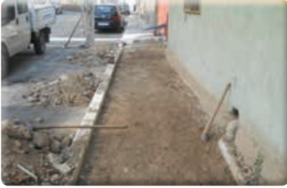
Gazi Mahallesi 21 Sokak kaldırım yapımı
