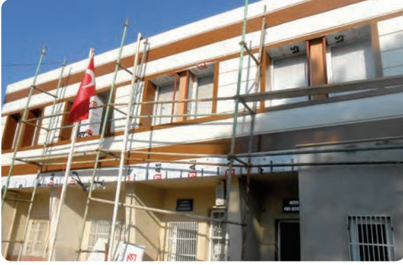
Aktepe Şube binası dış cephe kaplama yapılması işi
