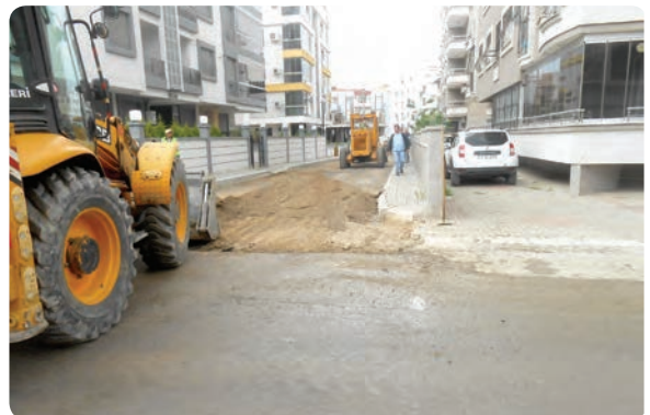
Gazi Mahallesi 25/2 Sokak Büyükşehir belediyesi işbirliği ile asfalt atılması işi
