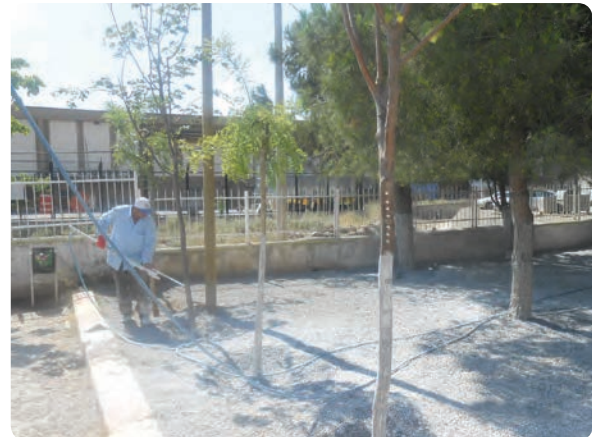
Okulların ve istinat duvarlarının kireçlenmesi işi
