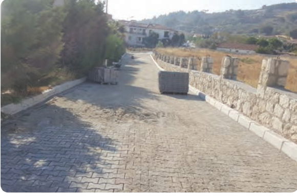
Yeşil Mahalle 40/3 Sokak yol yapım çalışması işi
