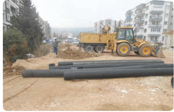
Irmak Mahallesi Ardıçlı Park ile 93 Sokak arası yağmur hattı döşenmesi işi
