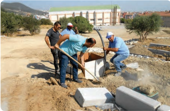
Adalet Tepesi elektrik aydınlatma işlerinin yapılması
