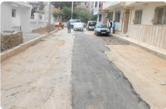
Gazimür genelinde asfaltı yama çalışması
