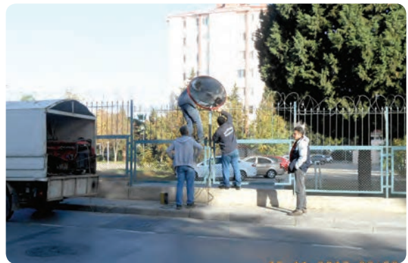
Gazimür genelindeki kavşaklara trafik aynası konulması işi
