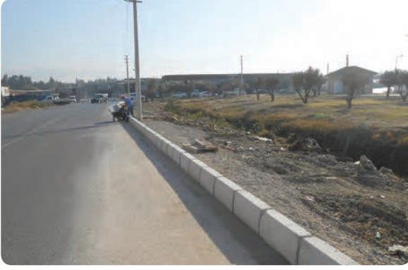
695 Sokak Zeytinli Park bordür döşenmesi işi
