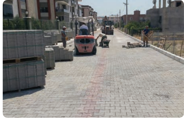
Fatih Mah. 1130 Sokak yol yapılıması işi
