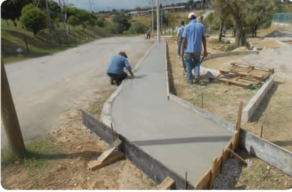
Sevgi Mahallesi 950 Sokak beton kaldırım yapılması işi
