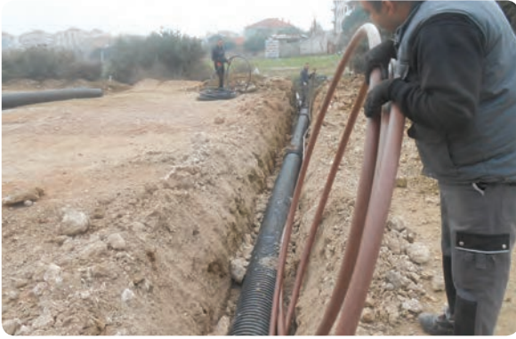
Irmak Mahallesi Ardıçlı Park ile 93 Sokak arası yağmur hattı döşenmesi işi
