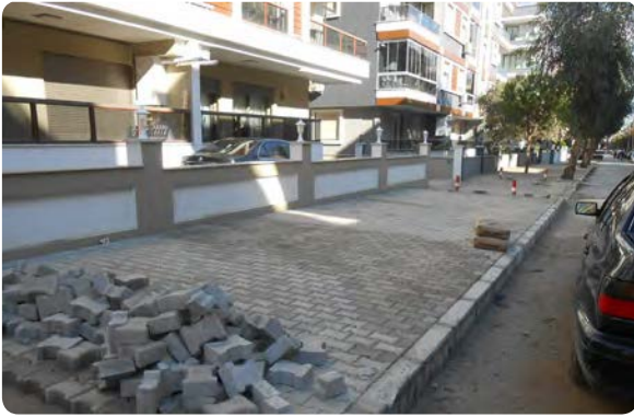
26 Sokak kaldırım yenilenmesi işi
