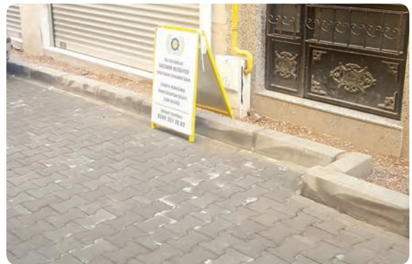
Atıfbey Mahallesi 10 Sokak kaldırım yapılması işi
