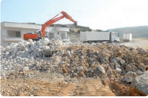
Beyazevler Mahallesi 560 Sokak yol açılması işi
