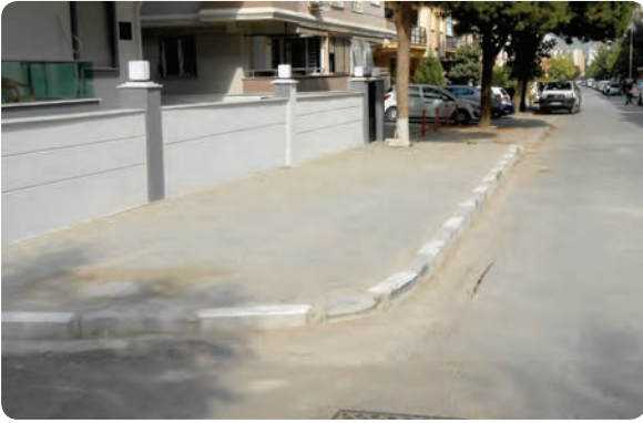
Gazi Mahallesi 26 Sokak kaldırım çalışması işi
