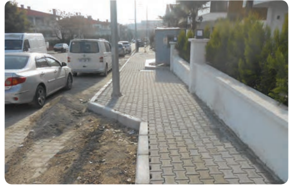
Yeşil Mahalle 55 Sokak kaldırım yapılması işi
