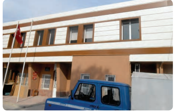
Aktepe Şube binası dış cephe kaplama yapılması işi (iş bitimi)
