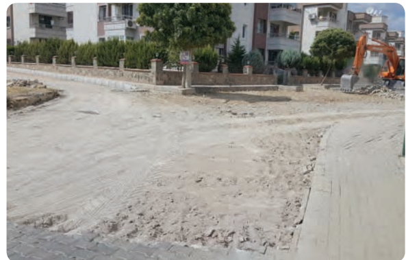
Yeşil Mahalle 57 Sokak yol çalışması işi
