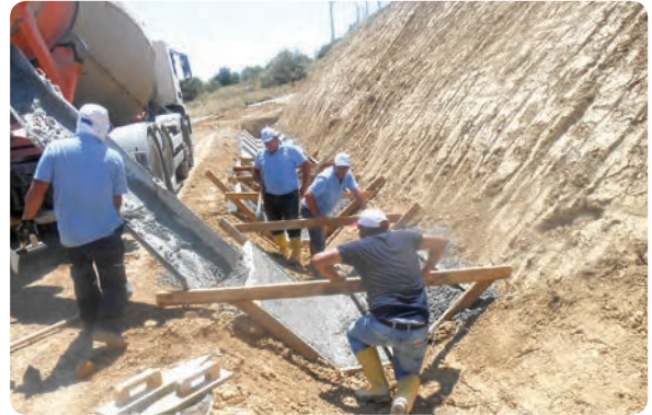
Adalet Tepesi kanal yapılması
