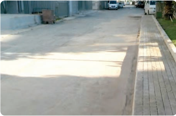
Gazi Mahallesi 28/30 Sokak yol çalışması
