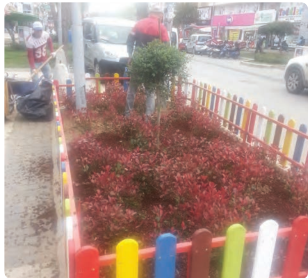
Sevgi Yolu 2. ve 3. Etap ahşap çit uygulaması
