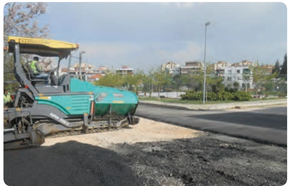
Irmak Mahallesi 98 Sokak asfalt çalışması
