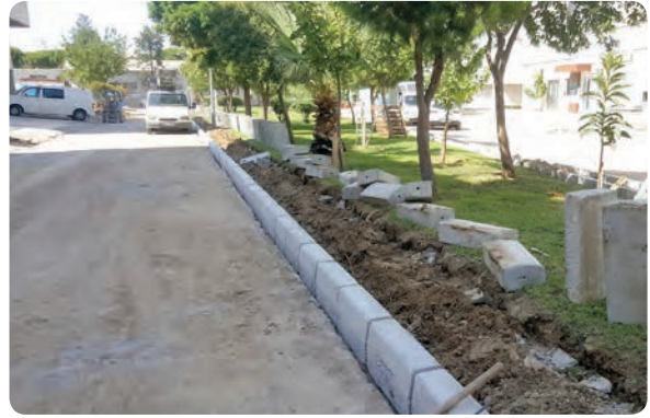
Gazi Mahallesi 28/30 sokak bordür döşenmesi işi
