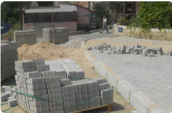
382/2 Sokak kaldırım yapımı işi
