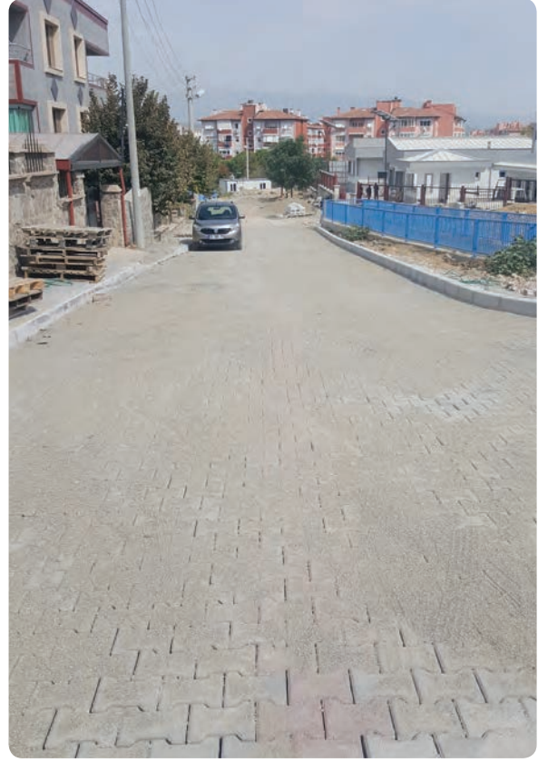
Yeşil Mahalle 40 Sokak yol yapım çalışması işi
