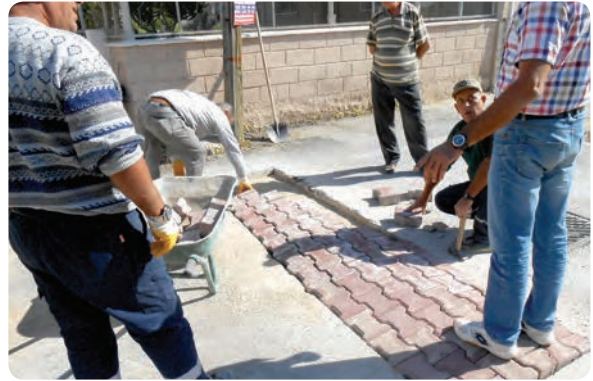
Gazimür geneli araç hız kesici kasıslerin yapılması işi
