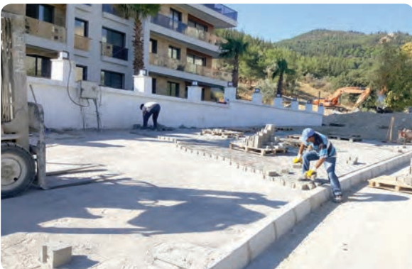
Evka 7 mevki yol çalışması
