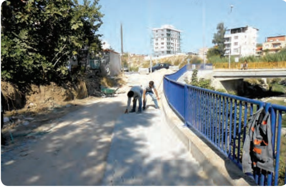
Binbaşı Reşatbey Mahallesi yürüyüş yolu kilit parke döşeme işi
