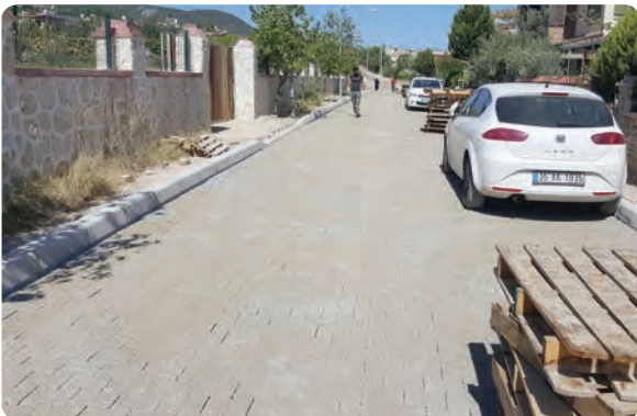
Yeşil Mahalle 40/5 Sokak yol çalışması işi
