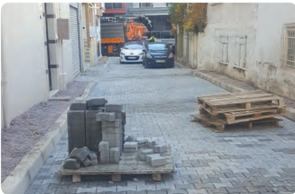
Atıfbey Mahallesi 10 Sokak yol yapılması işi
