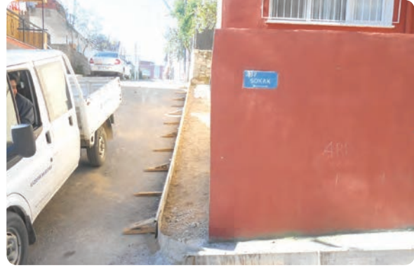
Binbaşı Reşatbey Mahallesi 385-386-387 Sok. beton kaldırım yapımı
