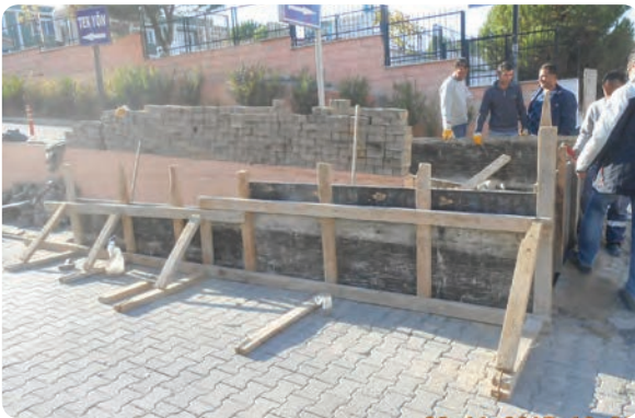
Nevvar Salih İşgören Devlet Hastahanesi engelli rampası yapılması işi
