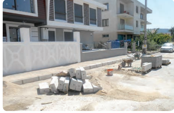
Beyazevler Mahallesi 517 Sokak kaldırım yapımı işi
