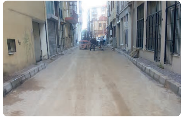
Atıfbey Mahallesi 9 Sokak yol tamiri işi
