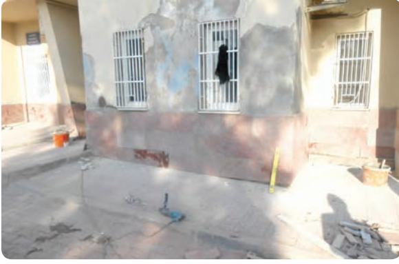
Aktepe Şube binası dış cephe kaplama yapılması işi (başlangıç)
