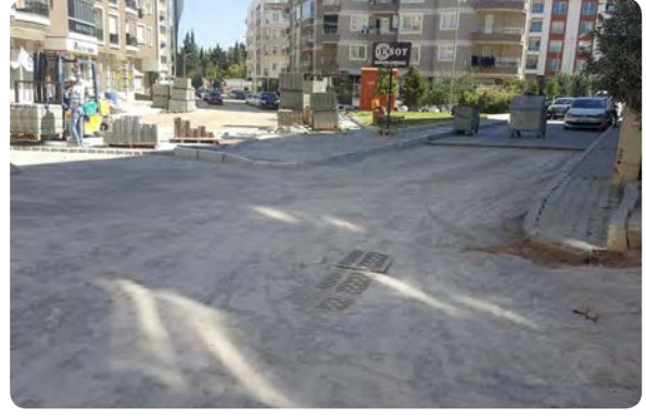
Atıfbey Mahallesi 2 Sokak yol çalışması
