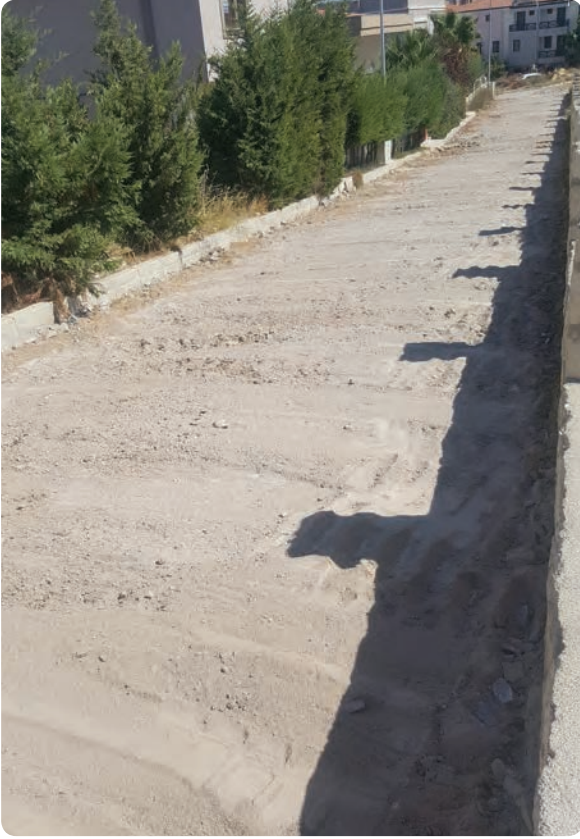
Yeşil Mahalle 40/5 Sokak yol çalışması işi
