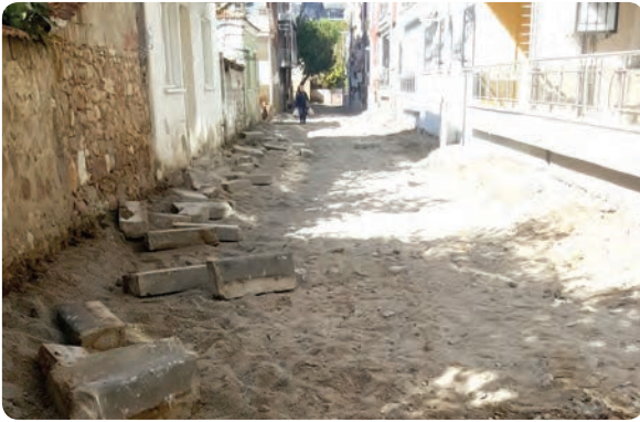
Atıfbey Mahallesi 9 Sokak yol tamiri işi
