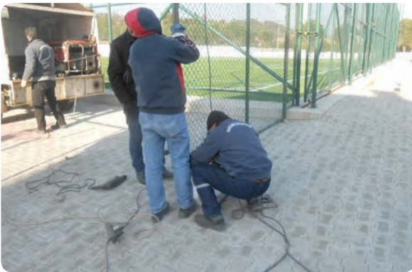
Sevgi Mahallesi Sosyal Konutlar halı saha kapı yapılması işi
