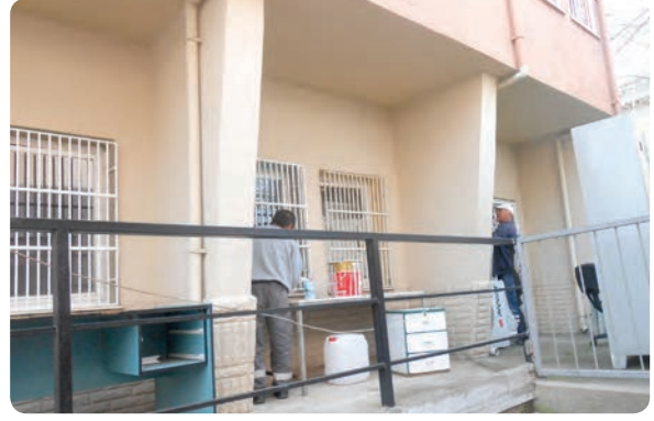
Aktepe Şube binası dış cephe kaplama yapılması işi
