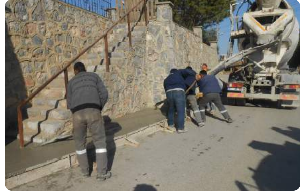
YEŞİL MAH. 40 SOK. KALDIRIM YAPIM İŞİ
