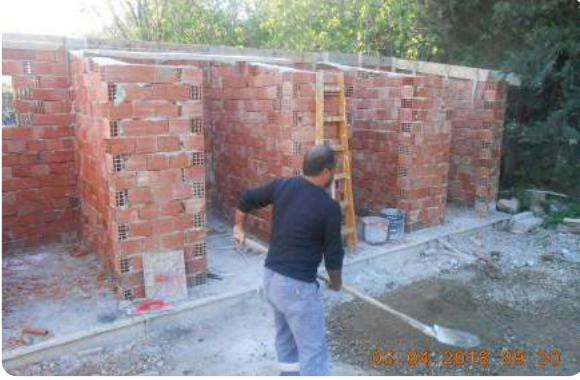
VETERİNERLİK MÜDÜRLÜĞÜ ŞANTIYESİNE HAYVAN BARINAKLARI YAPIM İŞİ
