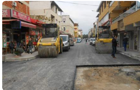
BÜYÜK MENDERES CAD TAŞ SÖKÜMÜ VE ASFATLAMA ÇALIŞMASI
