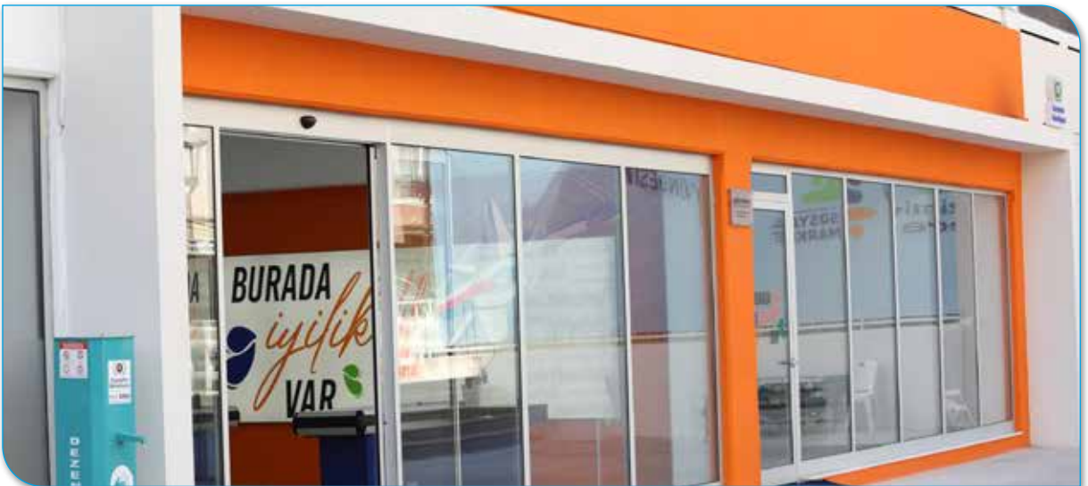
Atıfbey Mahallesi Sosyal Market Yapım İşi
