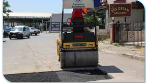
Etiler Caddesi 67 Sokađın Asfalt Yama alıřması
