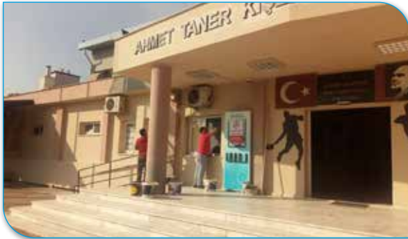
Ahmet Taner Kışlalı Spor Salonu Dış Cephe Boyası Onarımı
