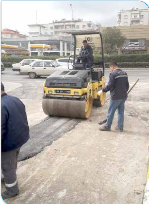
Muhtelif Asfalt Yama Çalışmaları
