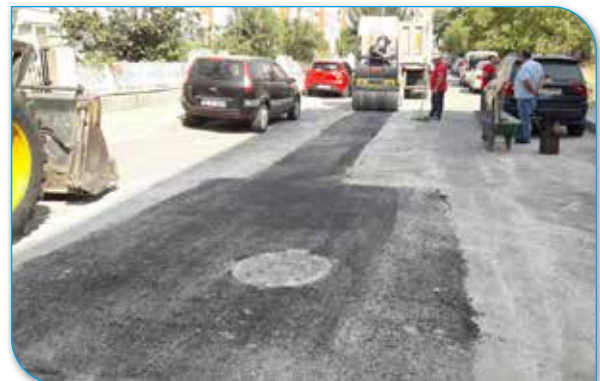
Muhtelif Asfalt Yama Çalışmaları
