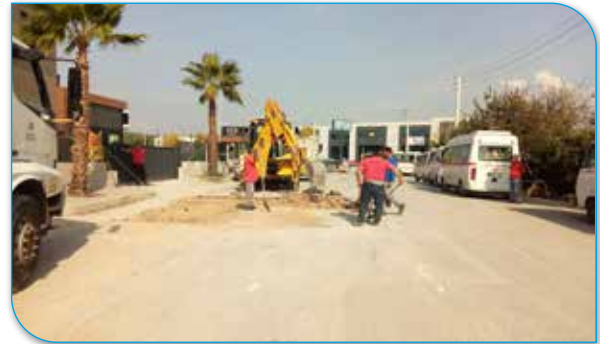
Asfalt Yama Çalışması Öncesi Yol Islahı
