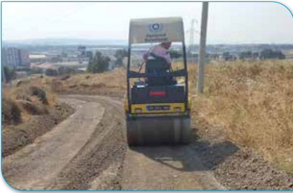
Gaziemir Geneli Toprak Yolların Tesviye ve Düzenleme Çalışmaları
