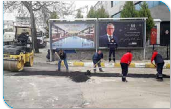
Asfalt Yama Çalışması Öncesi Yol Islahı
