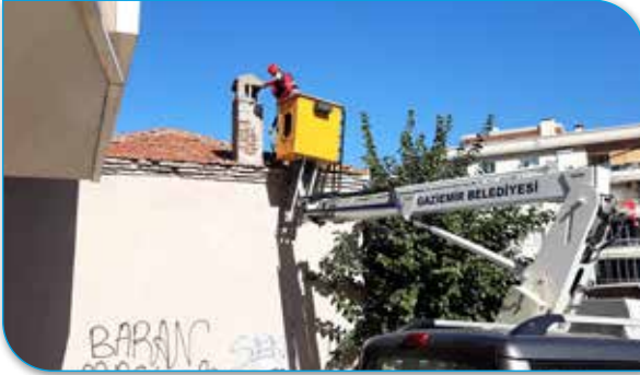
Deprem Sonrası Hasar Görmüş Bacaların Söküm İşi
