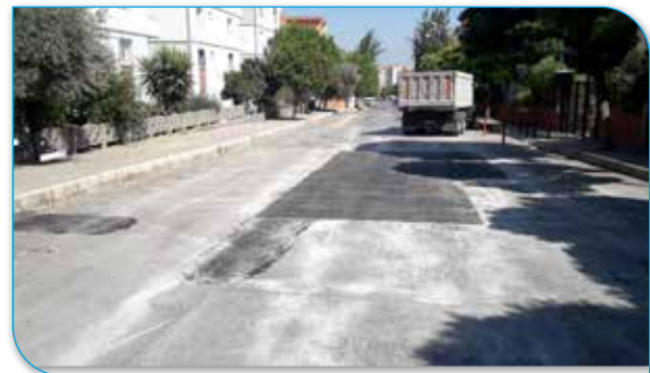
56 Sokak Geneli Asfalt Yama Çalışması
