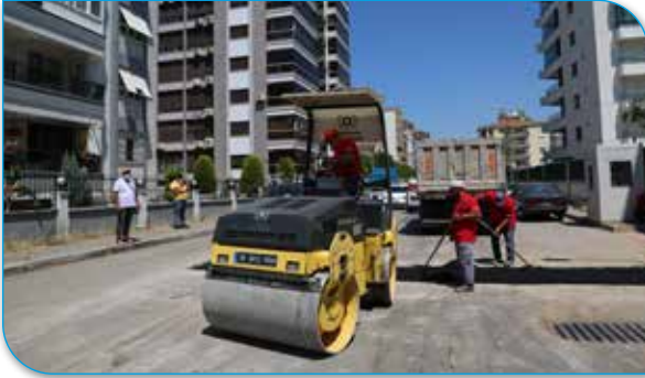
Etiler Caddesi 67 Sokađın Asfalt Yama alıřması
