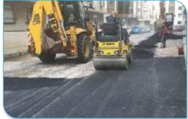
22 Sokak Asphalt Yama Çalışması
