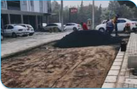
34 Sokak Üçgen Park Çevresi Asphalt Yama Çalışması
