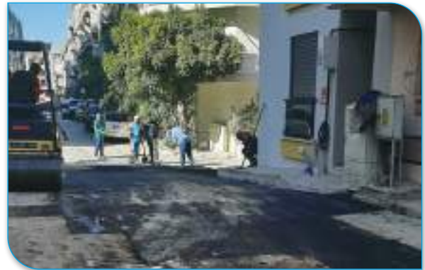
53 Sokak Asfalt Yama Çalışması
