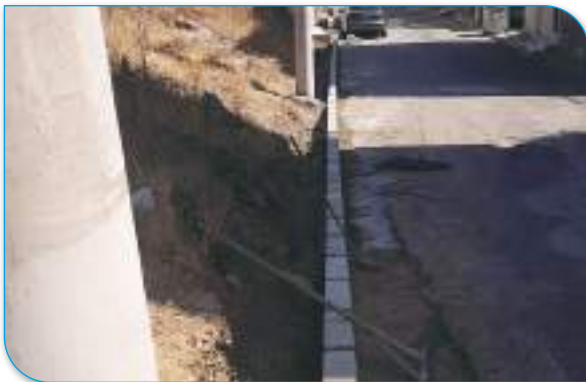
130 Sok. Kaldırım Yenileme İşİ
