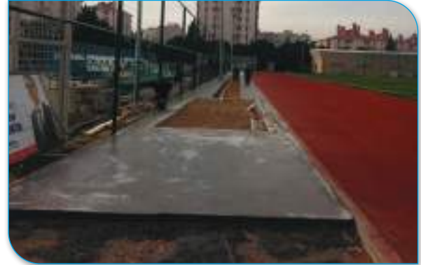
Kum Havuzu Yapımı Çalışması
