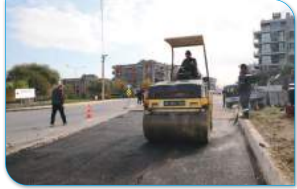
38 Sokak Asfalt Yama Çalışması
