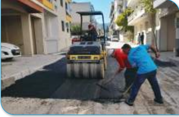
50 Sokak Asphalt Yama Çalışması
