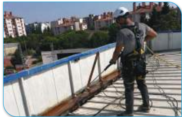
ESBAŞ Spor Salonu Çatı Yenilemesi
