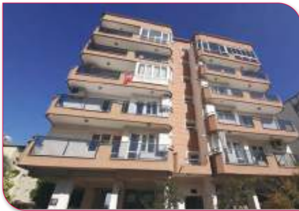
Depremde Zarar Gönen Bina 1126 Ada 15 Parsel - Gazi Mahallesi 28/26 Sokak No:1
