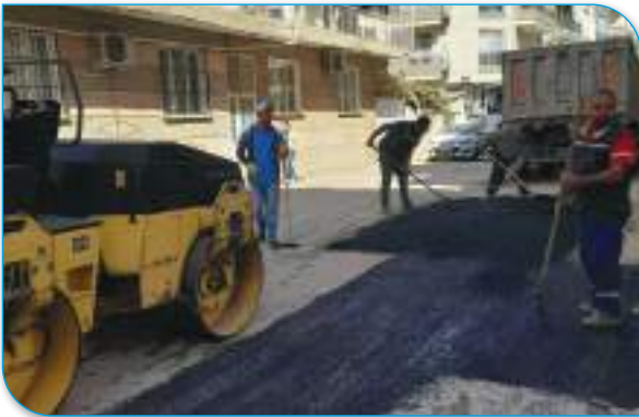
54 Sokak Asfalt Yama Çalışması
