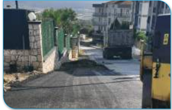
804 Sokak Asphalt Yama Çalışması
