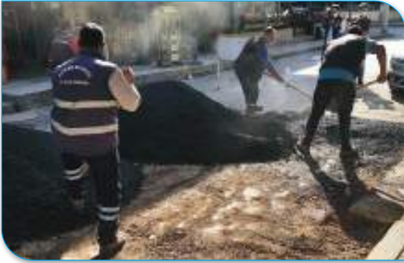
Orhan Gazi Caddesi Asphalt Yama Çalışması
