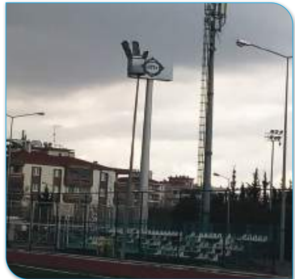
Aydınlatma Direği Yenilenmesi Çalışması
