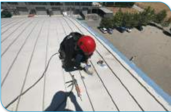
Naim Süleymanoğlu Spor Salonu Çatı Yenilemesi
