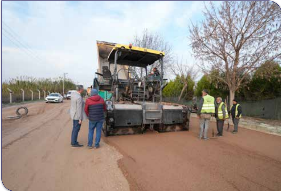
1203 ve 1203/1 Sokaklar Asfalt Yenileme Çalışması
