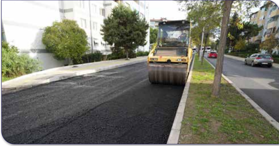
Abdülhamit Yavuz Caddesi Asfalt Yenileme Çalışması
